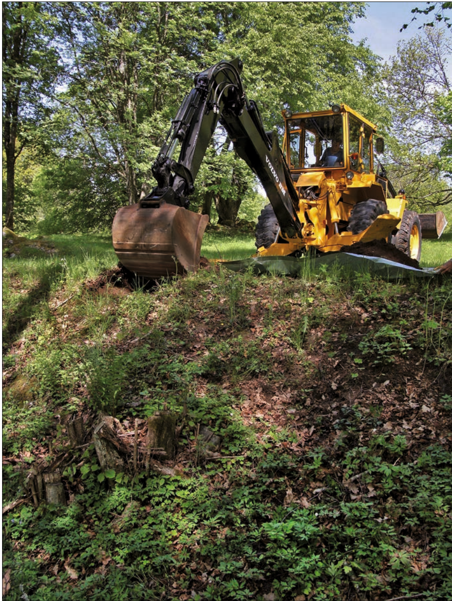
Figur 23. Älmås TK1 strax före genom- grävning.
