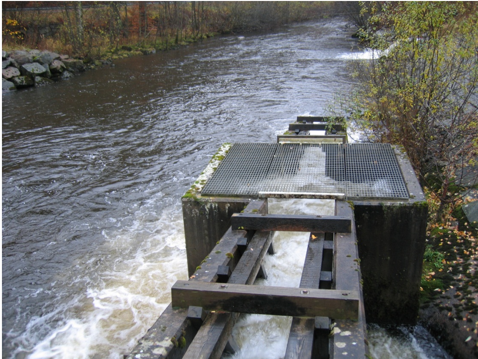
Bild 1. Jonsereds övre fiskväg, en denilrännan, erbjuder fisken en vandringsväg förbi dammen som utgör ett definitivt vandringshinder mellan naturfåran vid Jonsereds kraftverk och sjön Aspen. I fiskvägen finns sedan 2005 en automatisk fiskräknare installerad. Foto: Länsstyrelsen i Västra Götaland.
