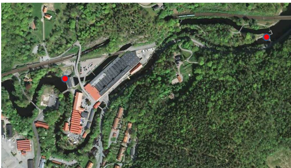
Figur 1. Kraftverket vid Jonsered i Säveån. De två fiskvägarna är markerade med röda prickar (Jonsered's nedre fiskväg till vänster i bild och Jonsered's övre till höger).
