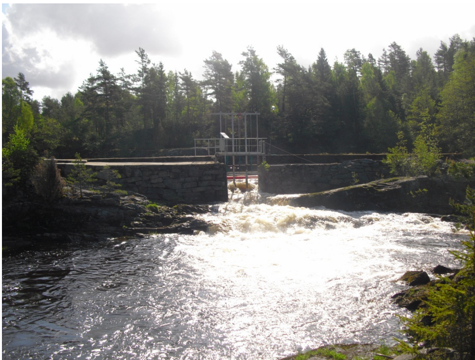
Bild. Mjölnerödsdammen, Enningdalsälven. Fiskräknaren är installerad i ett av dammens utskov. Foto: Daniel Johansson
