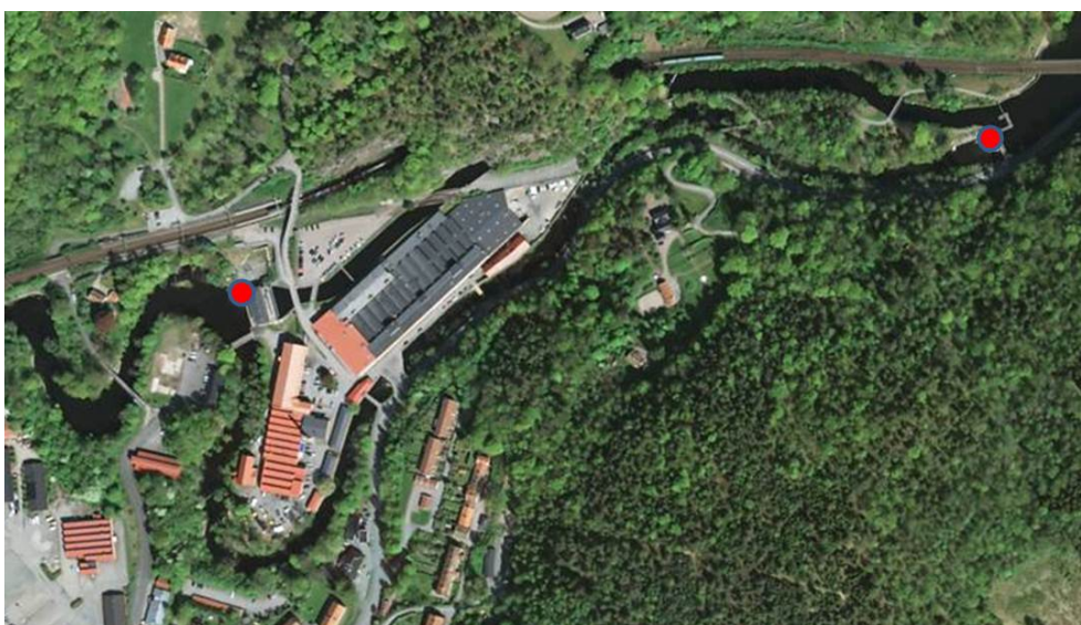
Figur 1. Kraftverket vid Jonsered i Sävån. De två fiskvägarna är markerade med röda prickar (Jonsereds nedre fiskväg till vänster i bild och Jonsereds övre till höger).
