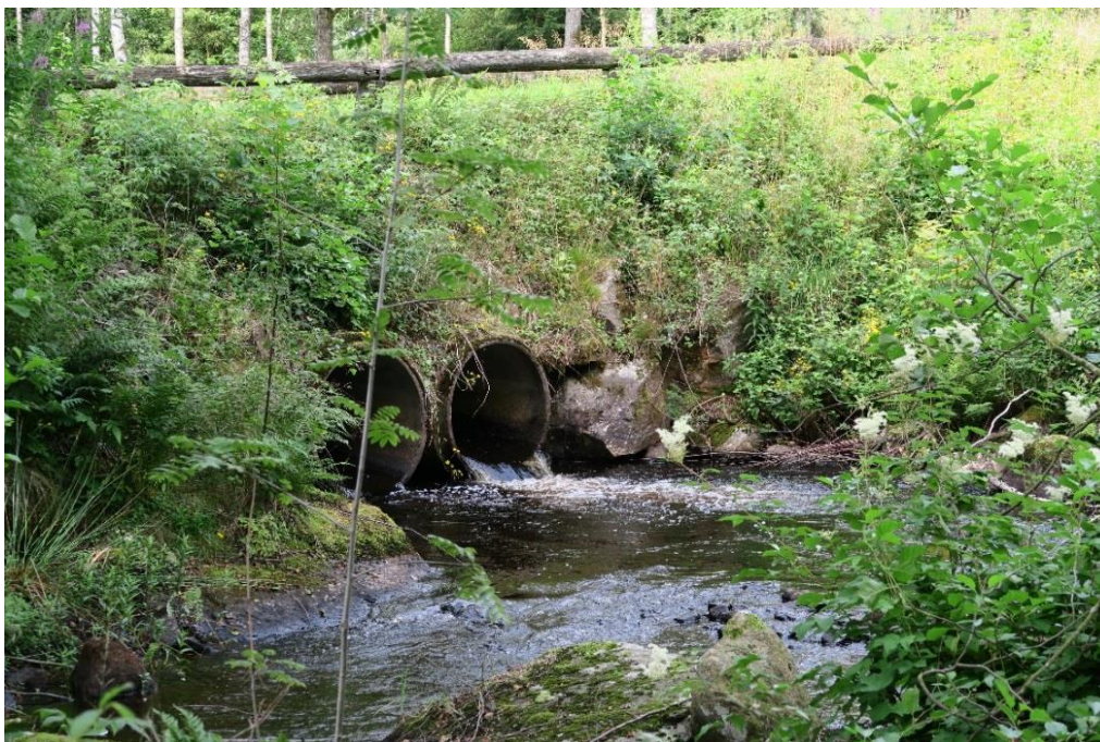
Bild 28. Kvarnabäcken hinder D3, dubbel vägtrumma.
