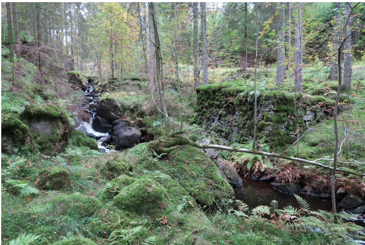
Bild 15. Måbäcken hinder D1. Nedre delen av hindret med sågruinen.
