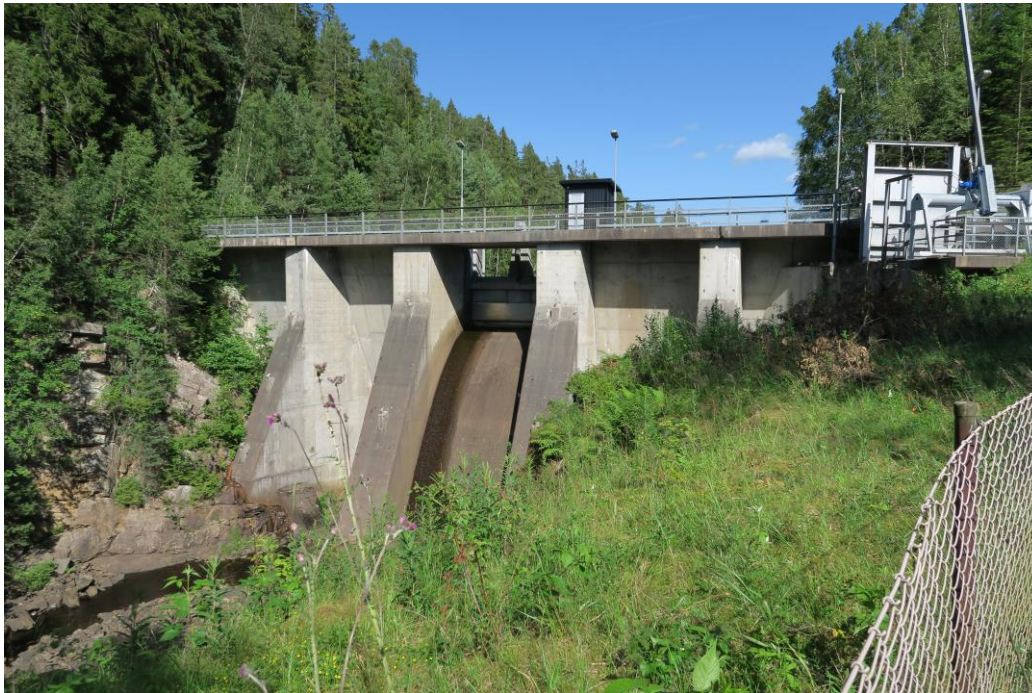
Bild 4. Strömsån hinder D2, Strömma kraftverksdamm.
