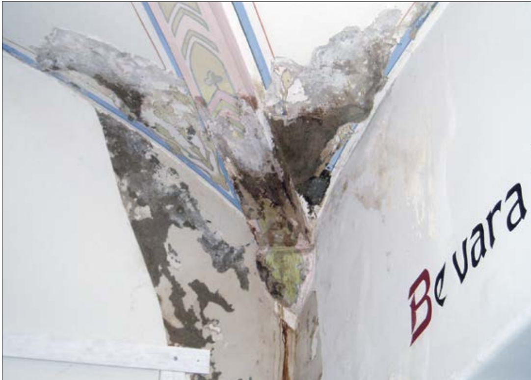
Figur 6.7. Fuktgenomslag i Lysekils kyrka hösten 2006, efter flera veckors kraftig nederbörd. Foto: Tomas Brandt.
