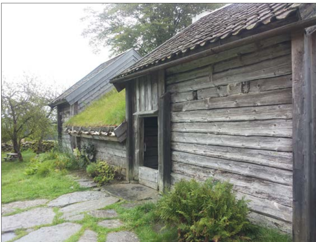
Figur 6.10. En av byggnaderna i Äskhults by. Timmerstommarna är en omistlig del av byggnadskonstruktionen, men är samtidigt del av fasaden. Ett fungerande skalskydd i form av tätt tak, avvattnning och tillräckligt dränerande mark är nödvändigt. Foto: Tomas Brandt, Bohusläns museum.
