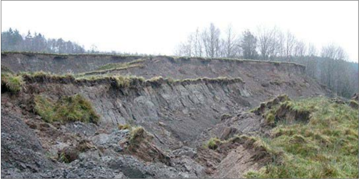
Figur 5.16. Skålskred i finkornig jord. © Sveriges geologiska undersökning Foto: Thomas Eliasson.
