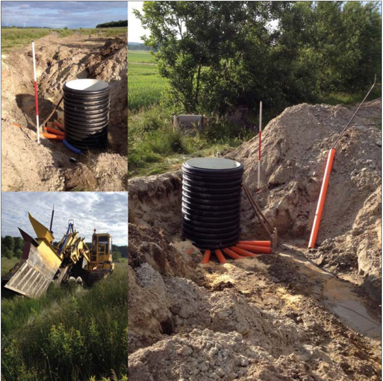
Fig 7.13. Bild på anläggande av dränering i jordbruksmark. Insatserna kräver ofta omfattande markarbete och är inte tillståndspliktiga enligt kulturmiljölagen då de är en del av pågående markanvändning. Foto & bildbearbetning: Leif Häggström
