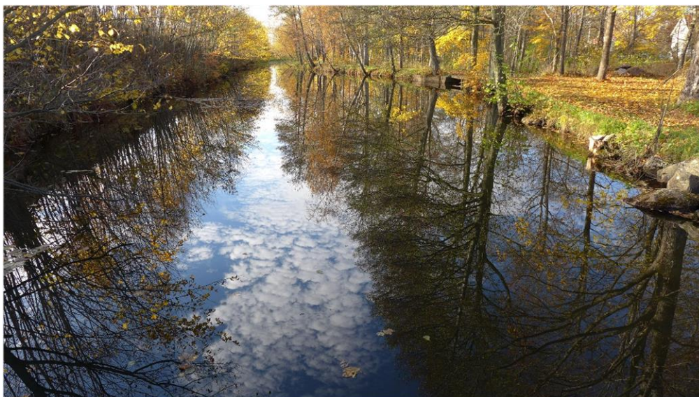
Den långa intagskanalen fram till kraftverket i Herrljunga utgör en del av helhetsmiljön. Stigen till höger om kanalen kallas kärleksstigen och är flitigt utnyttjat område för rekreation.
