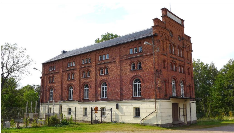
Mariestads stadskvarn uppfördes 1892. Här bedrevs verksamhet fram till 1990-talet men har sedan dess enbart fungerat som kraftverk. Anläggningen bedöms ha ett Mycket högt kulturhistoriskt värde .
