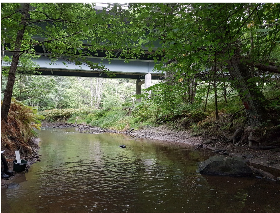
Figur 2. Sträckan under motorvägen (E6) i Bratteforsån.
