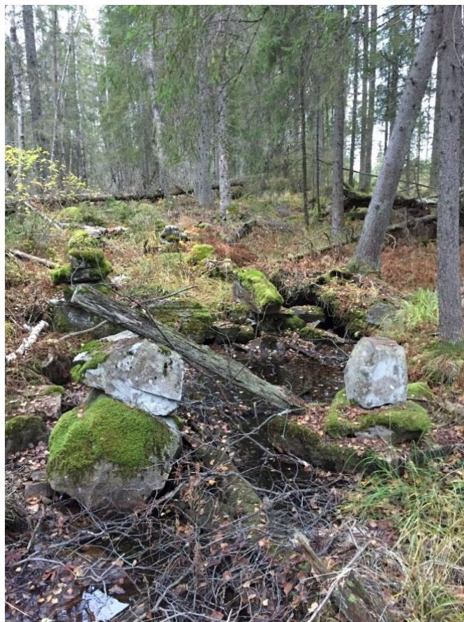
Fundament till flottningsränna i Bärhusälven.
