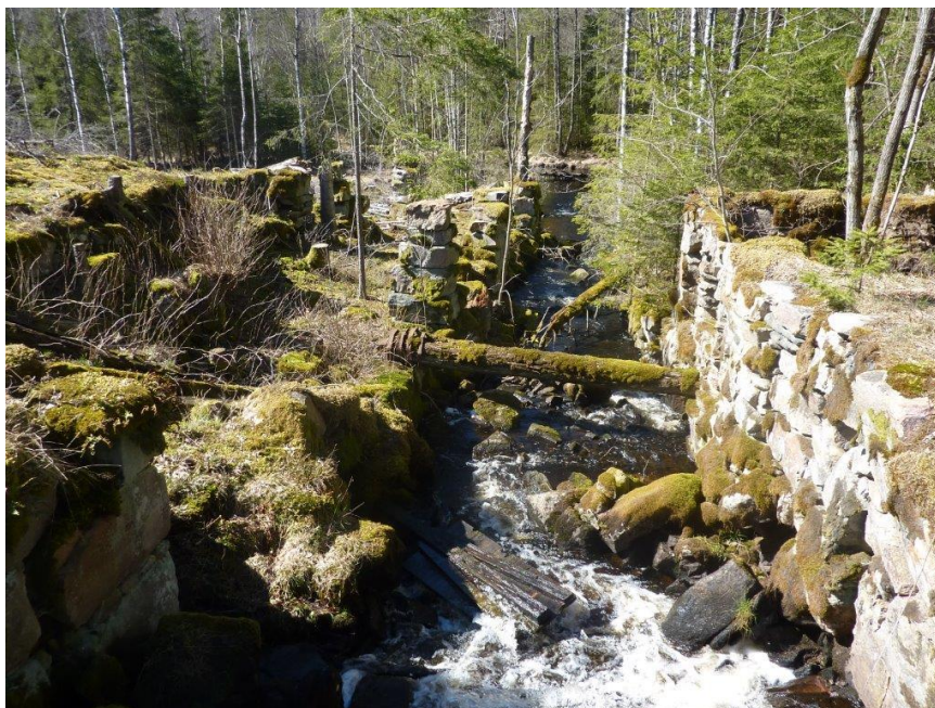
St. Öjahults kvarnruin. Ligger vid Trollsjöån, biflöde till Nissan i Jönköpings län. Foto: Mikael Karlsson.
