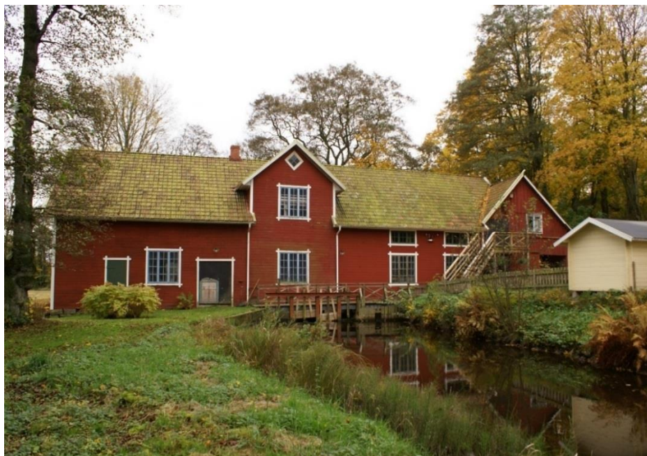
Kvarnmiljön vid Vinberg har troligen medeltida anor. Den nuvarande kvarnbyggnaden är uppförd kring sekelskiftet 1900 och nyttjades som bygdekvarn ända in på 1970-talet. Foto: Anna Rodin.
