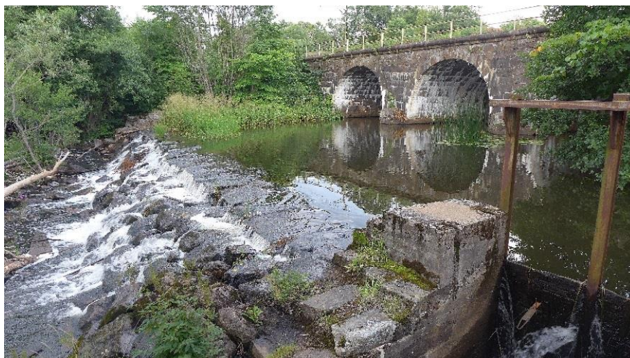
Rester efter dammvall i Nossan vid Herrljunga, RAÄ 115 och 43. Här finns också grundstenar efter en tidigare kvarn bevarade. Foto. Gunilla Roos Nilson.
