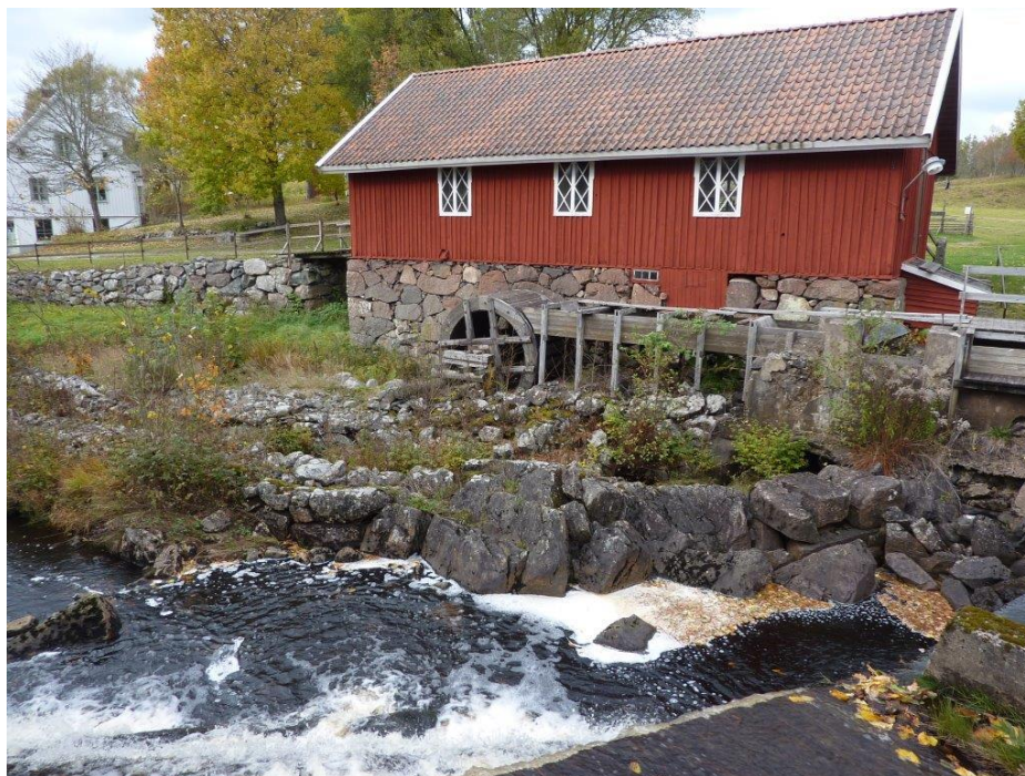
I Toftån finns Komstad by (väster om Sävsjö). Här med välbevarad byggnad för ramsåg, vid kvarnfallet med utanpåliggande vattenhjul och vattenränna bevarade. Foto: Mikael Karlsson.
