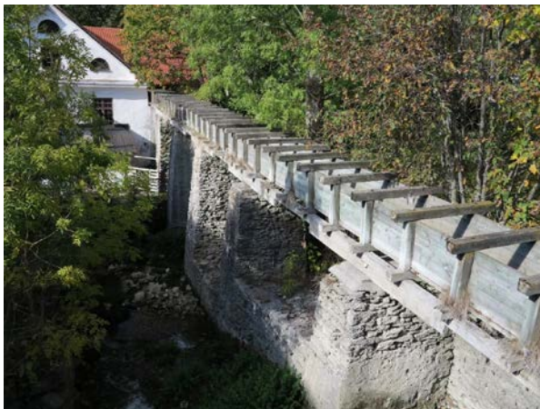
Vattenrännan leder fram vattnet till överfallshjulet. Foto: Pär Malmros.
