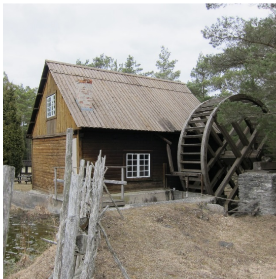
Omläggning faltak, Aner vattenkvarn. Foto:Katarina Amér.
