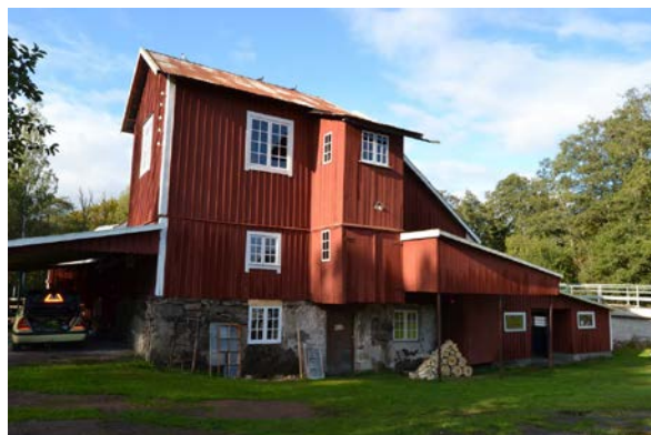
Madängs kvarn efter renovering av fönster. Foto: Björn Ohlén.
