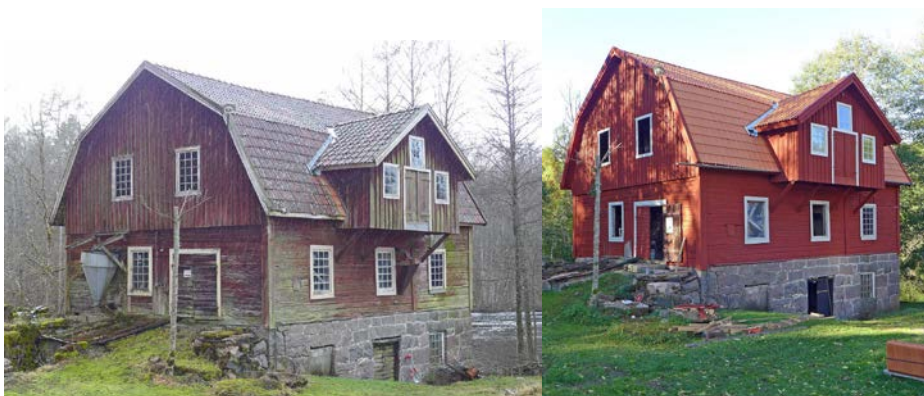
Kvissle kvarn före och efter renovering. Foto: Ulf Larsson.
