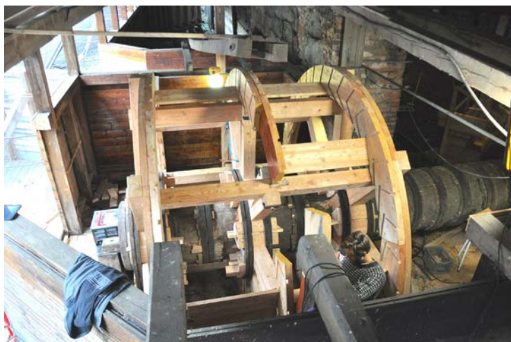
Montering av nytt vattenhjul i Karmansbo. Foto: Mattias Hallgren.
