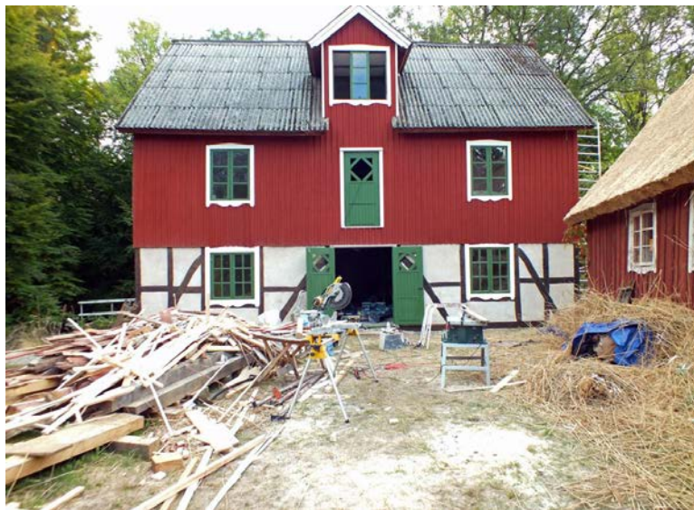
Gräsma kvarn under renovering. Foto: Helene Stalin Åkesson.
