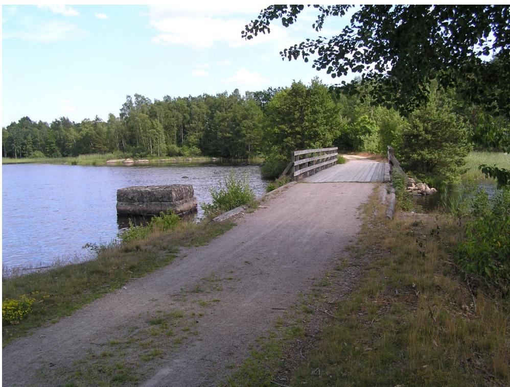
Ulvö svängbro, undersöktes inför planerad restaurering. Foto: Alvesta Kommun.
