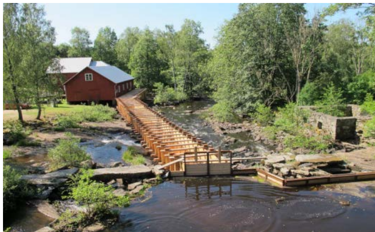
Brokvarns vattenränna efter återuppbyggnad. Foto: Karin Lundberg.
