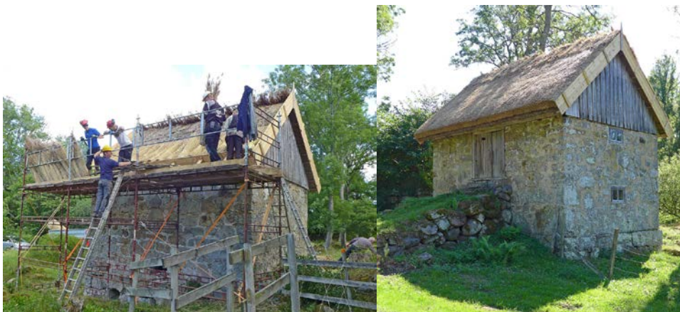
Forentorps klosterkvarn, under och efter omläggning av tak. Foto. Ulf Larsson.
