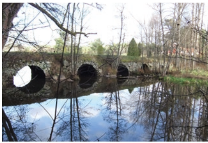
Stenvalvsbron över Emån norr om Alseda i Jönköpings län. Bron är mer känd som Bärbäcksbron och kan vara från 1600-talet.
