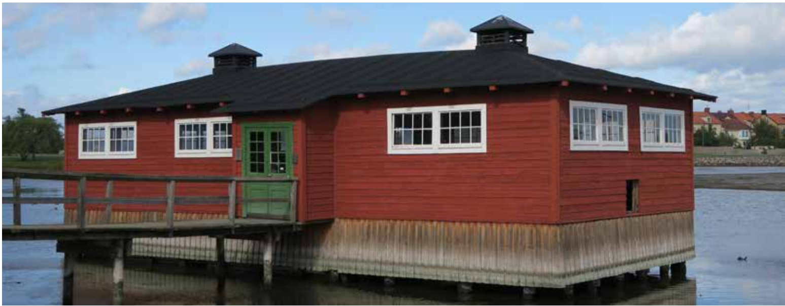
▲ Klapphus i Kalmar, från början på 1900-talet, numera byggnadsminne. Här kunde tvätten sköljas och klappas i skydd för väder och vind. Foto: Richard Edlund
