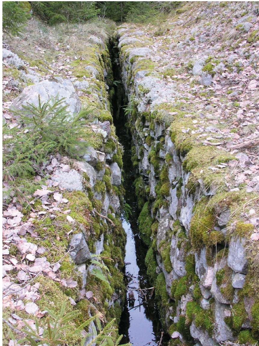
▲ Djupt stensatt dike som leder vatten mot Virån, Kalmar län.
