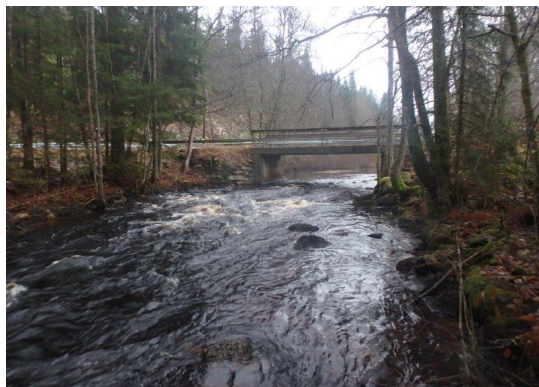
5-15 m nedströms bron
