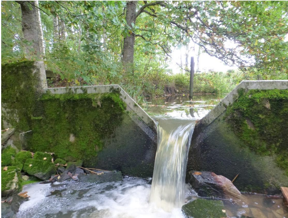
Figur 14. V-överfallet vid mätstationen i område O14. Foto: Lisbet Norberg
