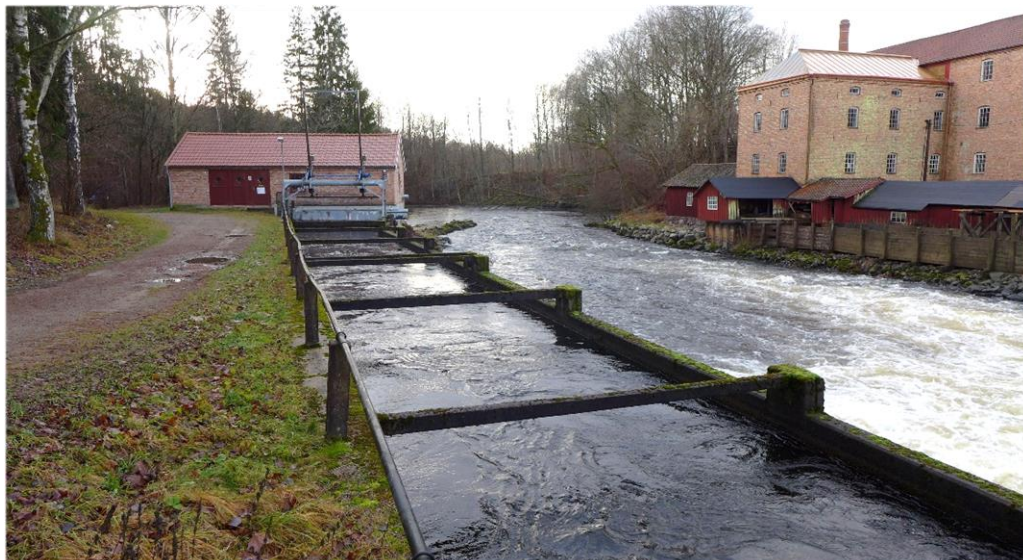
Hillefors kraftverk med intagskanalen av betong. Det uppfördes 1947 men genomgick en ombyggnad 1988.
