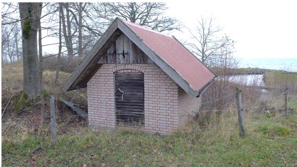
Kraftverket uppfördes omkring 1920. Byggherre var Ekhammars patron Johansson.
