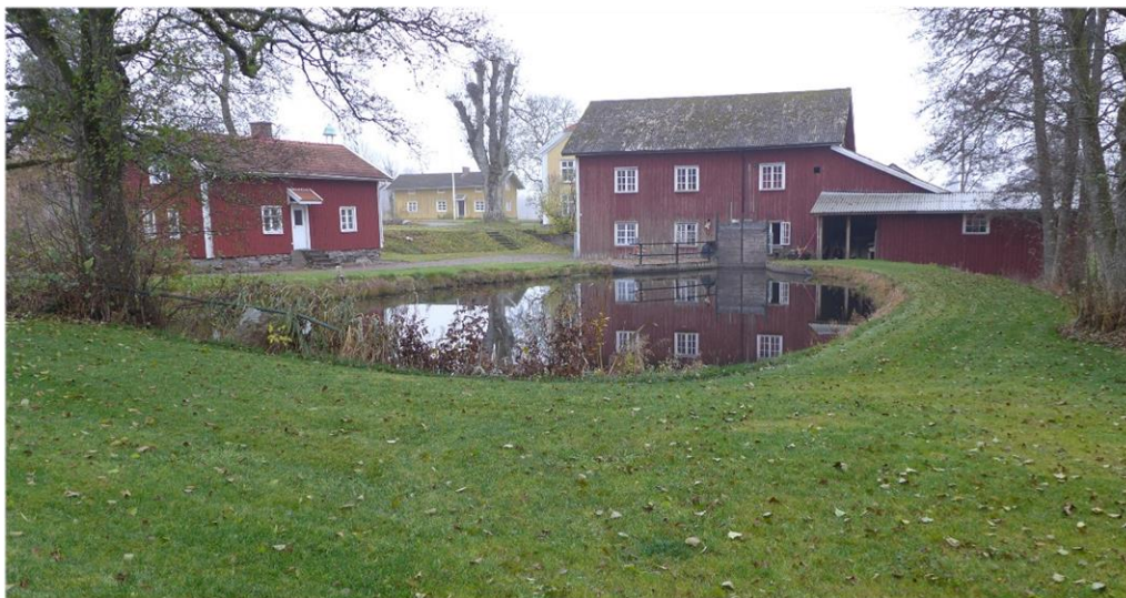
Det nya kraftverket som inryms i kvarnen idag installerades 2007.
