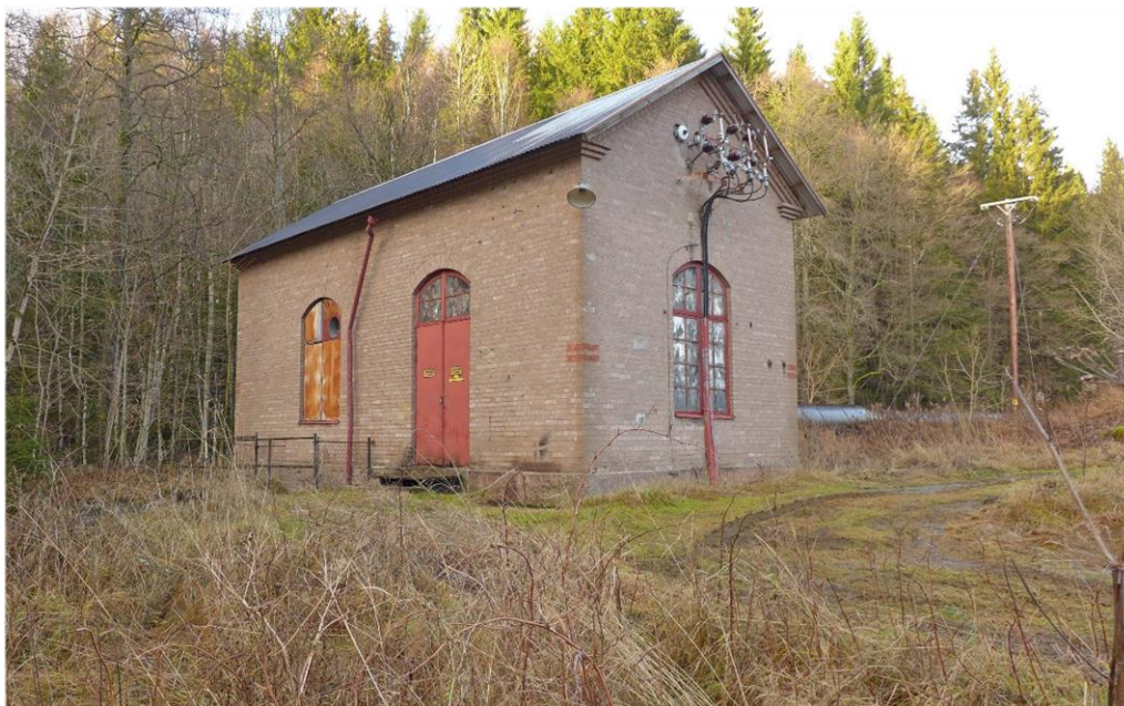
Gälareds kraftverk uppfördes 1906 av Dalsjöfors Väveri AB.
