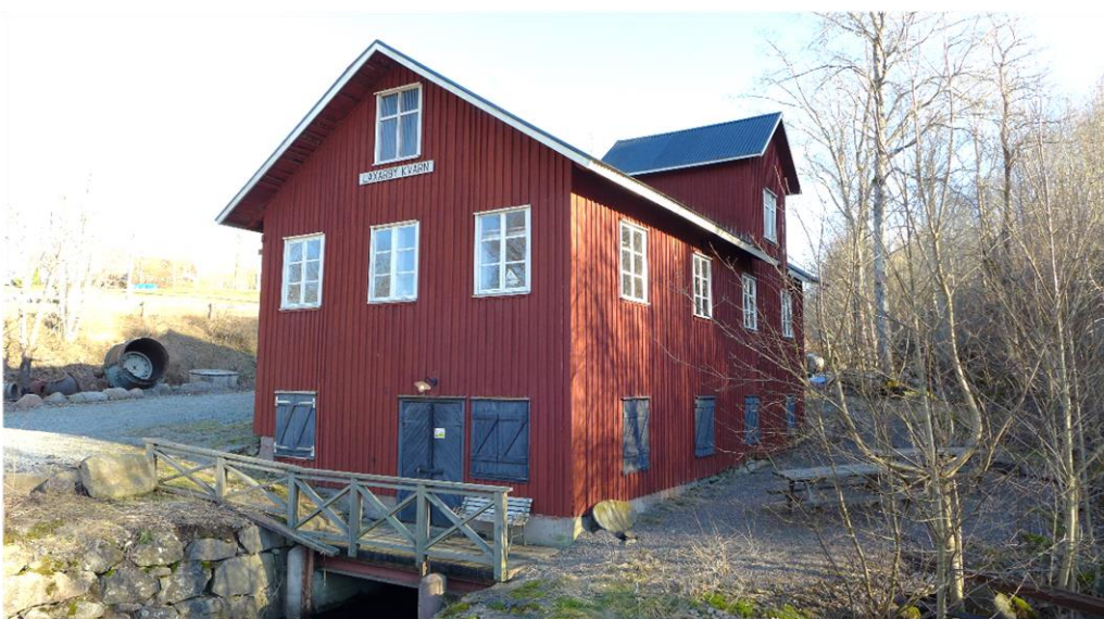
Laxarby kraftverk hör till de verk som är inrymt i den tidigare kvarnen.
