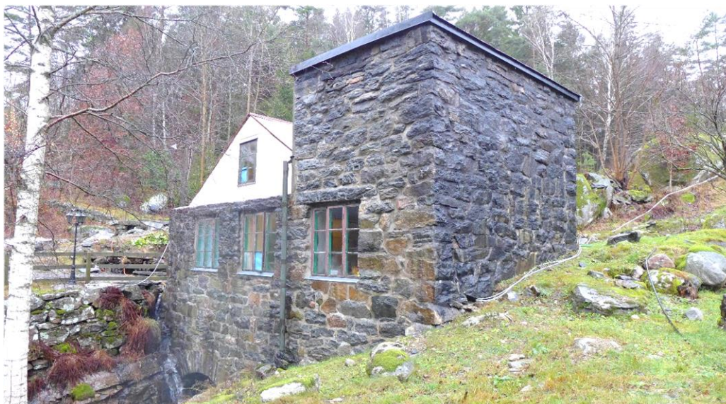
Djupedala kraftverk togs i drift under julen 1924 och var då Lindomes största eldistributör.
