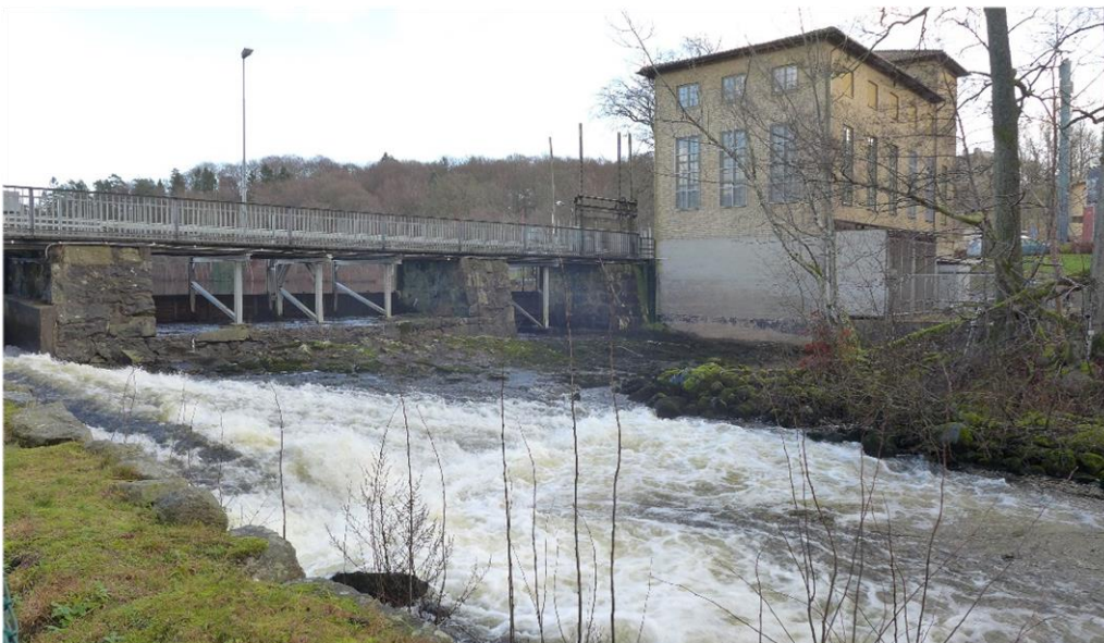
Floda kraftverk byggdes 1929-1930. Byggherre var godsägare Fredrik Eriksson, Floda. Arkitekt och huvudprojektör var Stellan Jacobson Ingenjörbyrå AB, Göteborg.
