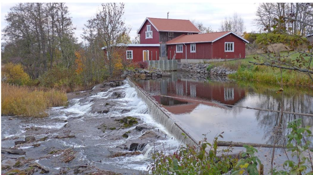
Skogsbo kvarn, i bakgrunden, uppfördes 1858. Det nuvarande kraftverket uppfördes 2004 då en ny turbin installerades. Kraftverket till vänster, f.d. sågen till höger.
