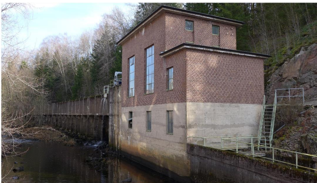
Rydboholms kraftverk är byggt 1943-1945. Byggherre var Rydboholms Kraft AB.
