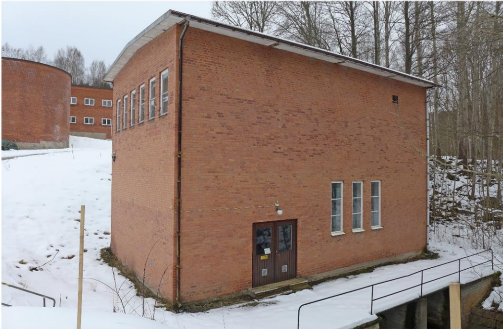
Fengersfors kraftverk byggdes 1952. Under 2013 gjordes en omfattande modernisering av kraftverket.
