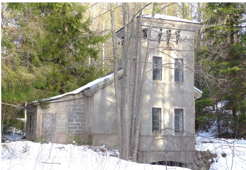
Gottarsbyns kraftverk byggdes 1917-18 och är enligt värderingen i byggnadsminnesklass.
