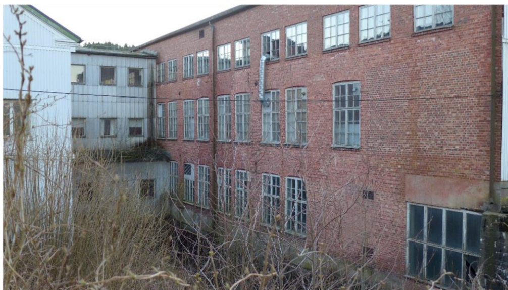
Kraftverket vid Stigen mellan inryms i den tidigare textilindustrin och är taget ur drift.
