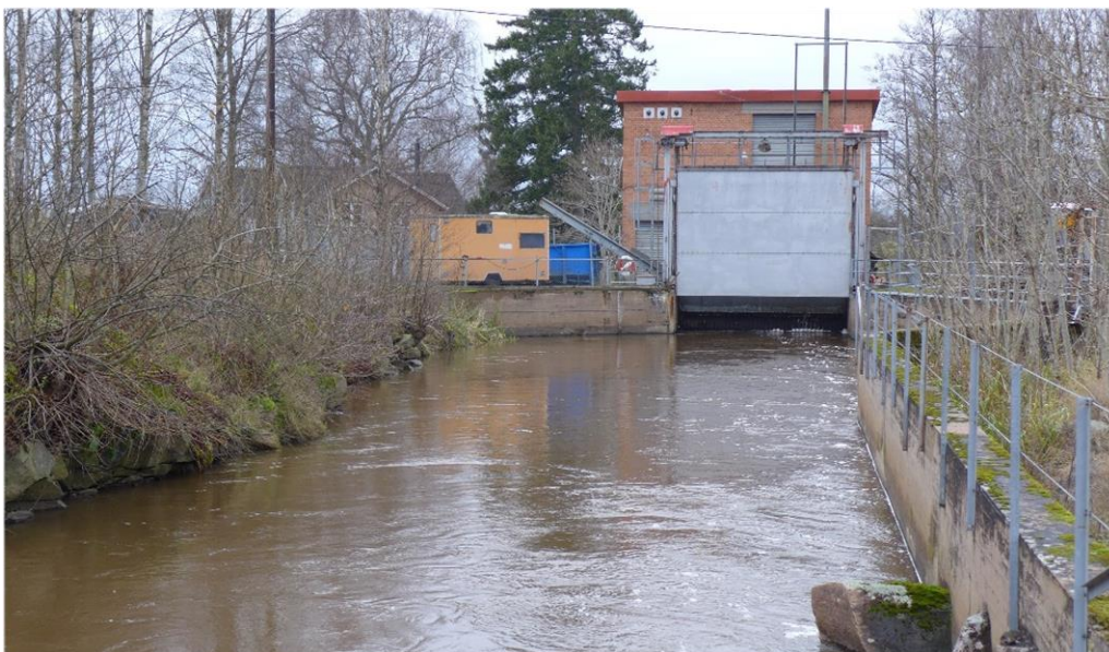
Kraftverket i Ullervad uppfördes 1947 av Kraft AB Nykvarn-Tidan.
