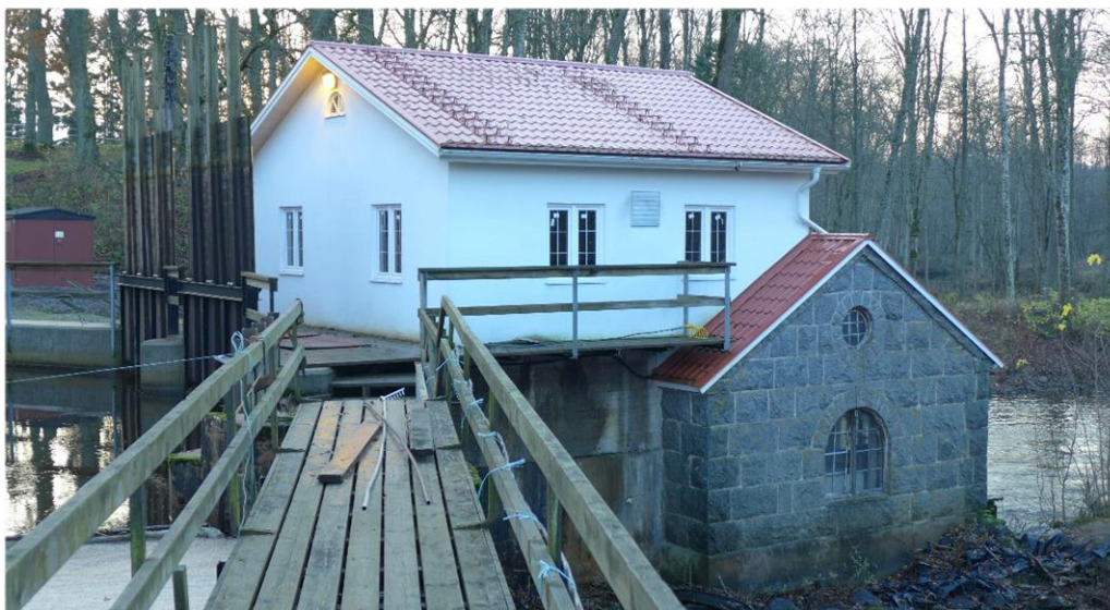
Det gamla kraftverket i sten genomgick en omfattande ombyggnad 2012.
