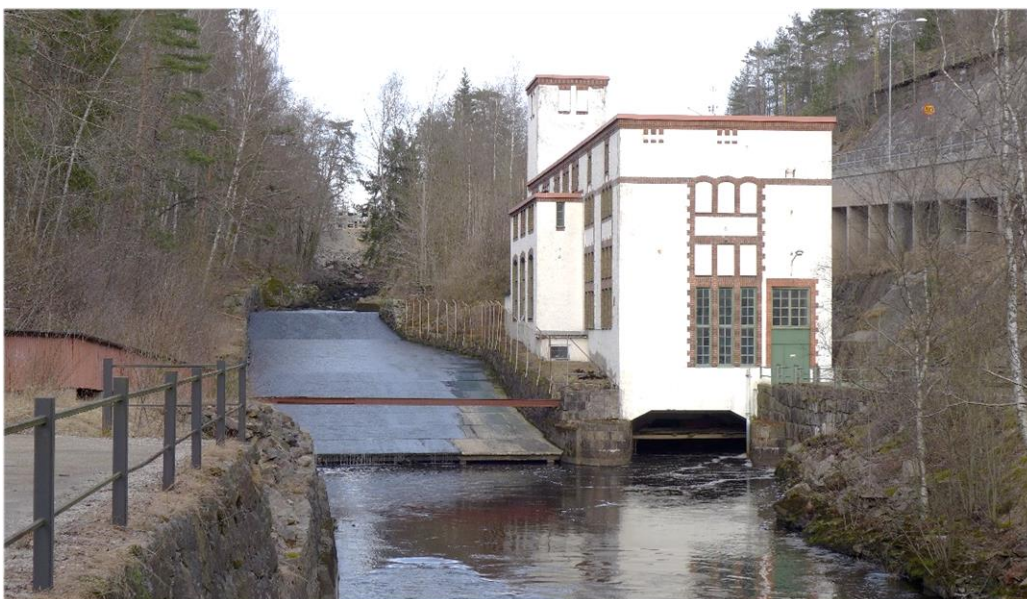
Kraftverket är uppfört 1917-1919 av Rydboholms AB.
