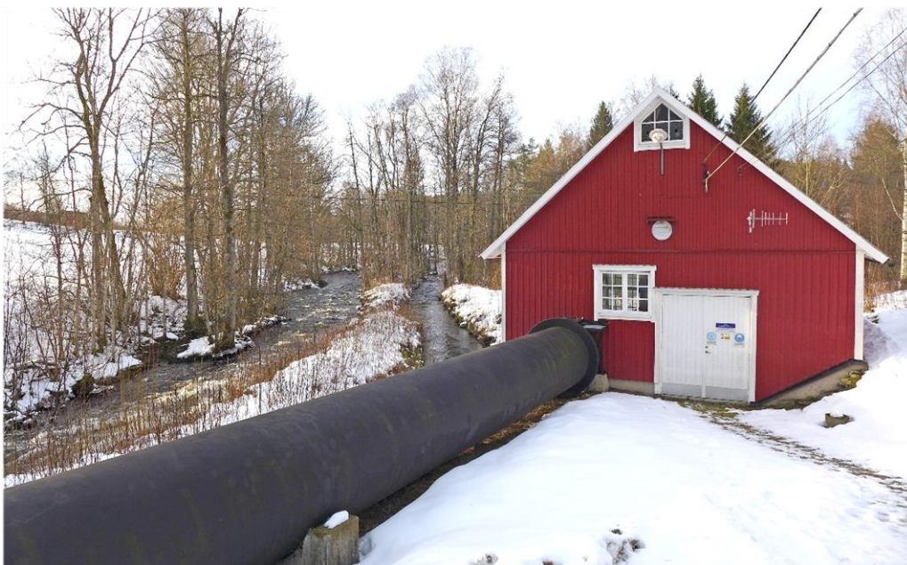
Stampens kraftverk byggdes 1908 och byggherre var Ör-Melleruds Elektriska AB.
