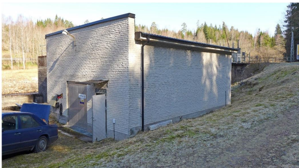
Åstafors kraftverket uppfördes i sitt nuvarande utseende 1964-65 av Carl Bengtsson, Tranemo.
