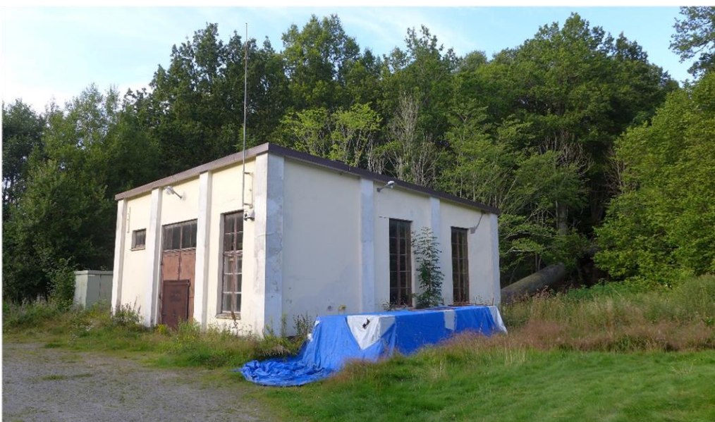
Främmestads kraftverk är uppfört 1937 efter en brand i det tidigare verket från 1907.
