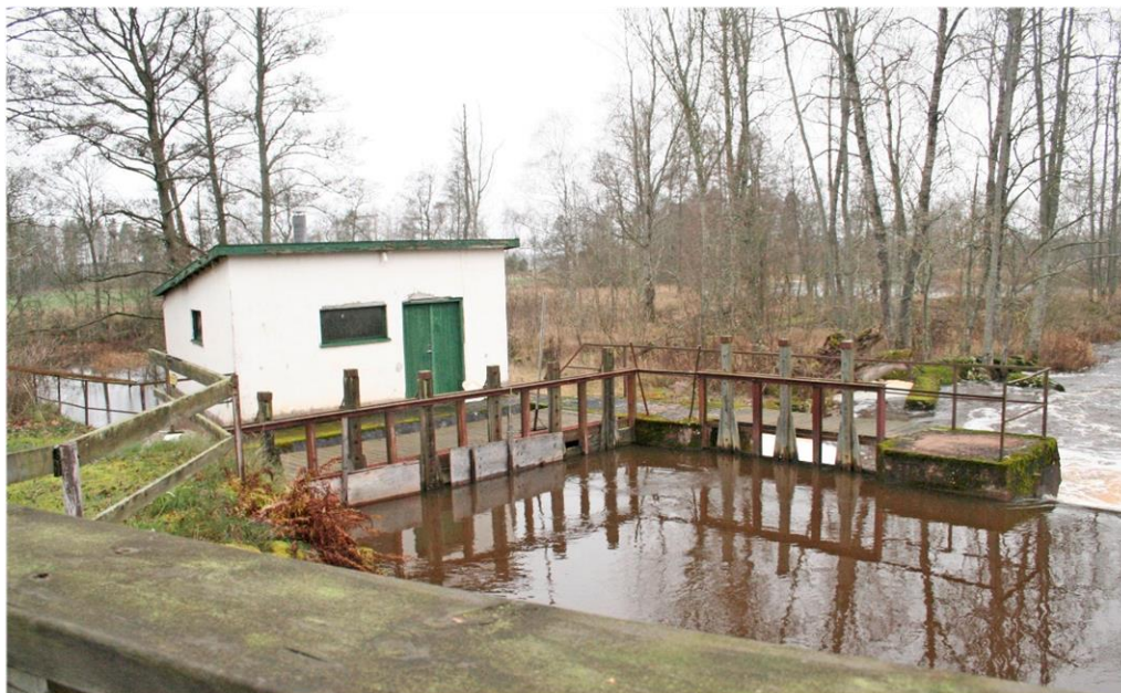
Armeneby kraftverk uppfördes omkring 1953 av AB Bellefors kraftverk.
