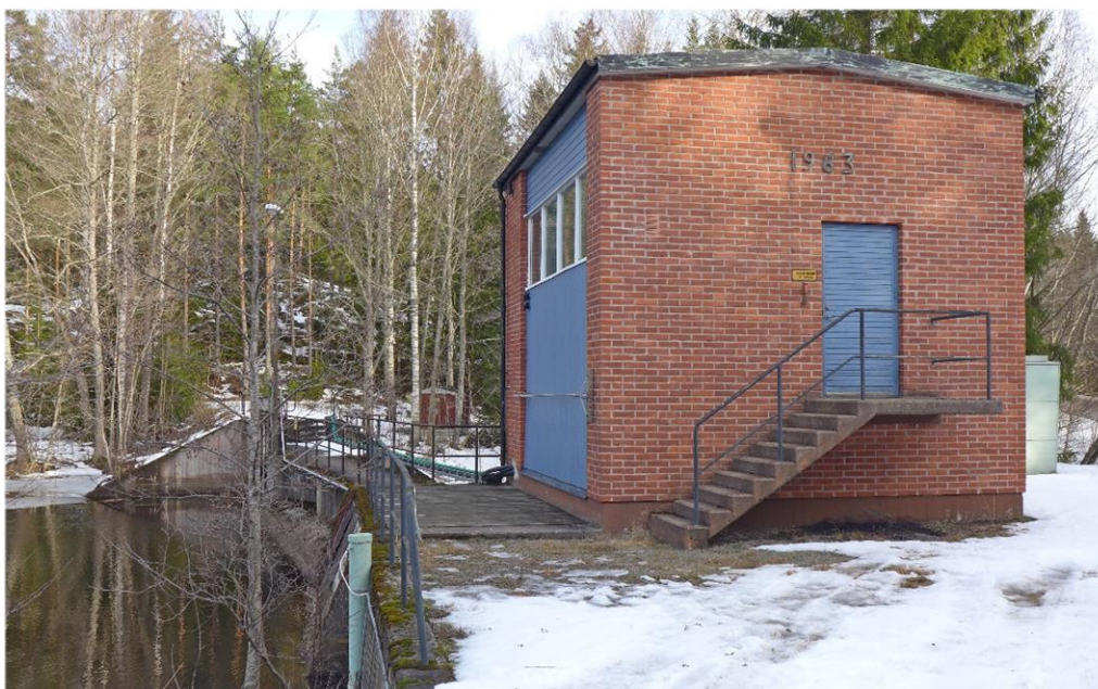
Kallskogs kraftverk byggdes 1963 och byggherre var Åmåls stads elverk
