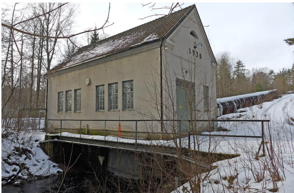
Korsbyns kraftverk byggdes 1930 av Åmåls stad.
