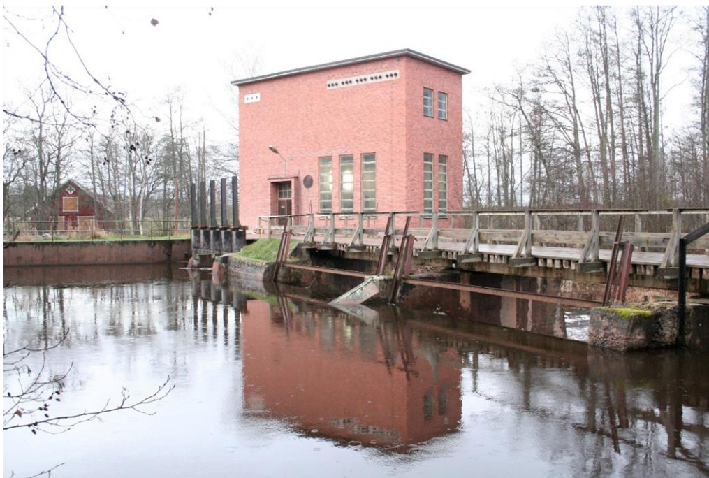
Intagsdammen med spettluckor (till vänster). Utskovsdelen i betong med träläggning.
