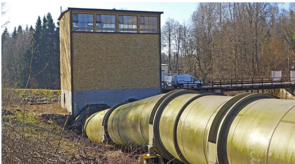
Axelfors kraftverk uppfördes 1935-1936. Byggherre var Borås Stads Elektricitetsverk
