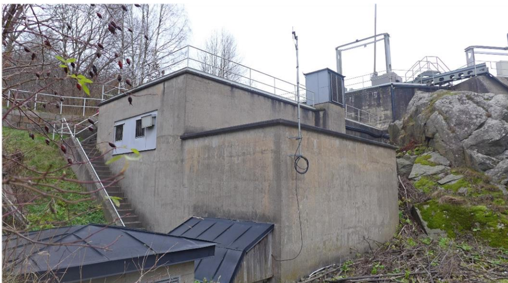
Fossumsbergs kraftstation togs i drift 1943. Byggherre var Uddevalla stad och huvud-projektör och arkitekt var Stellan Jacobssons ingenjörbyrå, Göteborg.
