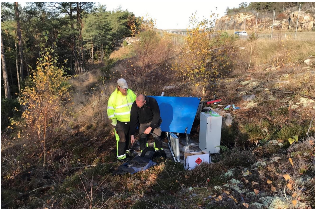
Figur 7. Arbetet med installation av solcellspanel med tillhörande elskåp. Foto: Henrik Zedig, Länsstyrelsen Västra Götaland 2019.
