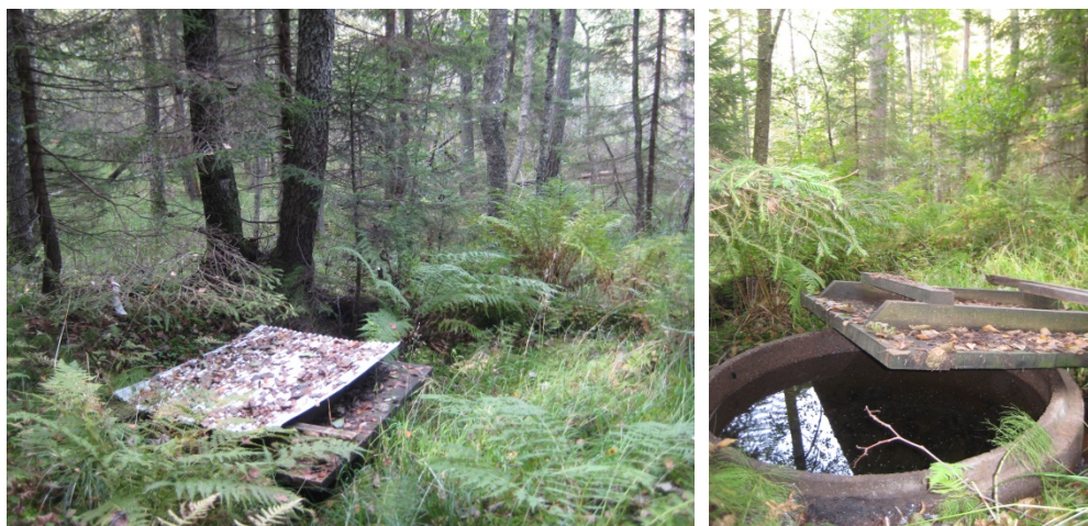
Figur 16 Station Sk11 Hultet. Källbrunnen med lock och utan lock, vänster respektive höger bild. Foto 2015.
