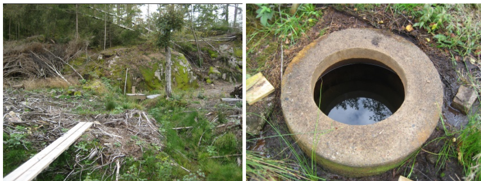
Figur 4 Station 800 Kroken. På vänster bild syns brunnen med lock i mitten av bilden och att området kring brunnen är kalhugget. Höger bild visar brunnen.
