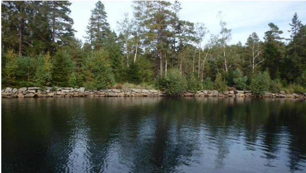
Figur 8. Stenvall som dämmer upp Torr gårdssjön åt norr.
