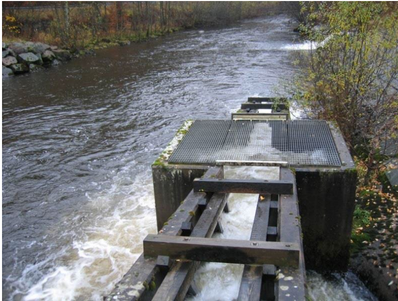
Bild 2. Jonsereds övre fiskväg, en denilrännan, erbjuder fisken en vandringsväg förbi dammen som utgör ett definitivt vandringshinder mellan naturfåran vid Jonsereds kraftverk och sjön Aspen. Foto: Länsstyrelsen i Västra Götaland.
