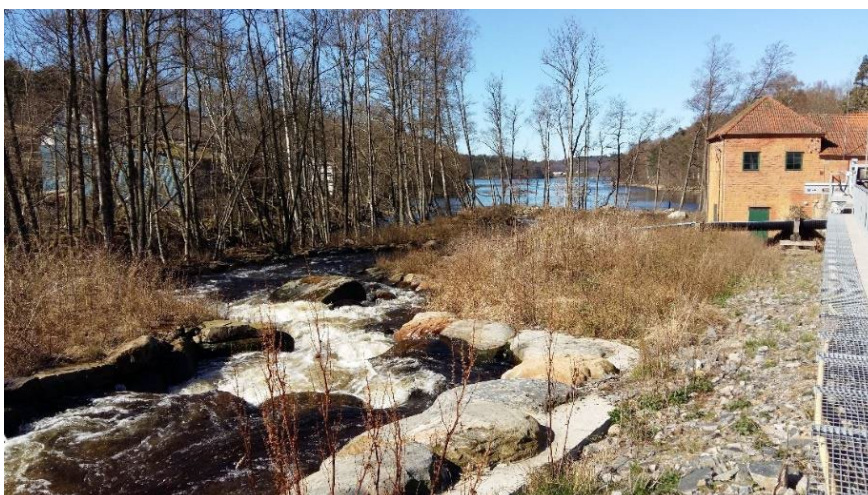
Bild 5. Omlöpet vid Ålgårda i Rolfsån. Nedströms Ålgårda rinner Rolfsån ut i Stensjön. Foto: Länsstyrelsen.
