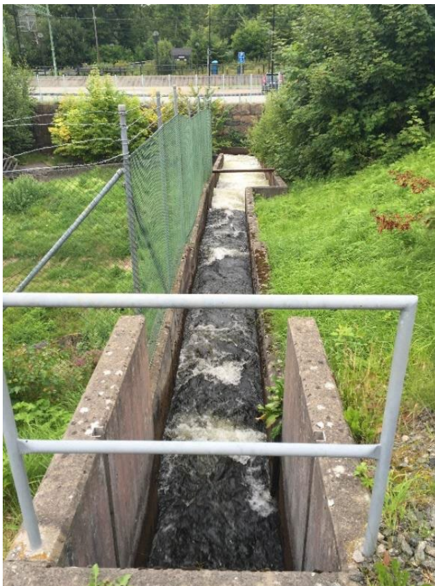
Bild 3. Jonsereds nedre fiskväg, en 100 meter lång kombination av kammarrappa och denilrännan. Foto: Länsstyrelsen i Västra Götaland.
