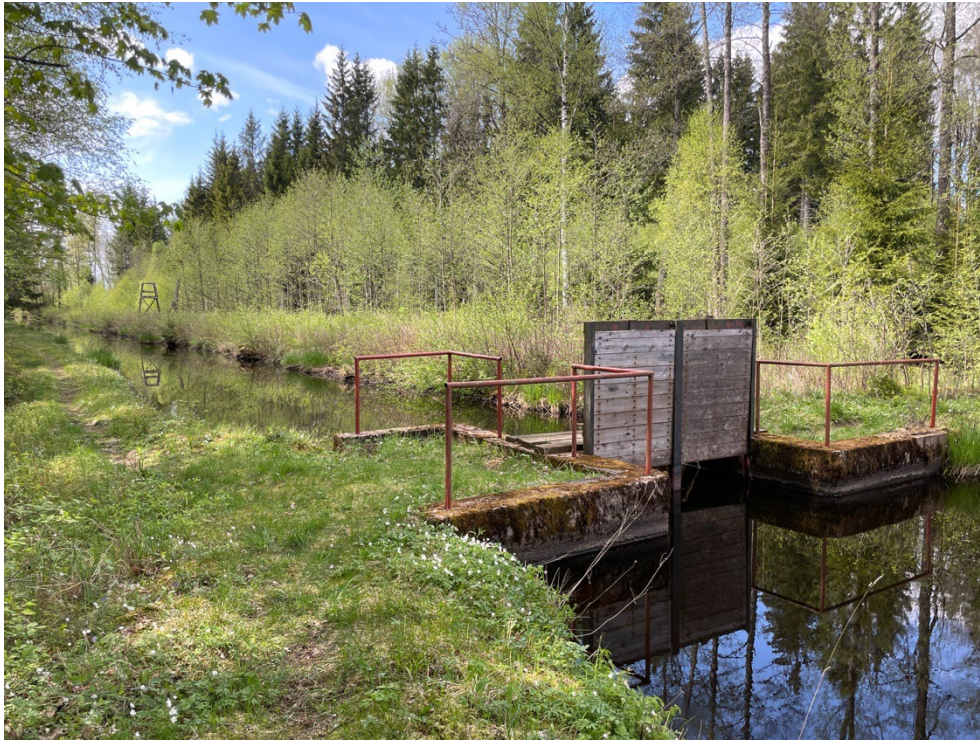
Avstängningsluckor vid tilloppskanalens inlopp vid verksdammen och Åsarpsån.
