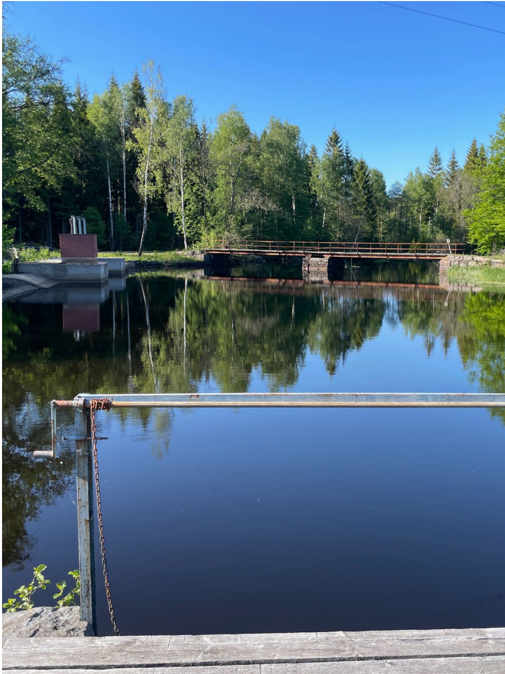
Det uppdämda vattenområdet sett från dammen. I bakgrunden syns luckorna vid utloppet till den kanal som löper vid sidan av dammen liksom en balkbro med murade stöd i sten.
