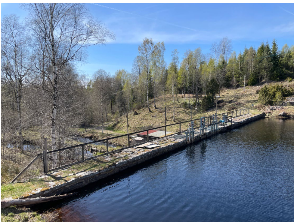
Dammkonstruktionen sträcker sig mellan två bergssidor.
