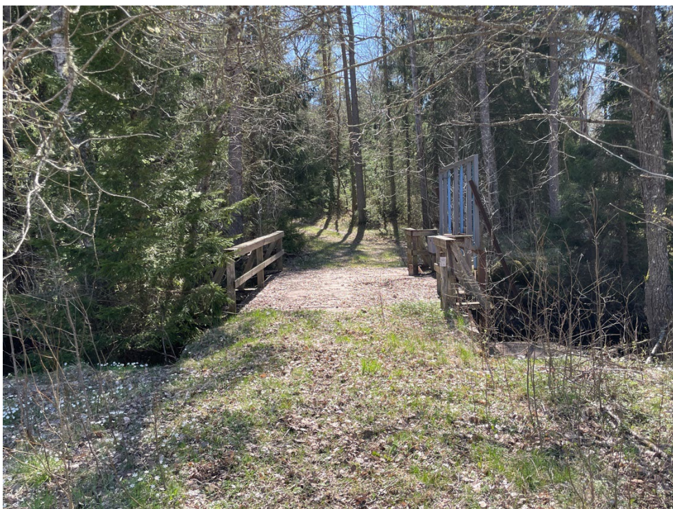
Grytteredssjöns regleringsdamm sedd från norra sidan av ån.
