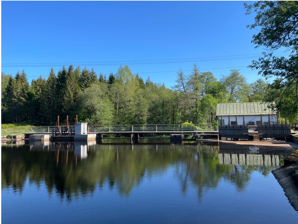
Fredriksborgs kraftstation och damm med intagsluckorna till höger.
