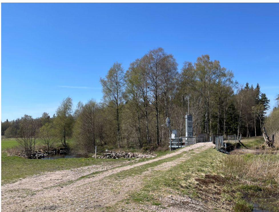
Dammanläggningen sedd från öster.
