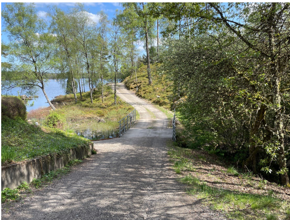
Marjebosjöns regleringsdamm vid Marjebosjöns utlopp i Musån.
