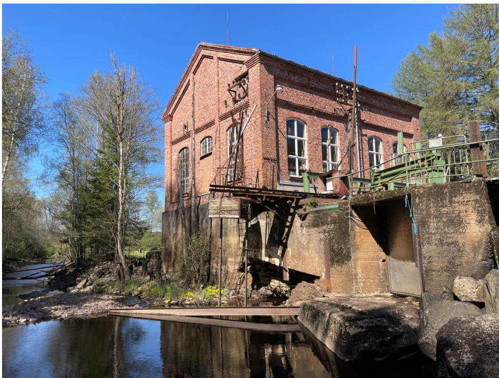
Kraftstationen och intagskanalen sedda från åfåran.
