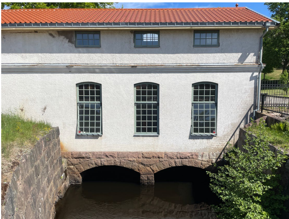
Kraftstationen vid Strömsfors kraftverk.
