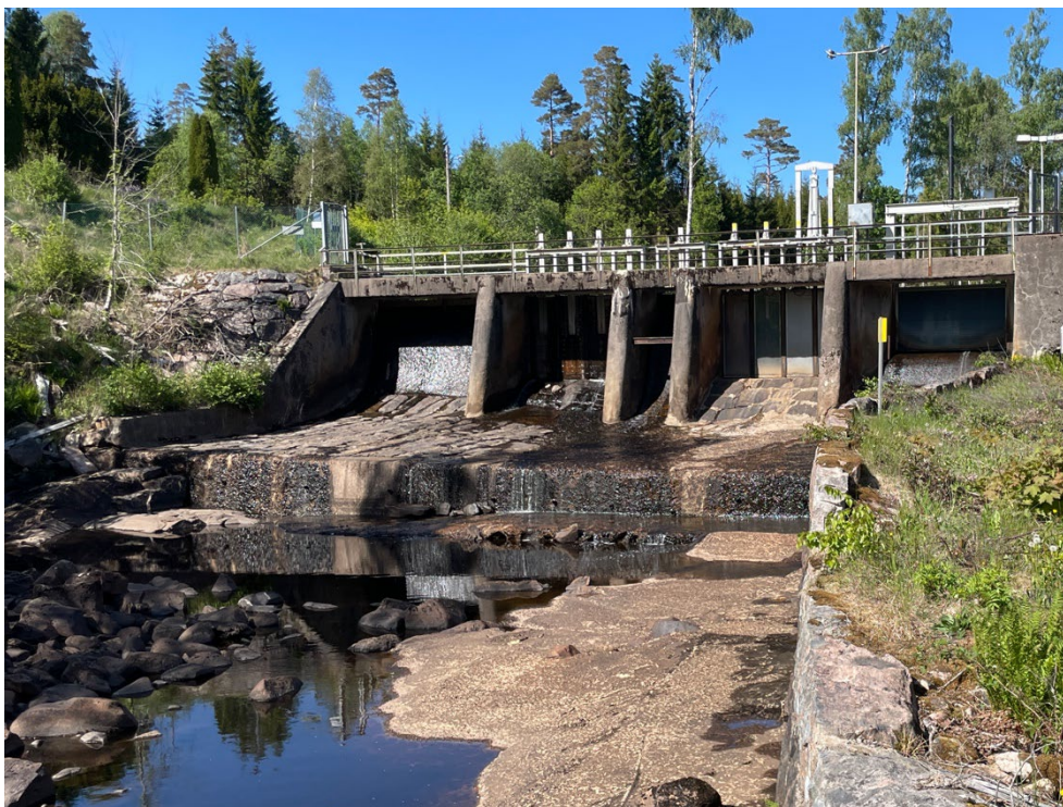
Dammen vid Assmebro kraftverk, utförd i betong och sten.
