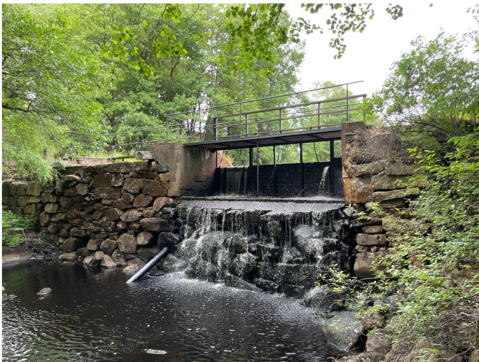
Dammbyggnaden vid Sågbackens kraftverk med en större öppning vid åfåran. Till vänster syns en överfallsöppning.
