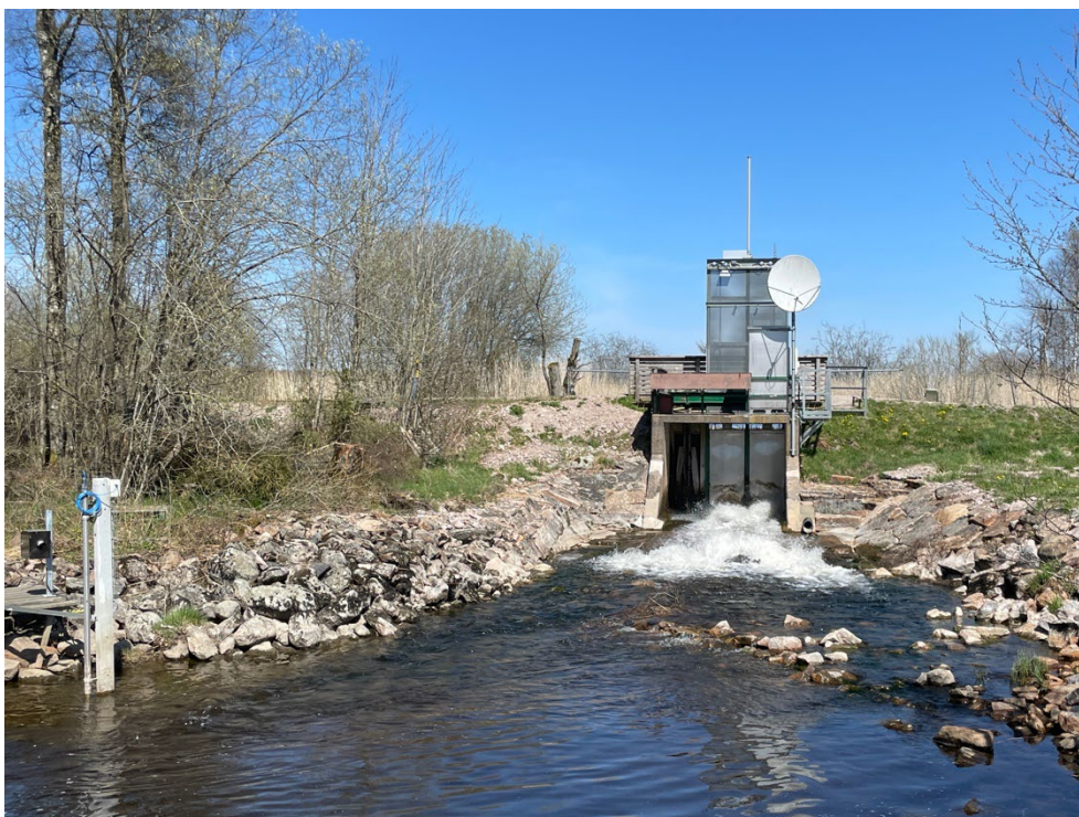
Utskovet vid Sämsjöns regleringsdamm
