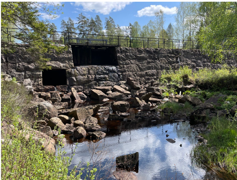
Stendammen vid Furulunds kraftverk, uppförd 1918.
