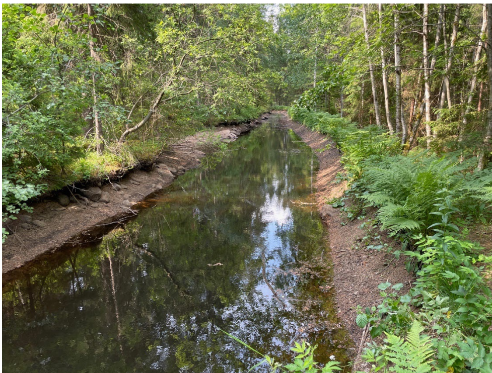
Del av den långa tillloppskanalen vid Kvarntorps kvarn och kraftstation.
