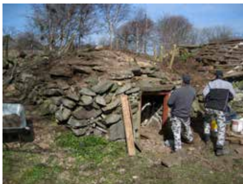
Arbetet har påbörjats.
