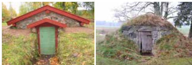
Ovan: Jordkällare i slänt med endast front och tak synliga. Vänster: Jordkällare nedgrävd på plan mark med nedgång till dörren. Höger: Jordkällare byggd ovanpå plan mark
