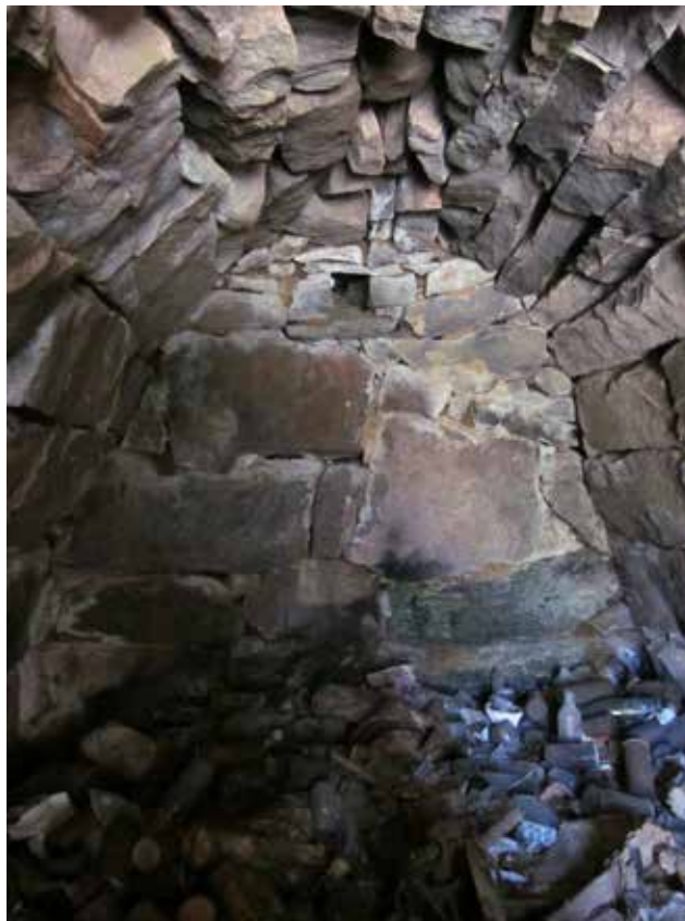
Den inre gaveln i källaren kallas bakmur.
