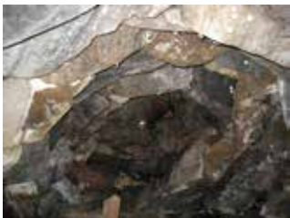
Vänster: Överkragning av den runda typen. Höger: Jordkällare med rund överkragning får ett toppigt utseende.
