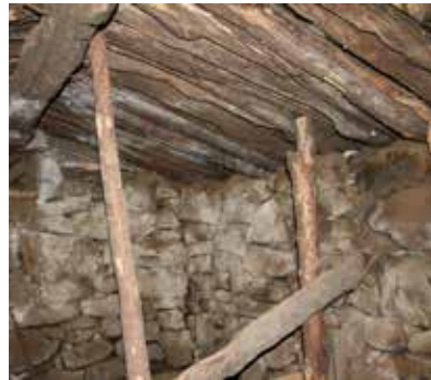
Vänster: En något modernare variant av källare som är byggd i stora förfabricerade kalkstenshällar och sammanfogad med järnkramlor. Höger: Innertak av trä med slanor och åsar. KW
