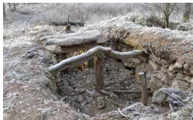
När jordkällaren byggdes använde man naturligt växta stammar i takkonstruktionen, Borrabo, Falköpings kommun.
