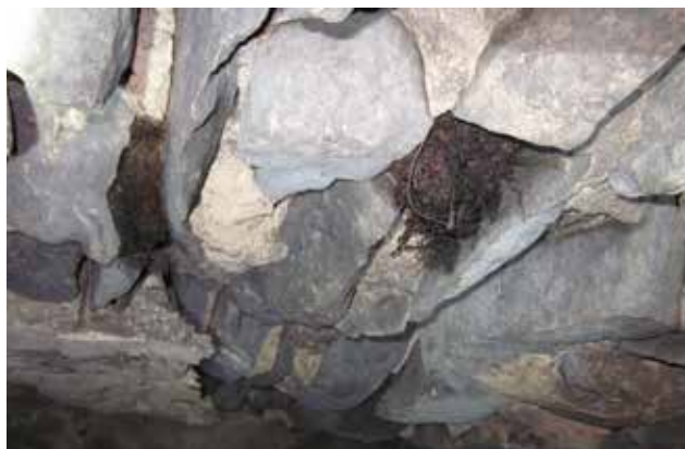
Tätning av valvet med mossa och kalkbruk.
