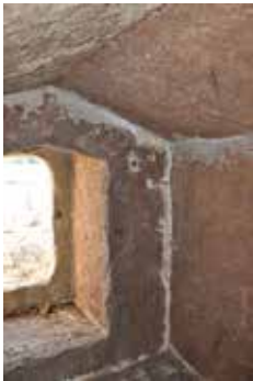
Vänster: En något modernare variant av källare som är byggd i stora förfabricerade kalkstenshällar och sammanfogad med järnkramlor. Höger: Innertak av trä med slanor och åsar. KW
