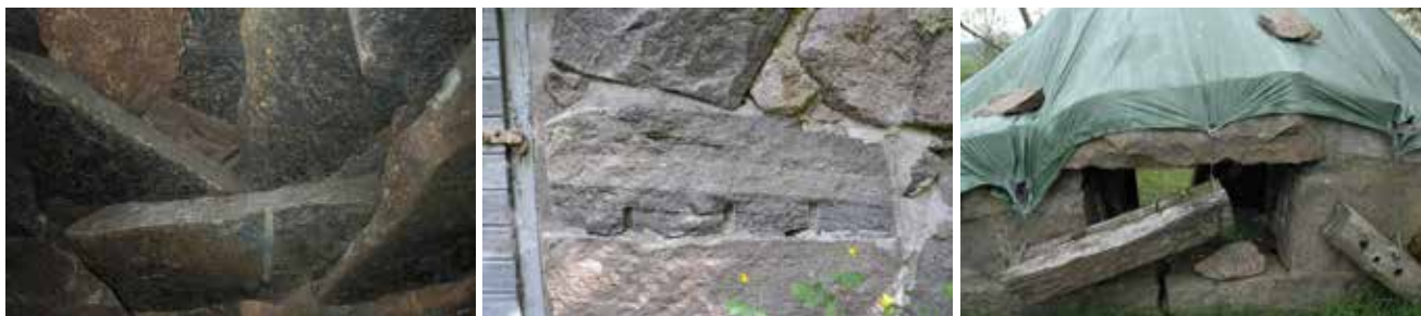
Vänster: Enstaka långa borrhål visar att materialet är sprängt ur berg eller stenblock. KN Mitten: Rader med hål visar att materialet spräcks ur större block med hjälp av borr och kilar. Höger: Den överliggande stenen visar spår av bearbetning med "sätt".
