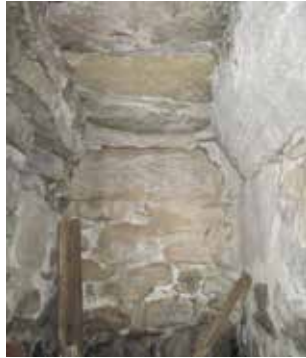
Vänster: Kallmurat naturstensvalv. Höger Hällatak, med något utkragade sidoväggar för att spannet inte ska bli så långt. KN
