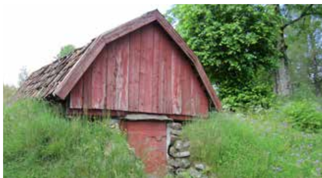
Ovan: Jordkällare i slänt med endast front och tak synliga. Vänster: Jordkällare nedgrävd på plan mark med nedgång till dörren. Höger: Jordkällare byggd ovanpå plan mark
