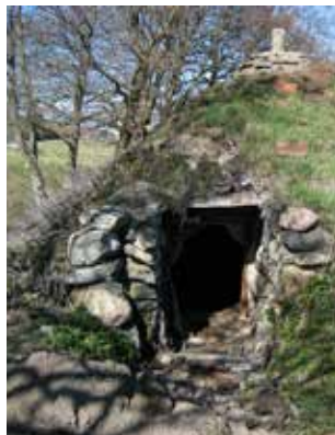
Vänster: Överkragning av den runda typen. Höger: Jordkällare med rund överkragning får ett toppigt utseende.
