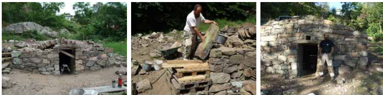
Vänster: Återuppbyggnad av frontmur. K-SK Mitten: Enkla lyfthjälpmedel för stora stenar. Det är bra att ha mycket sten att välja på vid murningen. K-SK Höger: Knut-Steffen efter ett gott arbete. K-SK Nedan: Den färdiga källaren.
