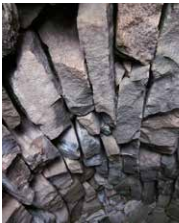
I valvslagning är det viktigt att stenarna ligger i förband.
