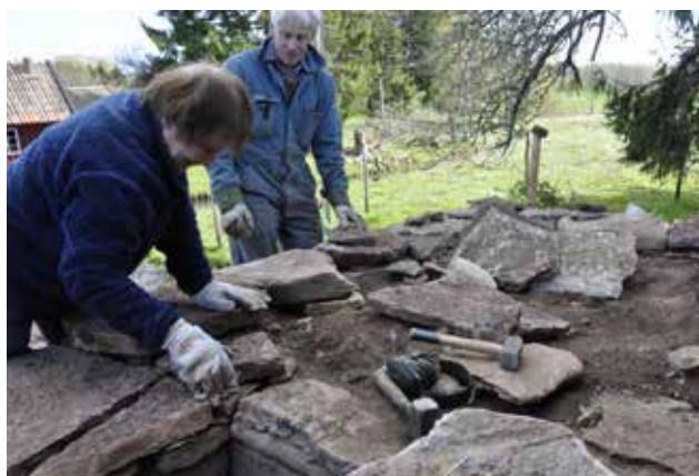
Överst: Färdigt valv. Mitten: Studenter i arbete. Nederst: Kursdel-tagare i färd med uppbyggnad av den jordfyllda frontmuren.
