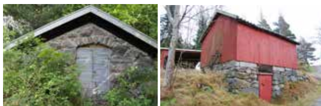
Ovan: Helt jordtäckt källare utan annat tak. Vänster: Källare med enkelt sadeltak. Höger: Källare med överbyggnad, så kallad källarvind.
