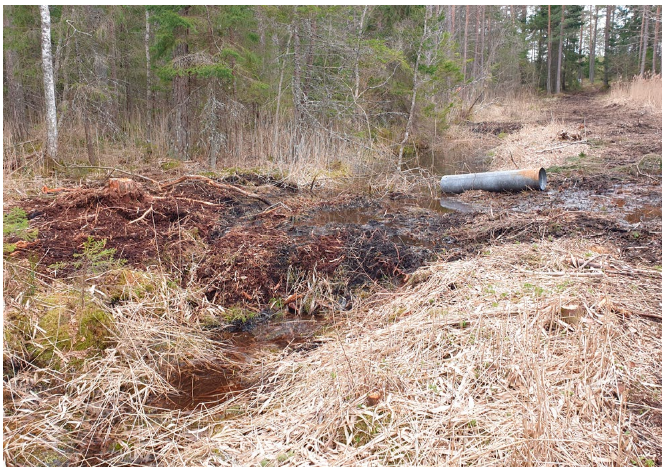
Figur 4.15. Slutande dike där man ändå valt att sätta enskilda dämmen på grund av naturvärden i form av bland annat kransalger Chara sp. Till höger i bild har man grävt bort och använt tidigare uppgrävt dikesmaterial/dikesvall. Det extremrika Edskärret, källkärr, Uppsala län (foto: Jesper Hansson).
