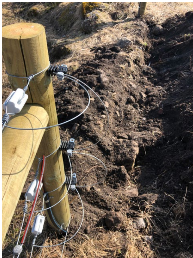
Figur 4.11. Nedgrävning av matarkabel i grindöppning (foto: Jennie Niesel).
