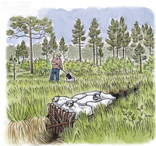
Figur 4.18. Jutesäckar som fylls med material tillgängligt nära dämmningsplatsen (torv) kan bli ett enkelt och flexibelt dämme som förankras med trästolpar huggna på plats. Dämnet kan till exempel användas vid komplettering och reparation av andra dämmen och dämning i små och känsliga källmiljöer (illustrationer: Tupu Vuorinen).
