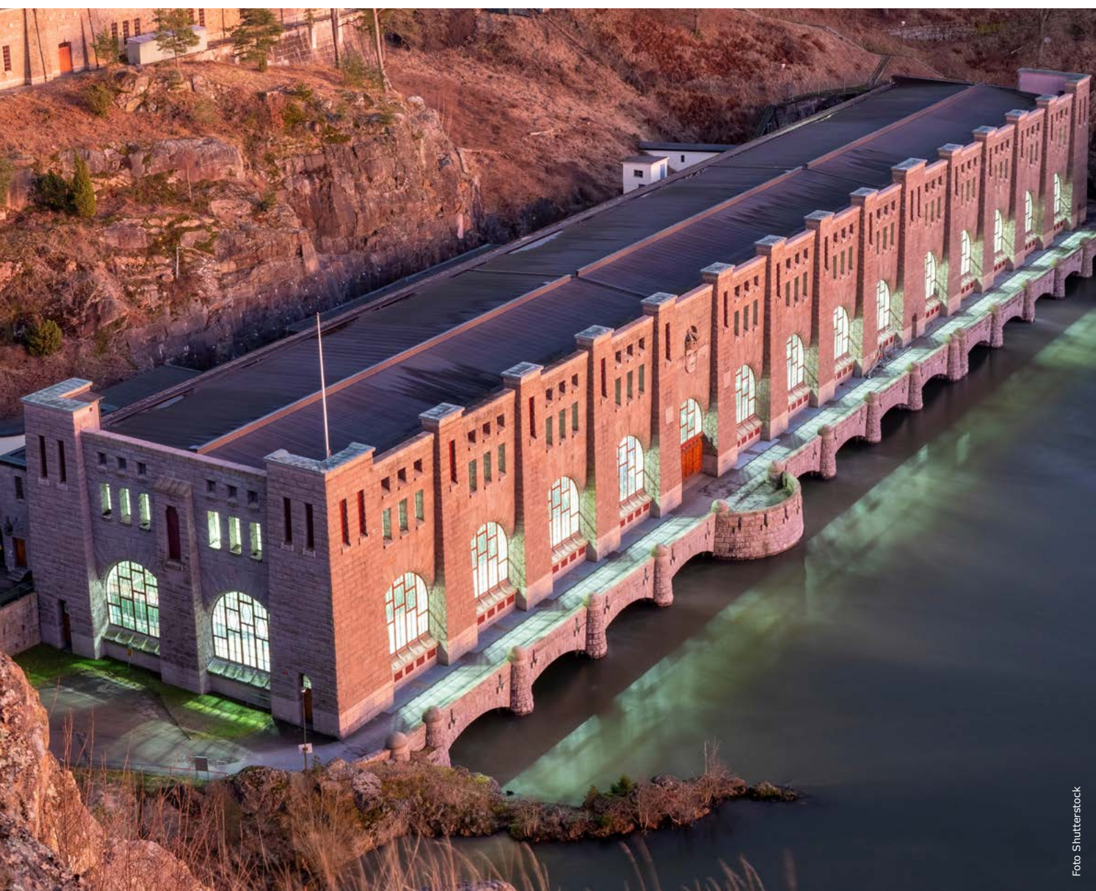
Olidan vattenkraftverk, Trollhättan.
