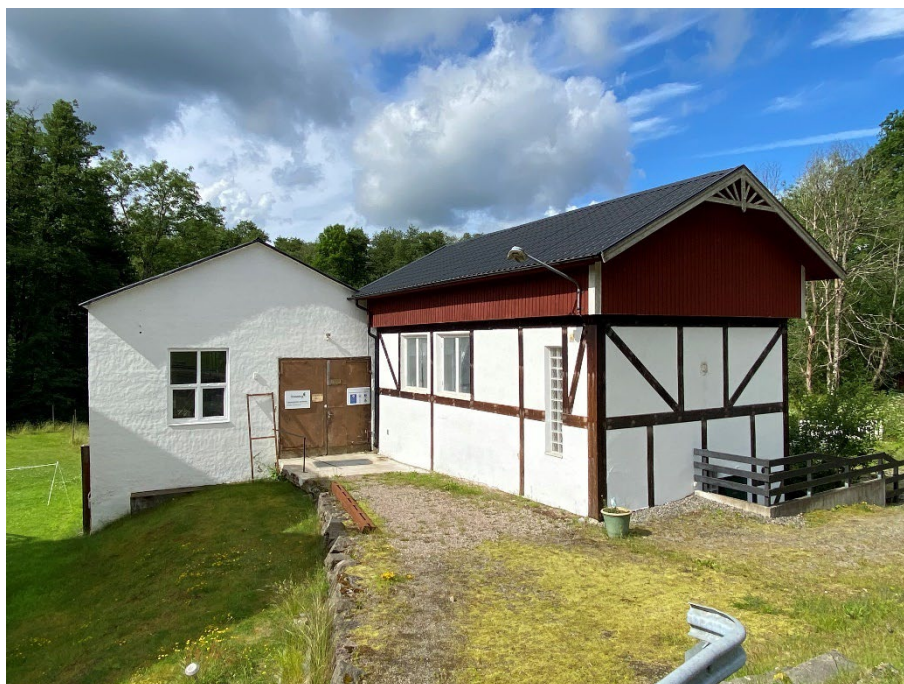
Figur 39. Kraftstationen fotograferad från öster.
