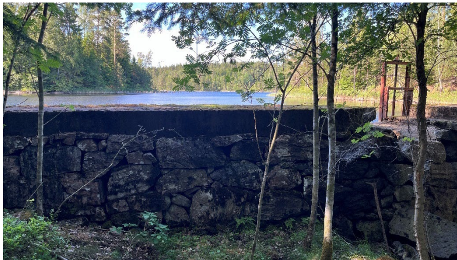
Figur 28. Vy över dämnet sett nedströms Mårsjön. Här syns den gamla dammkroppen i natursten tillsammans med det pågjutna dammkrönet.
