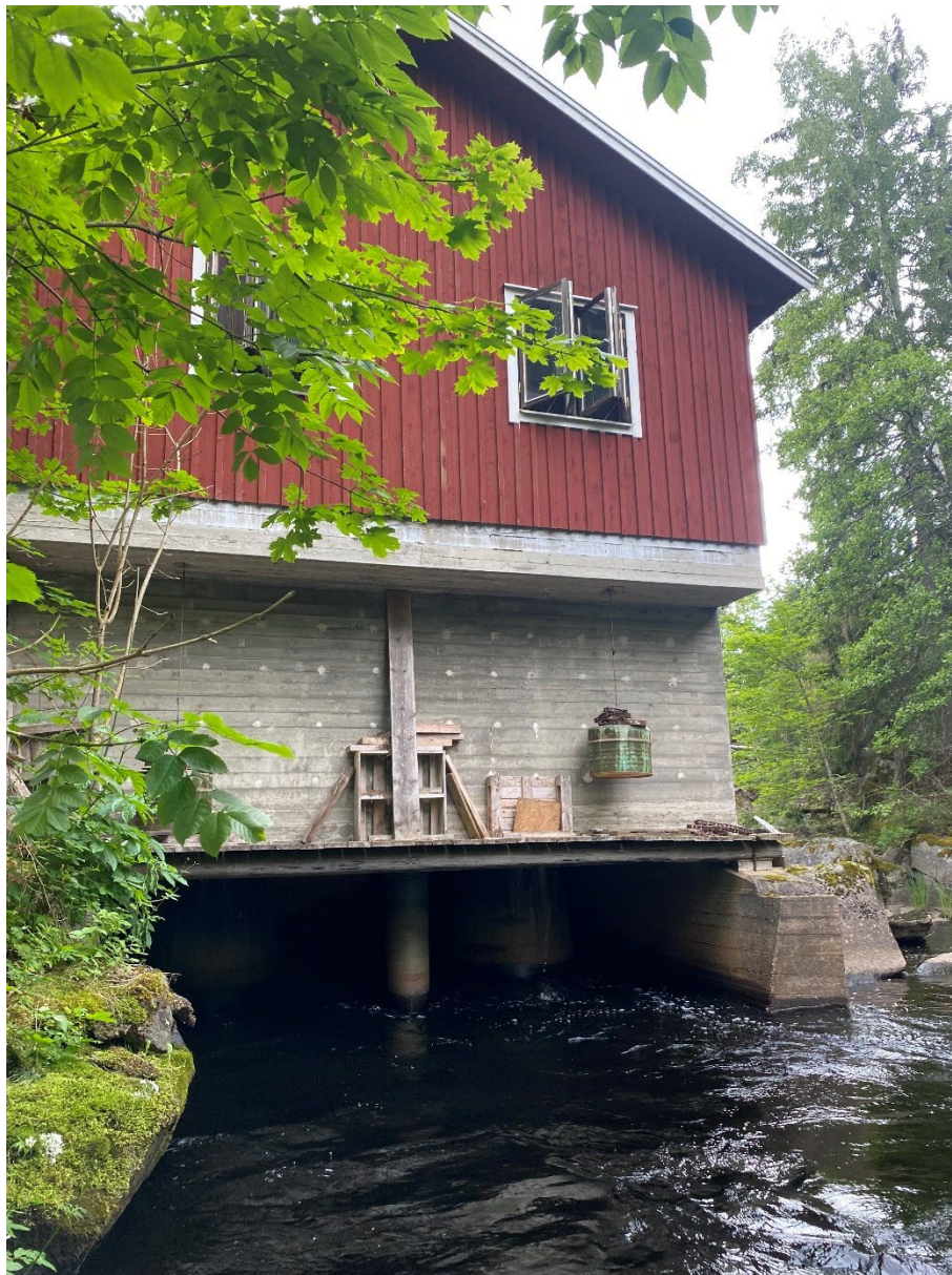
Figur 57. Kraftverksbyggnaden med utlopp.
