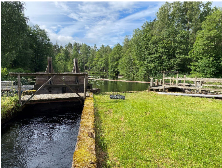
Figur 53. Intagsrännan till sågens turbin till vänster.
