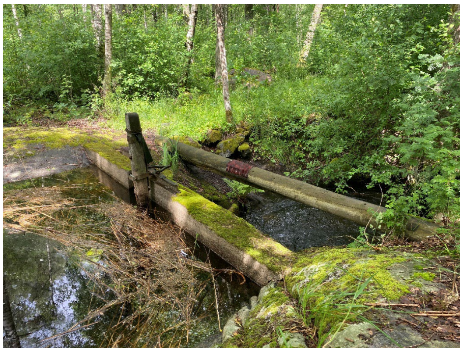
Figur 71. Dämmet med spetlucka.
