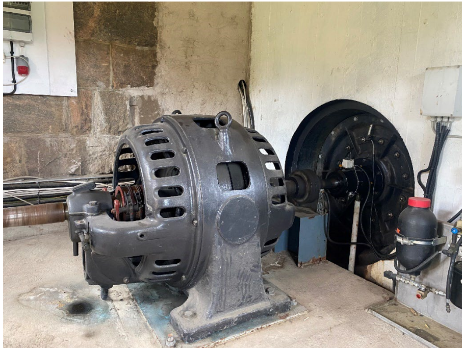
Figur 64. Synkrongenerator från Asea, tillverkad på 1930-talet.
