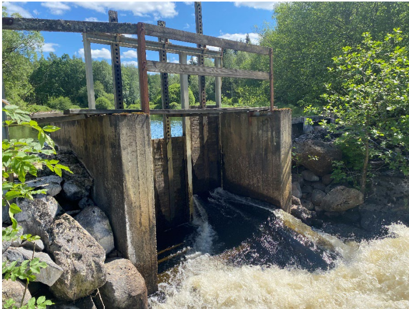
Figur 67. Sävsjöos damm med tre spetluckor.
