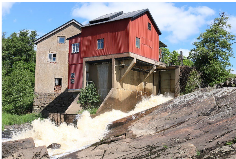
Figur 29. Källafors kraftverk och kvarn, sedd nedströms.
