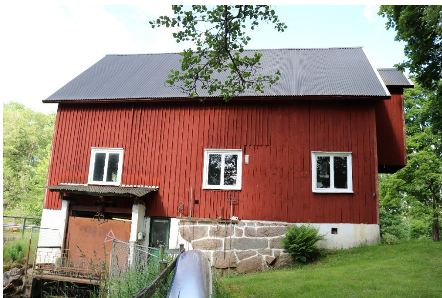
Figur 37. Kraftverkets östra fasad där inloppskanal och intagslucka finns.
