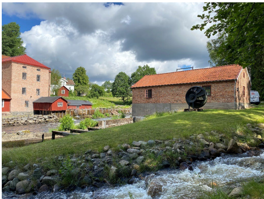
Figur 5. Hillefors kraftverk till höger och grynkvarnen till vänster nedströms dammen.
