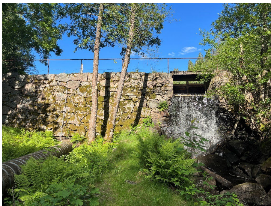
Figur 23. Kallmurad dammkropp med två luckor. Till vänster i bild syns tillloppstuben till kraftverket.
