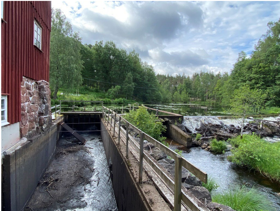
Figur 52. Dammen med kvarnens intagsränna i betong till vänster.
