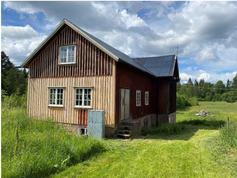
Figur 62. Kvarnens sydfasad har nyligen renoverats.
