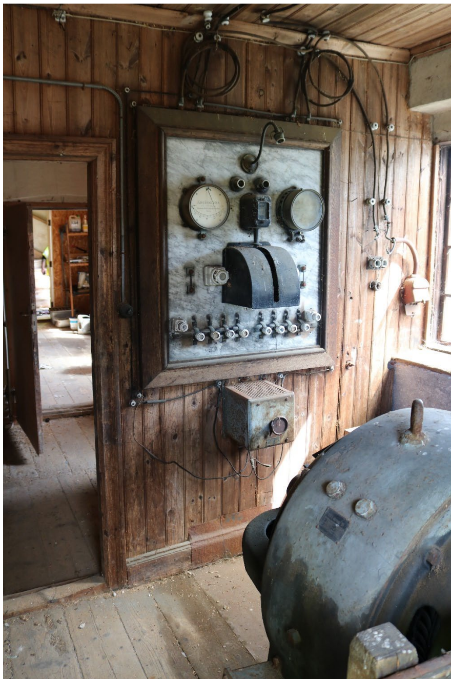
Figur 31. Maskinrum med manövertavla i marmor och ursprunglig elektisk utrustning.
