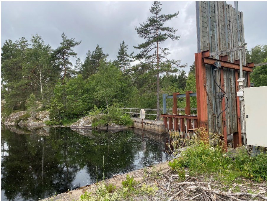
Figur 58. Dammen med intagets planluckor i förgrunden.
