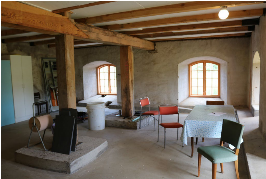
Figur 46. Interiören i kraftverket har nyligen renoverats men det synliga bjälklaget och djupa fönsternischer vittnar om byggnaders ålder.
