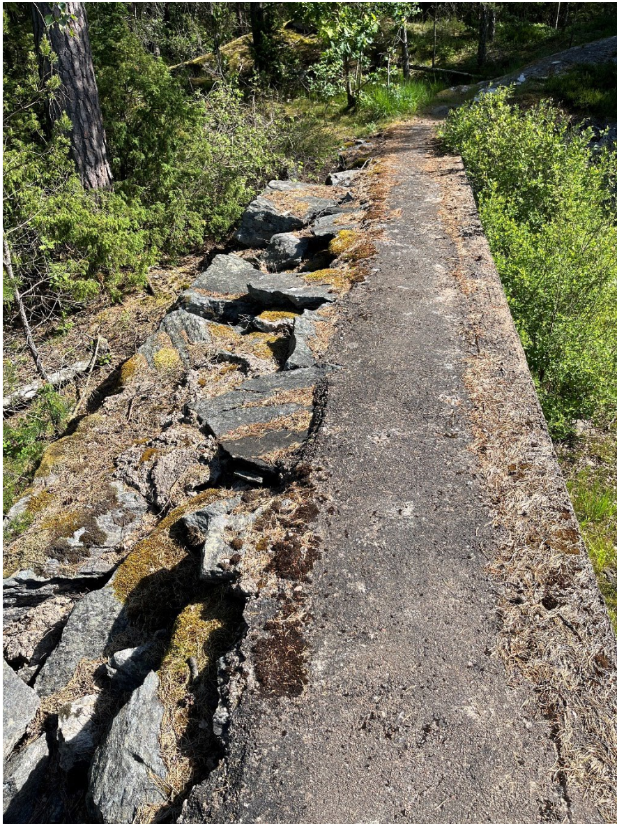
Figur 25. Den gamla dammkroppen av natursten finns kvar och på dammkrönet syns tydligt de två årsringarna.
