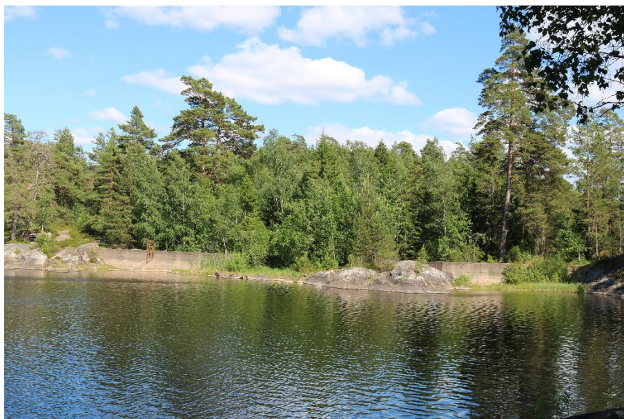
Figur 24. Vy över Dammsjödämmet med dammluckan till vänster i bild.
