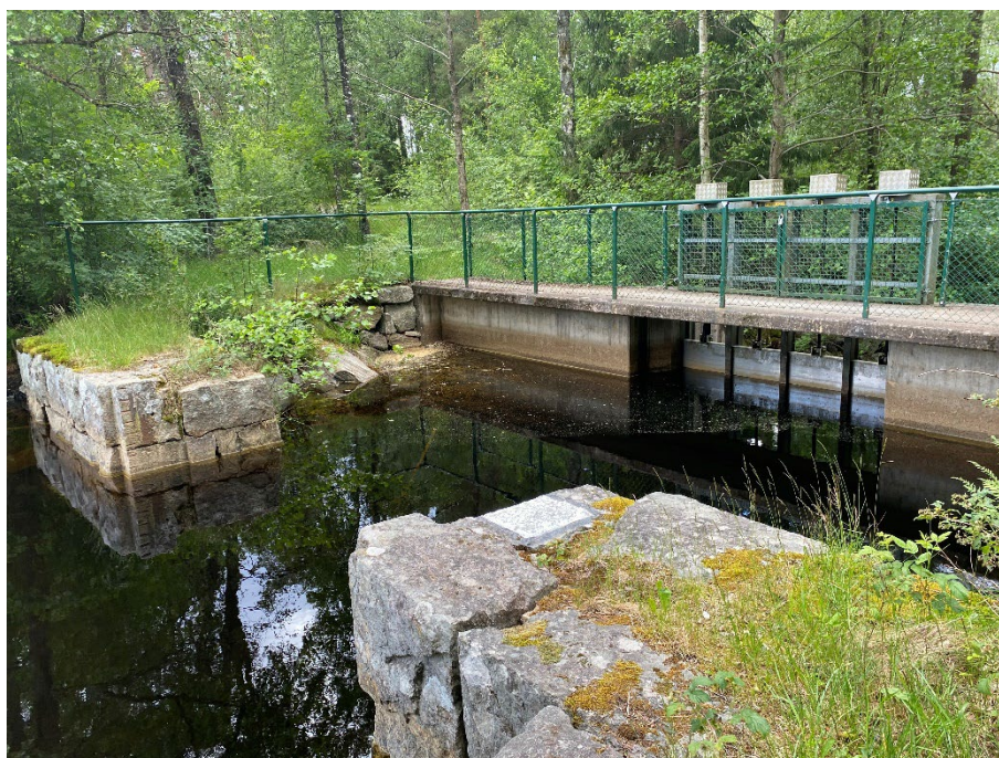
Figur 16. Befintlig betongdamm för avbördning av Ömmern vid höga flöden. Rester av en äldre damm i förgrunden.
