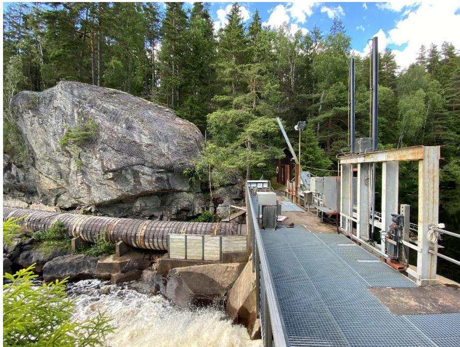
Figur 55. Dammen vid Melltorp, med trätuben i bakgrunden.
