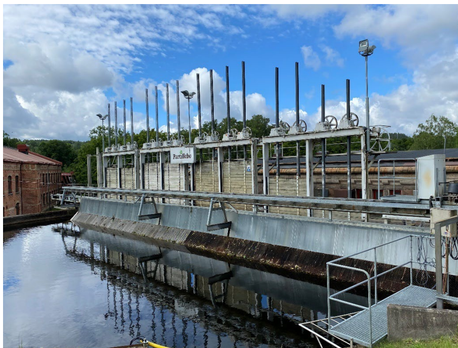
Figur 4. Intaget med rengaller och åtta luckor som manövreras med kugghjul.
