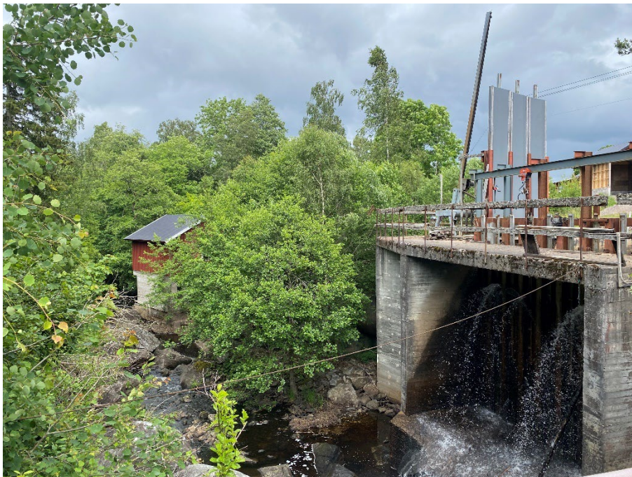
Figur 56. Greva kraftverk till vänster och dammen till höger.
