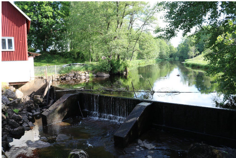
Figur 38. Ängatorps damm är en överfallsdamm med strävpelare i betong.
