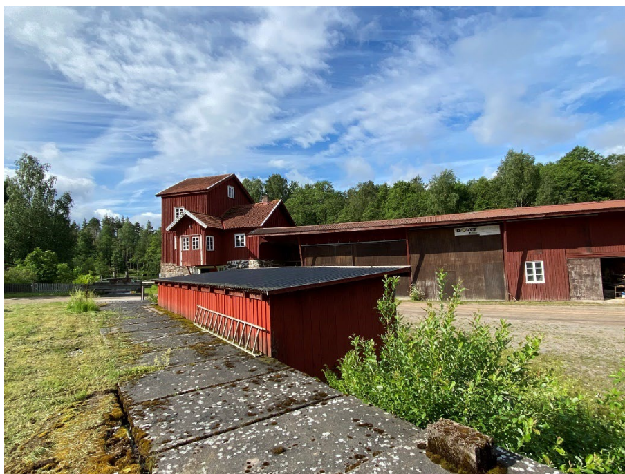
Figur 49. Kvarnen till vänster, hyvleriet till höger och intagsrännan till sågens turbin i förgrunden.
