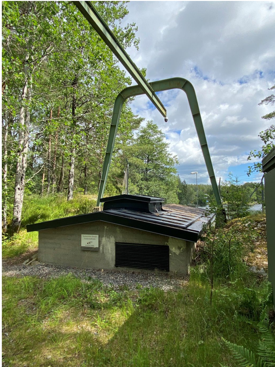
Figur 14. Travers över kraftverksbyggnaden för att kunna lyfta i och ur utrustning.
