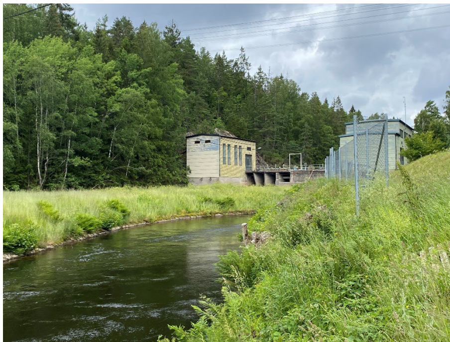
Figur 21 Utloppskanalen från Solveden 2.
