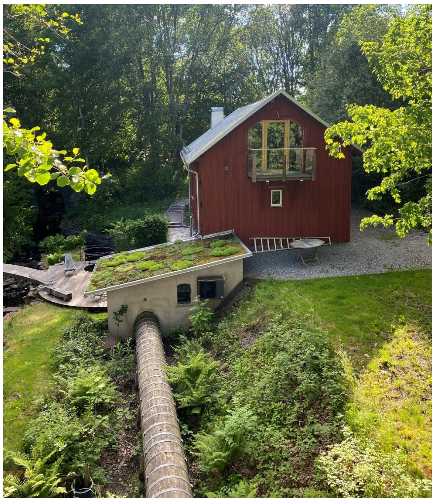
Figur 22. Hjälmares före detta kvarnbyggnad med den utbyggda kraftverksbyggnaden i puts.
