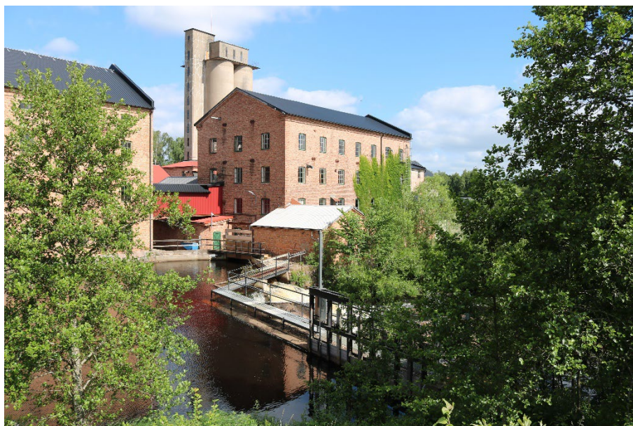
Figur 42. Vårgårda grynkvärn sett från söder. I bakgrunden syns silobyggnader, och till vänster det gamla magasinet. I förgrunden syns dammen i betong och natursten.
