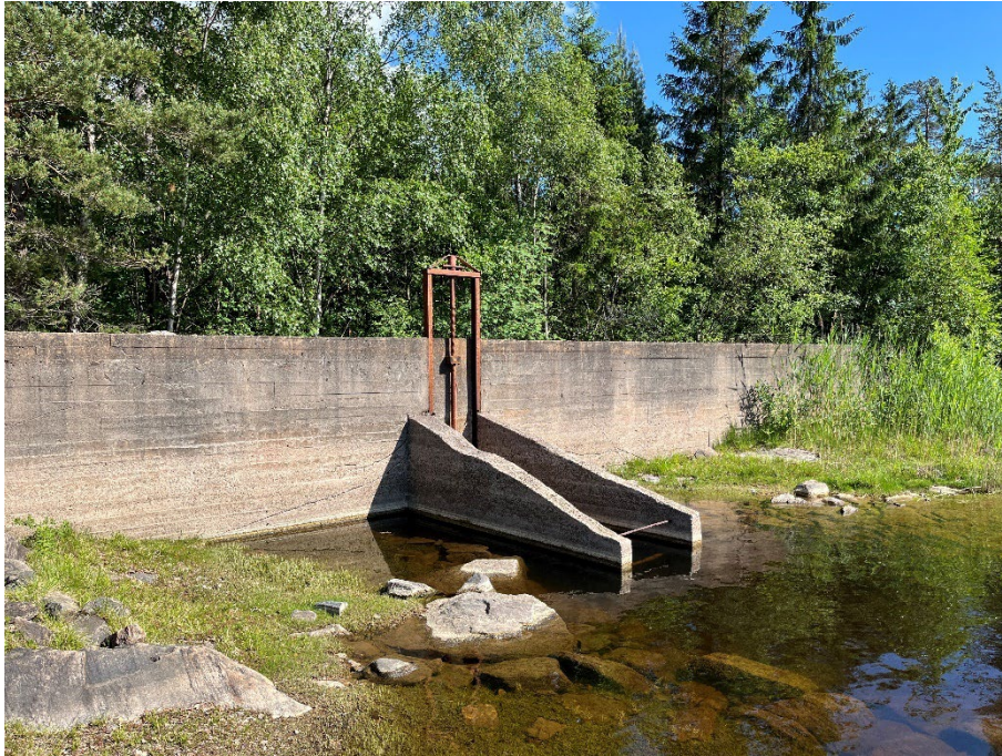
Figur 26. I dammen finns en smal bottenlucka i metall.
