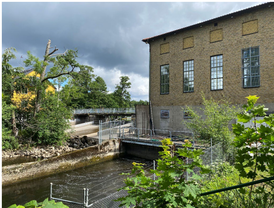
Figur 10. Kraftverket med utloppskanal i förgrunden, dammen i bakgrunden.
