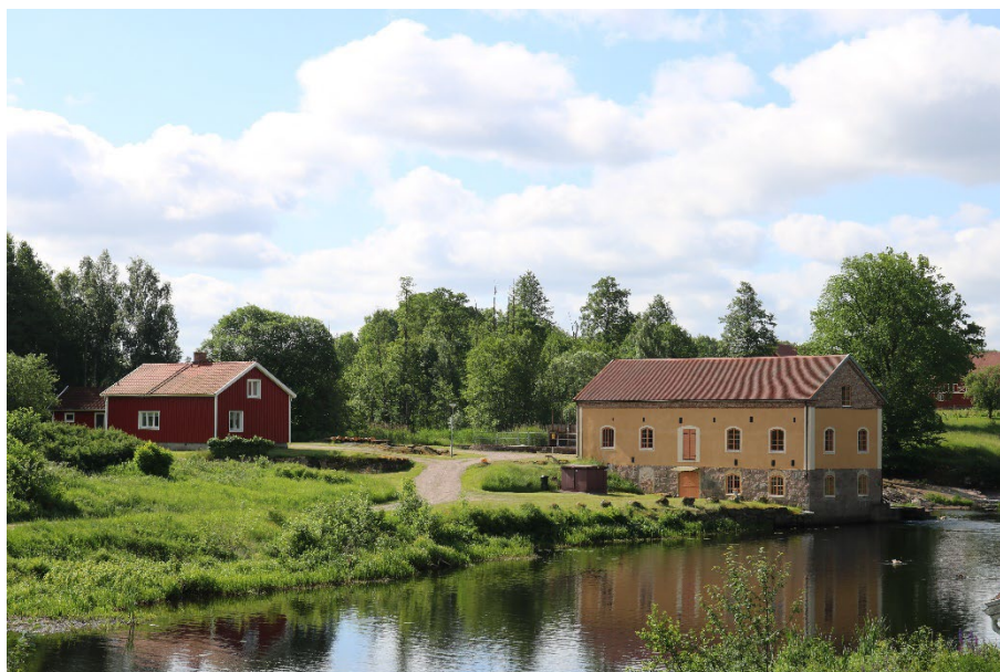
Figur 45. Hjultorps kraftverk med intilliggande mjölnarbostad.
