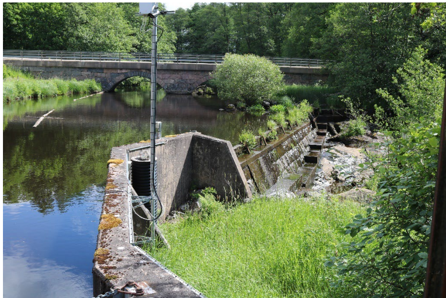
Figur 33. Dammen vid Källafors där stenvälsbron syns i bakgrunden.
