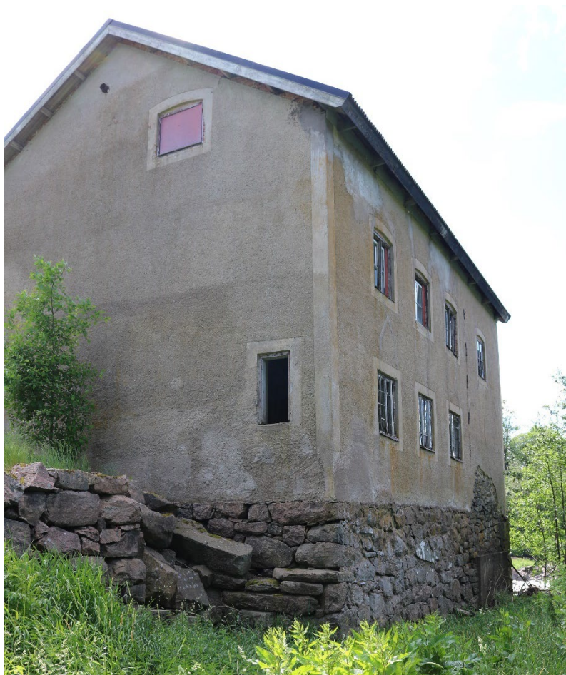
Figur 30. Källafors gamla kvarn med sockel av natursten och spritputsad fasad.
