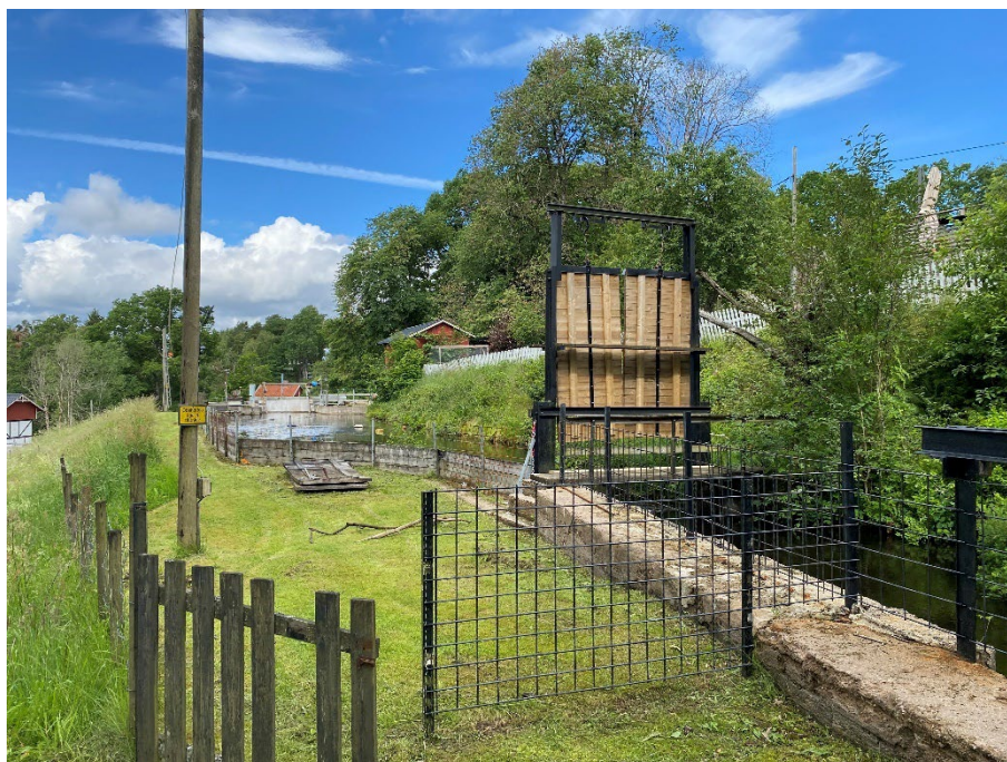
Figur 41. Intagskanalen med planluckor i trä, intagets rensgaller skymtar i bakgrunden.
