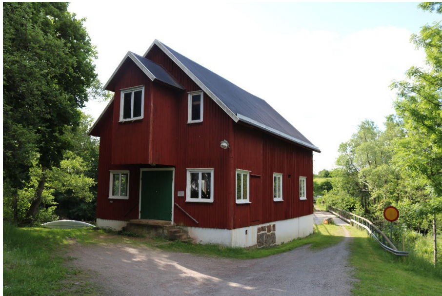
Figur 36. Ängatorps kraftverk med tidstypisk utformning från sekelskiftet 1900.
