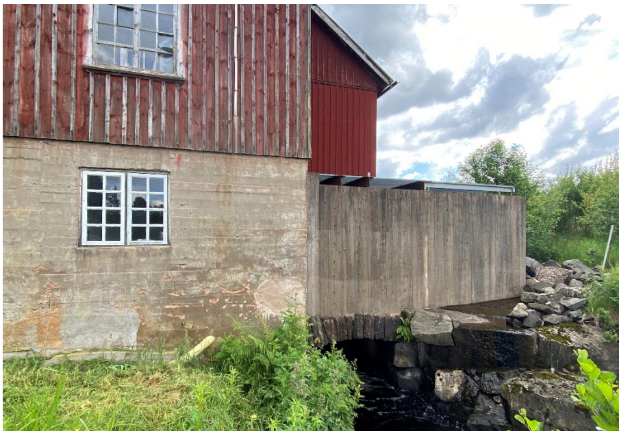
Figur 63. Norrfasaden med tillbyggnad från 1930-talet samt turbinump.
