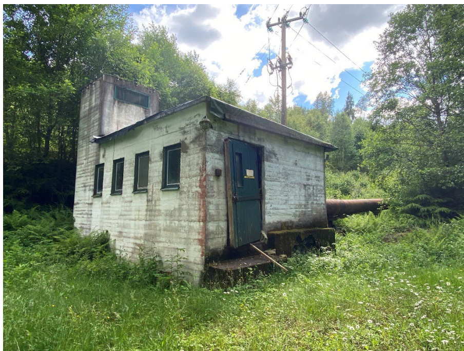
Figur 72. Kraftstationsbyggnaden i betong, tuben skymtar i bakgrunden.
