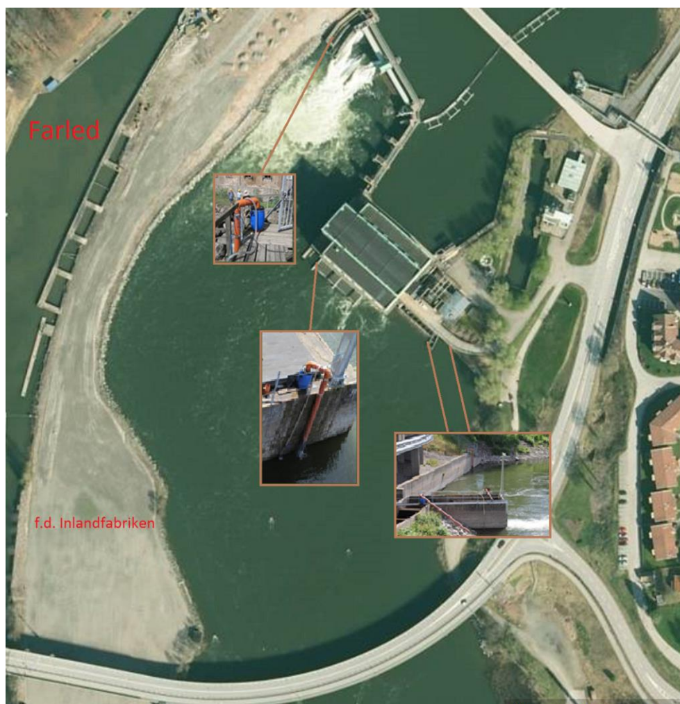
Figur 4. Placering av de nu aktuella ledarna för uppvandrande ål i Lilla Edet. Ålledarnas numrerade från höger: nr 1, närmast stranden, skymtar i skuggan mitt i den infällda högra bilden, nr 2 syns framför den tekniska fiskvägen "nya laxtrappan"; nr 3 på mittersta infällda bilden; nr 4 vänstra infällda bilden, återfanns första året på den "gamla laxtrappan" och mynnar vid den gamla ålledaren vid f.d. Inlandsfabriken. Tidigare ledare benämndes "vänster strand" och "höger strand" ungefär placerade där nr 4 respektive nr 1 nu finns.
