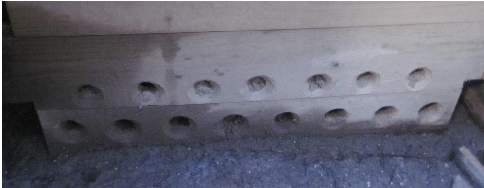
Foto inifrån ålsamlaren ("ålkistan") längst upp i den gamla ej fungerande ledaren vid Inlandsfabrikssidan i Lilla Edet (foto författaren).
