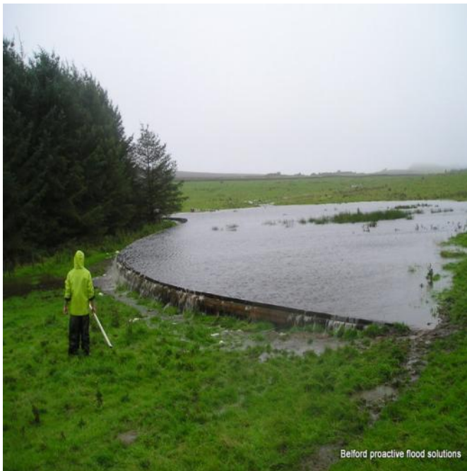
Bild 37. Barriären från bilden ovan efter kraftigt regn. Foto: The Belford Project.
