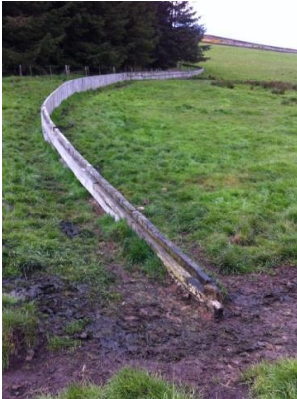
Bild 36. Uppströms Belford, England. Träkonstruktion i sluttning på betesmark för att fördröja vatten som flödar ovan markytan, för att hindra höga flöden i vattendraget. Foto: Anita Bergstedt.
