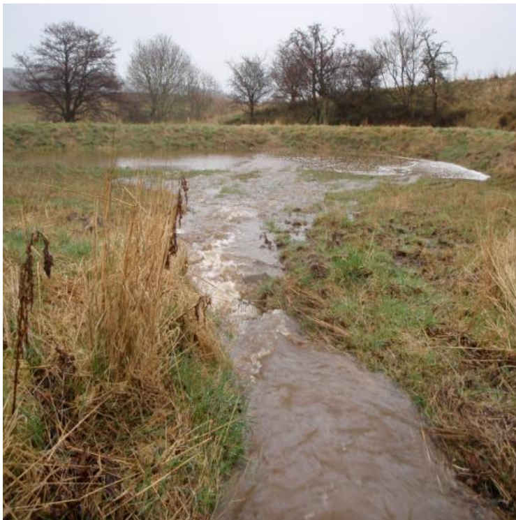
Bild 45. Uppströms Belford, England. Ett mindre område i en meanderbåge (krök på vattendraget, vattendraget följer trädraden) används för att magasinera högvatten som leds ut i ytterkant av en uppströms liggande meanderbåge, i en lågpunkt som är skild från vattendraget med en vall. Avsatta sediment kan eventuellt användas på åkern som jordförbättring och gödsling när området behöver rensas för att återfå sin lagringsförmåga. Foto: The Belford project.
