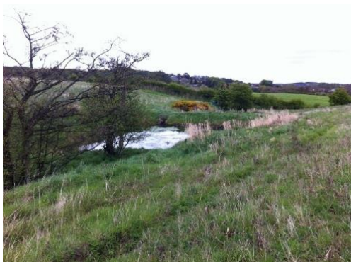
Bild 34. Damm med mindre trumma genom höjd fördämning uppströms Belford, England. Anläggningen släpper vattendragets medelflöde genom trumman, medan större flöden däms upp. Antingen kommer det dämda vattnet att successivt passera genom trumman (vilken bör vara halv med naturlig botten), alternativt blir det så mycket att det även bräddar över fördämningen under en period. Foto: Anita Bergstedt.
