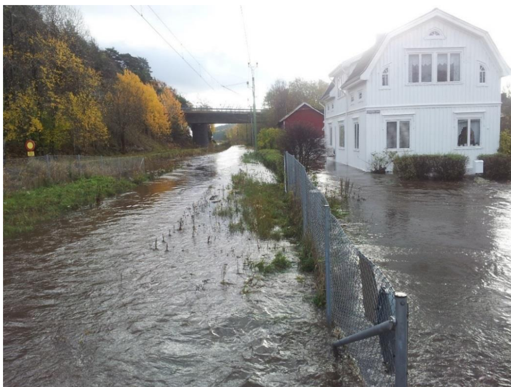
Bild 10. Översvämningar orsakar stora skador på byggnader och infrastruktur. Här järnvägen mellan Göteborg och Strömstad, vid Skee, Strömstads kommun. Foto: Strömstads kommun.
