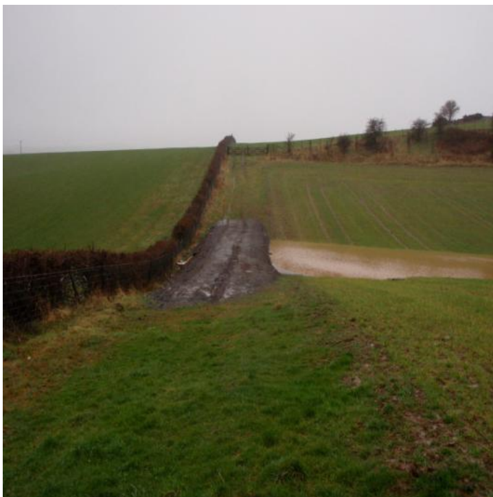
Bild 32. Uppströms Belford, England. Markägaren har fått en bra markväg, samtidigt som vatten efter häftigt eller långvarigt regn uppströms den förstärkta vägen fördröjs, så att flö- destoppen i Belford burn blir lägre och längre än tidigare. Foto: The Belford project.
