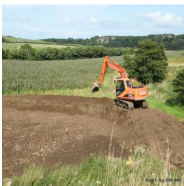
Bild 35. Uppströms Belford, England. En vall anläggs i en sluttning för att fördröja tillförsel av vatten till Belford burn, vars tidigare hastigt höjda flöden brukat orsaka problem i Belford. Områdets lagringskapacitet har ökat genom att material tagits från områdets centrala delar och lagts upp i en vall som fördröjer att vattnet kommer till bäckfåran. Foto: The Belford Project.
