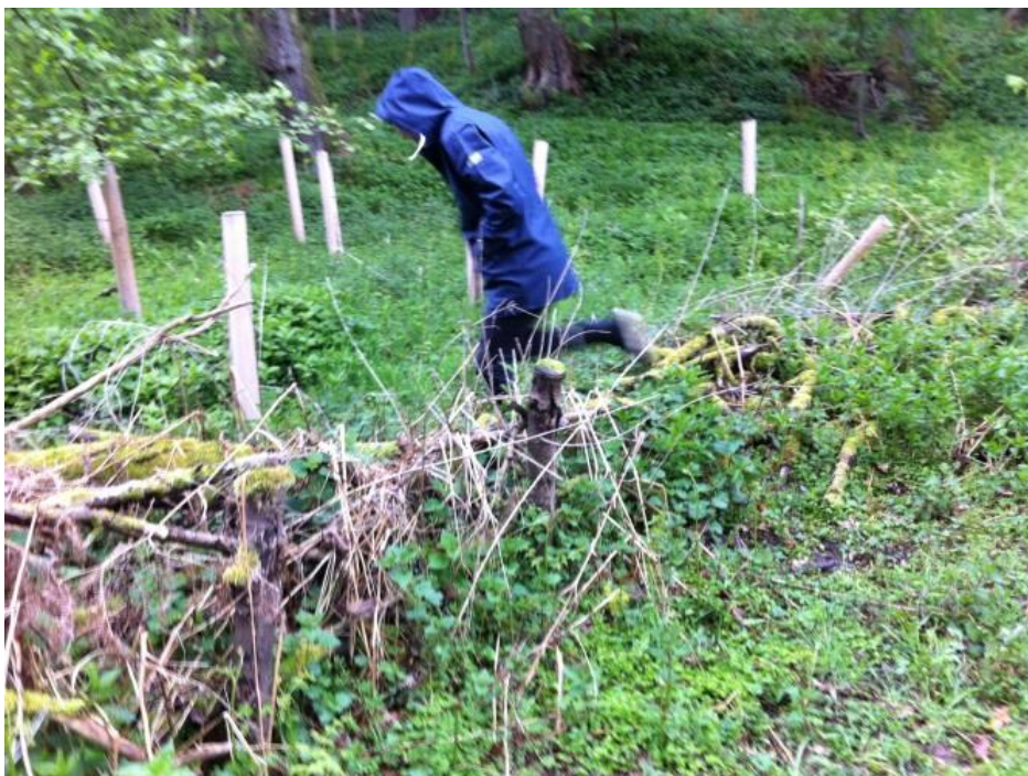
Bild 41. I det område som översvämmas på grund av stockarna i bäcken ovan, har barriärer av ihopflätade grenar skapats och plantering utförts för att ytterligare bromsa vattnets hastighet så att det kan hållas kvar längre och infiltrera i marken. Uppströms Belford, England. Foto: Anita Bergstedt.
