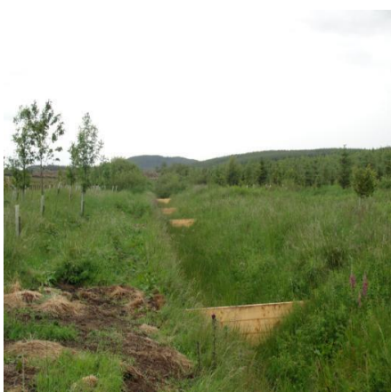
Bild 39. Serie med träplank som dämmer höga flöden i ett tillrinnande dike till Belford burn, England. Planken är öppna i botten för att inte påverka medelvattenflödet och därmed hindra vattenlevande organismer att förflytta sig. Foto: The Belford project.
