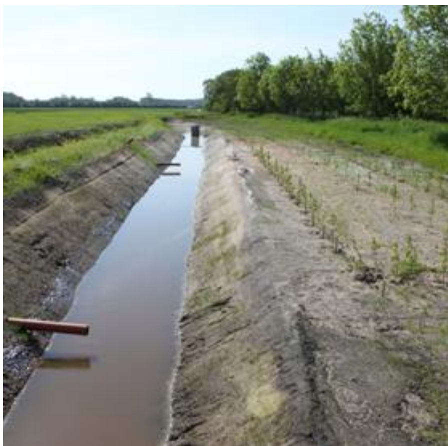
Bild 21. Integrerad skyddszon där åkers dräneringsrör mynnar i en ränna i åkerkanten. Kommer det mycket vatten, kommer detta att stiga upp över den trädplanterade infiltrationsbanken för att renas, avdunsta och infiltrera. Foto: Hushållningssällskapet i Halland.
