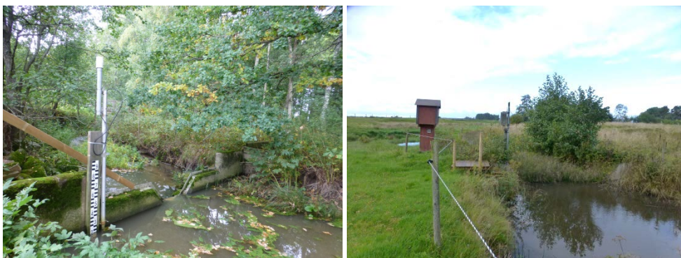
Figur 4. Triangulärt överfallsvärn med tryckgivare för registrering av flödet vid område O14 (vänster) och O17 (höger).
