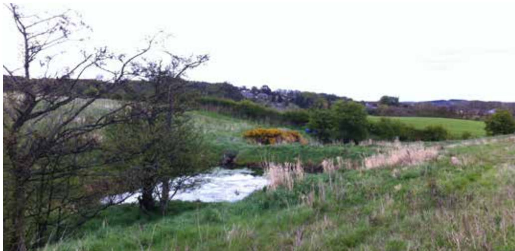
▲ Damm med mindre trumma genom höjd fördämning. Anläggningen släpper vattendragets medelflöde genom trumman, medan större flöden däms upp. Det dämde vattnet kommer successivt att passera genom trumman, vilken bör vara halv med naturlig botten. Om det blir mycket vatten kan det även brädda över fördämningen under en period. Foto: Anita Bergstedt.
