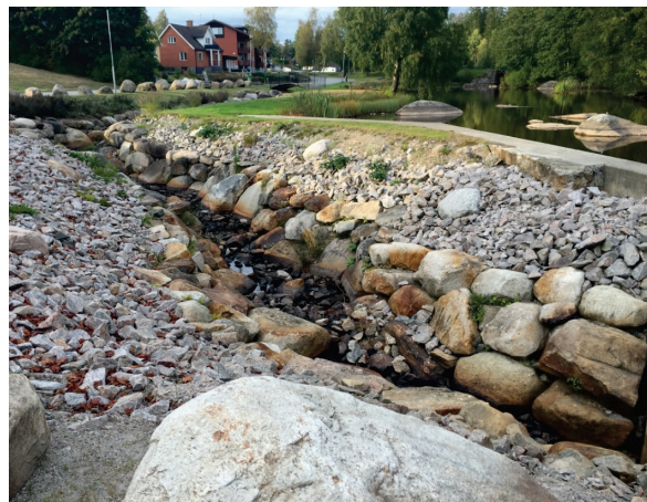
Figur 9 och 10. Vänster: Största fiskvägen vid inventeringen, flöde ca 4,5-5 m 3 /s (Mörtfors, Kalmar län, ID4693). Höger: Exempel på fiskväg utan vatten (Sibbhults parkdamm, Skåne län, ID5009).
