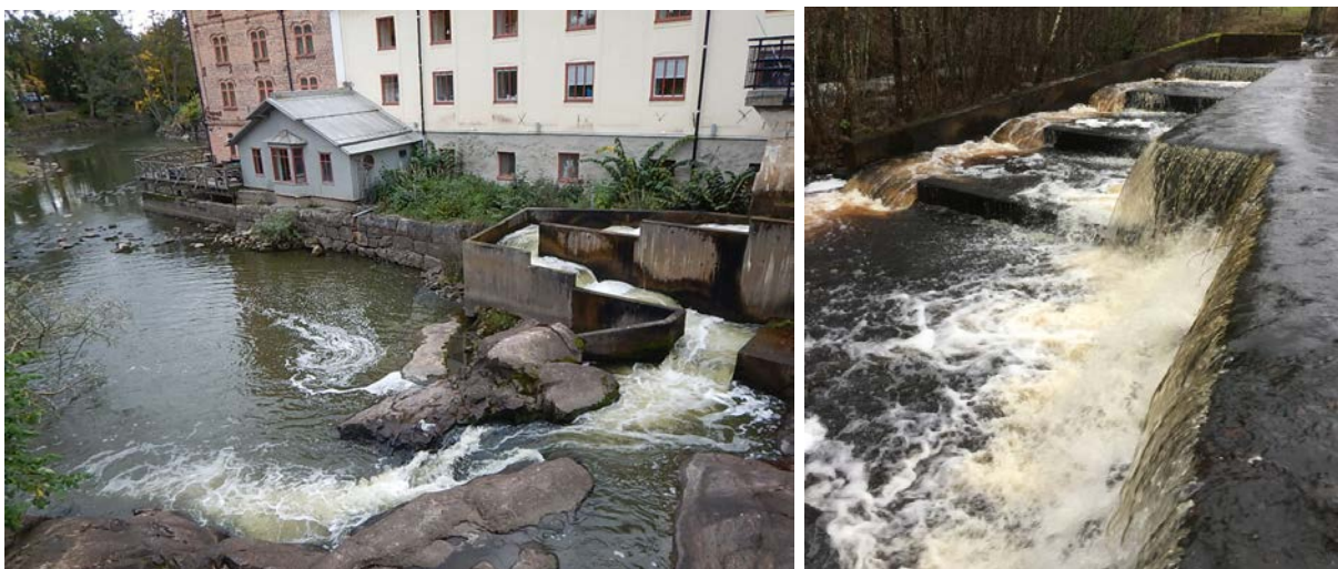
Figur 13 och 14. Vänster: Dålig anlockning långt från turbinutloppet (Nyköpingsån, Södermanlands län, ID80). Höger: Bra anlockning intill dammen (Slissån, Hallands län, ID629).
