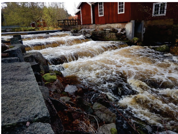
Figur 9 och 10. Vänster: Största fiskvägen vid inventeringen, flöde ca 4,5-5 m 3 /s (Mörtfors, Kalmar län, ID4693). Höger: Exempel på fiskväg utan vatten (Sibbhults parkdamm, Skåne län, ID5009).
