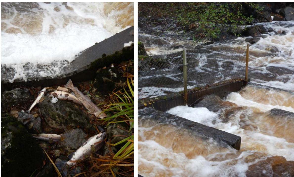
Figur 18 och 19. Vänster: Öringar som nyligen hoppat utanför fiskvägen och dött (Broälven, Västra Götalands län, ID93). Höger: Fiskväg med uppmonterat hoppskydd (Smedjeån, Hallands län, ID649).
