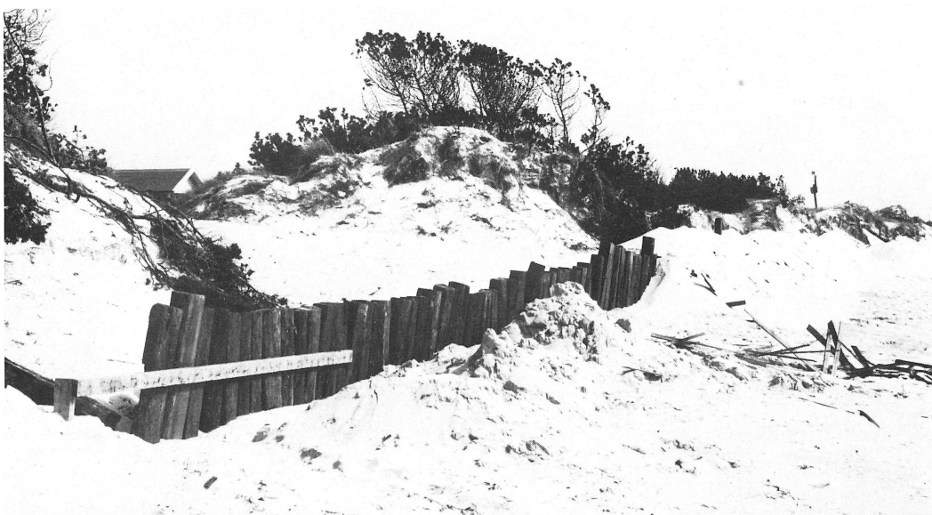
Foto 29. Kraftiga palissader mäktar sällan stå emot havets vågor under högvatten och storm. Tillfälligt kan de dock fungera, även som sandfälla för vindens sandtransport. Här har järnvägssyllar kommit till användning vid Falsterbo (objekt 24). Jämför foto 43. Foto: Arne Schmitz/N.
