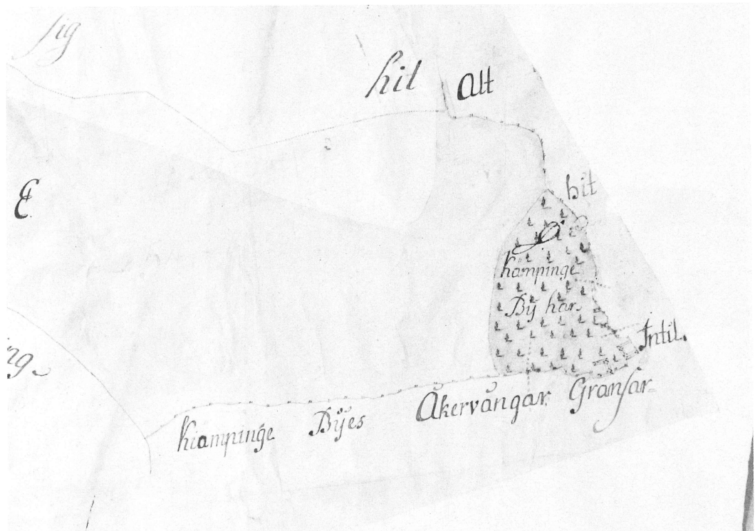
Foto 32. Kämpinge by har drabbats hårt av sandflykt. År 1761 dokumenterades läget i en lantmäteriakt som visar hur Skanörs Ljungs sandiga marker (objekt 26) tvärt slutar vid två stängsel väster och norr om Kämpinge by. Det västra stängslet utgör grunden för en antropogen dyn som visas i fig 31 och foto 34.
