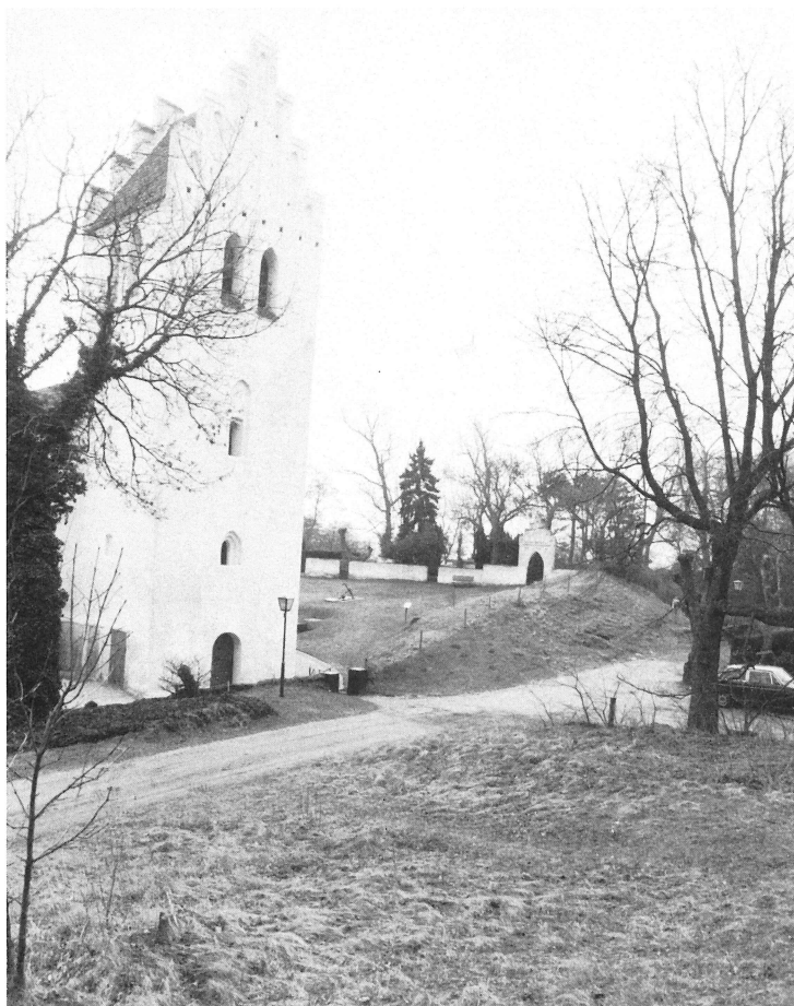
Foto 25. Falsterbo kyrka var på mitten av 1800-talet ytterligt nära att drabbas av översandning. Enligt uppgift skall alla besökare ha uppmanats att medtaga sand från kyrkan vid varje besök. Planlagda planteringsåtgärder vidtogs först 1849 efter ett möte med städernas beslutande och Hushållningssällskapet (objekt 24).
