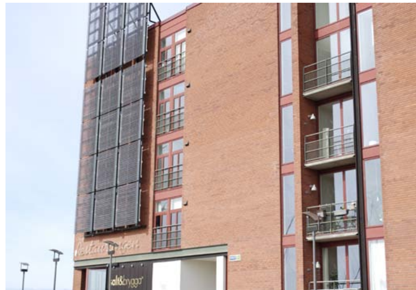
Solfångare, Västra Hamnen i Malmö
