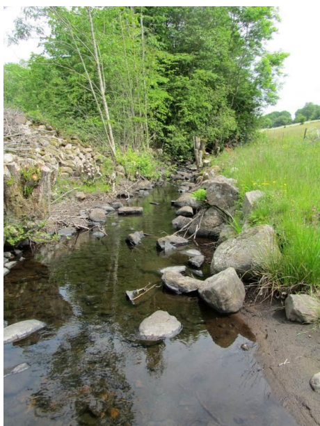
Foto 14. Sträcka 43 (A-protokoll). Åfåran är rensad och block ligger i högar på vänster sida på åslänten samt längs åns högra kant i vattnet. På sträckan är även flera träd nedsågade och borttransporterade.
