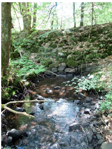
Foto 6. Dammdämme (vandringshinder 6) på sträcka 63 (A-protokoll). Dämmet utgör ett definitivt vandringshinder. Foto: Ekoll AB
