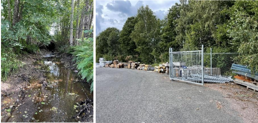
Figur 19. Glimån leds via en stor kulvert under industriområdet i Glimåkra som mynnar (t.v.) i höjd med grinden på den högra bilden. Därefter rinner ån utmed industriområdet, djupt nedskuren och kantad av en äldre lövridå (t.v.), för att nedströms industriområdet mynna i Kilingåån.
