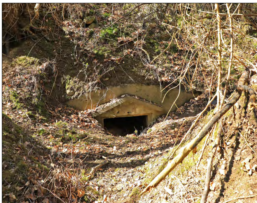
Figur 55. Skydds- och ammunitionsförråd under en av pjäsplatserna.
