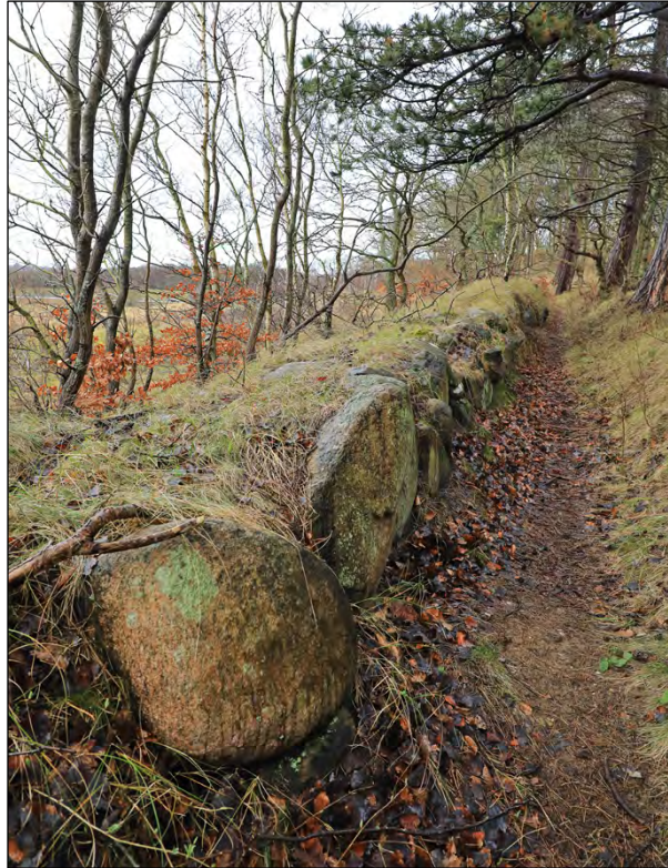
Figur 34. I den gamla inägo gränsen vid Tegelhuset löper en kraftig jordvall som under 1800-talet förstärktes med stora stenblock.
