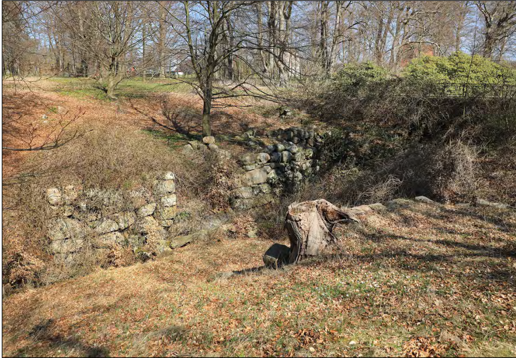
Figur 40. Rester efter en smedja? Nedanför den gamla "Smedjedammen" (1738) finns flera kallmurade partier som troligen utgör rester efter byggnader.
