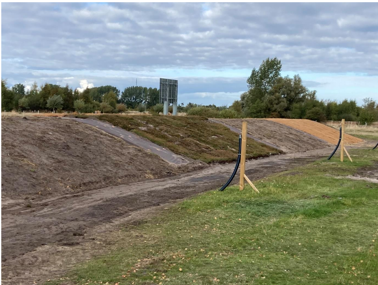
Figur 4. Skyddsvall i form av en prototypvall på Falsterbonäset som är avsedd för studier.
