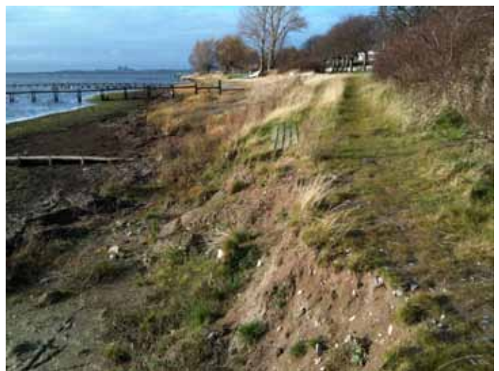
Bild 1. Erosion vid stranden i Bjärred. Många platser längs Skånes kust har problem med erosion idag och med en stigande havsnivå ökar problemen. Erosionsprocessen tar tid och kan saktas ner ytterligare med erosionsskydd, men upphör inte förrän systemet är i jämvikt.
