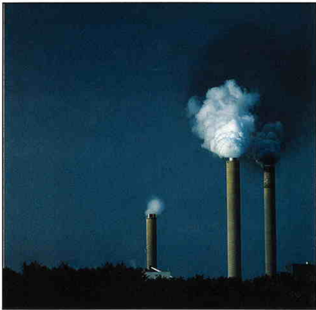
Skorstenarna på pappersbruket i Nymölla – en av länets största utsläppskällor av försurande svavel. Foto Hans Berggren.
