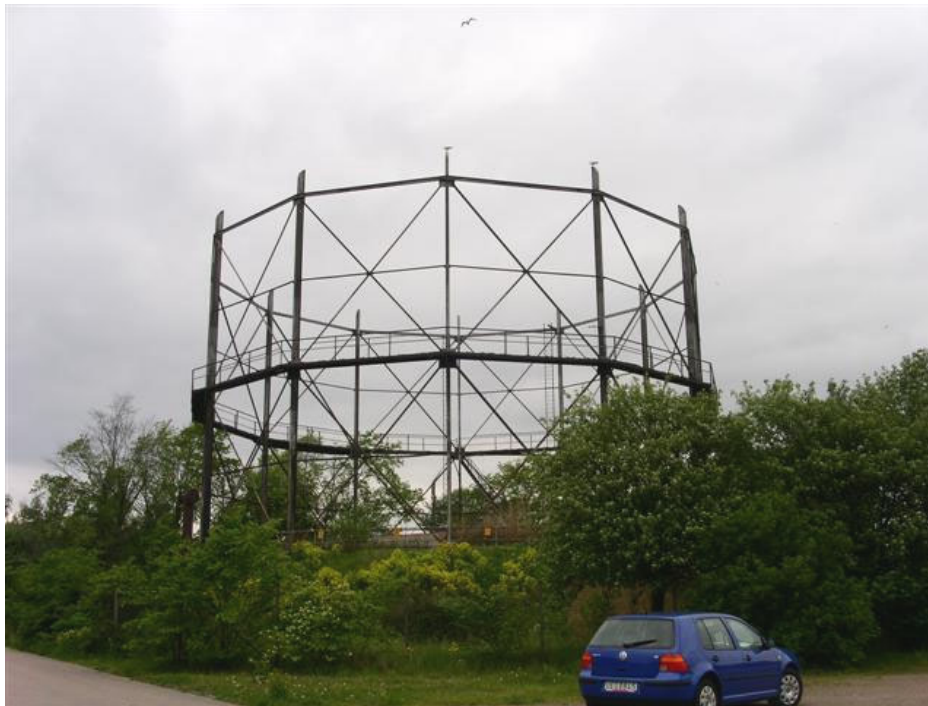
Figur 3. F d stora gasklockan inom kvarteret Viadukten.
