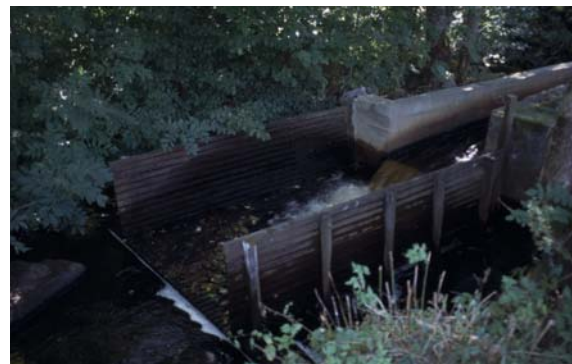
Älkista (vandringshinder nr 5). Definitivt hinder för öring och lax. Foto: Torbjörn Davidsson
