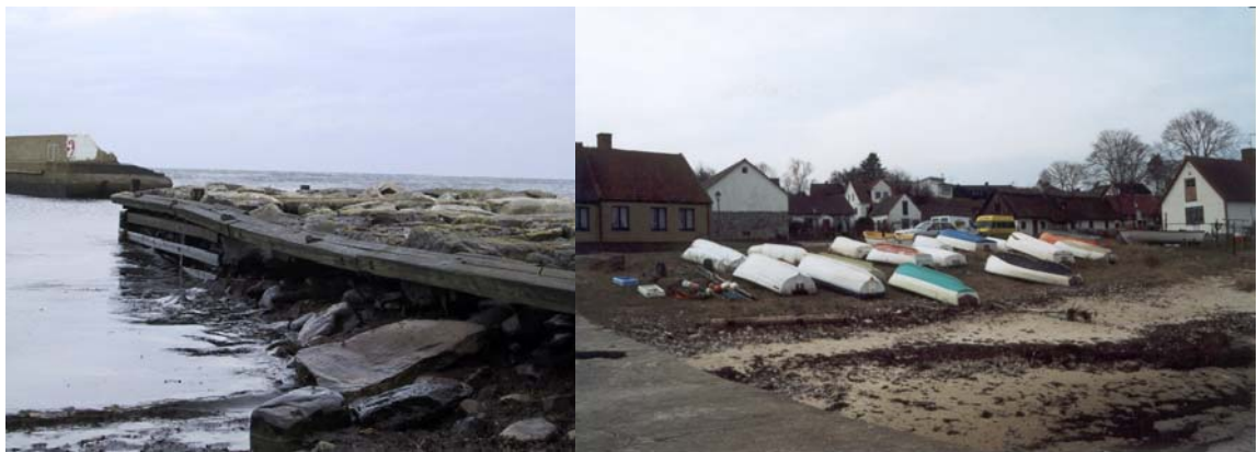
Stenkaret i Brantevik är ett av få bevarade i Skåne. Till höger Viks hamn med båtuppläggning på den naturliga stranden mellan pirarmarna.
