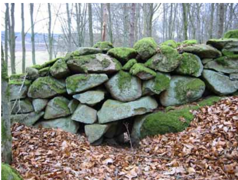
Fig 22. Detta hål i stengärdet har troligtvis reglerat vattenflödet i backen.
