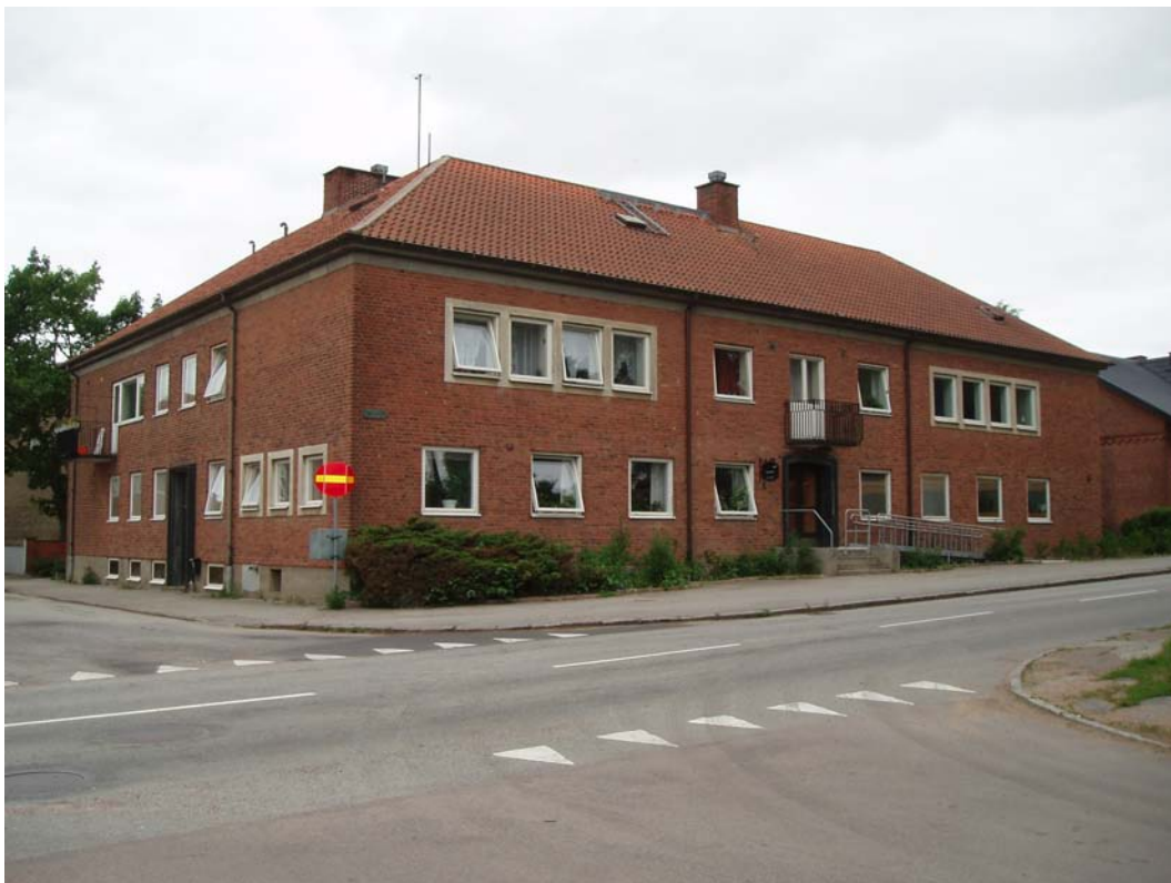
Teckomatorp 8:23. Kommunalhuset från 1955 med välbevarade fasader, tak, fönster och balkonger, endast en av entrédörrarna utbytt. Bevarandegrad 92%.
