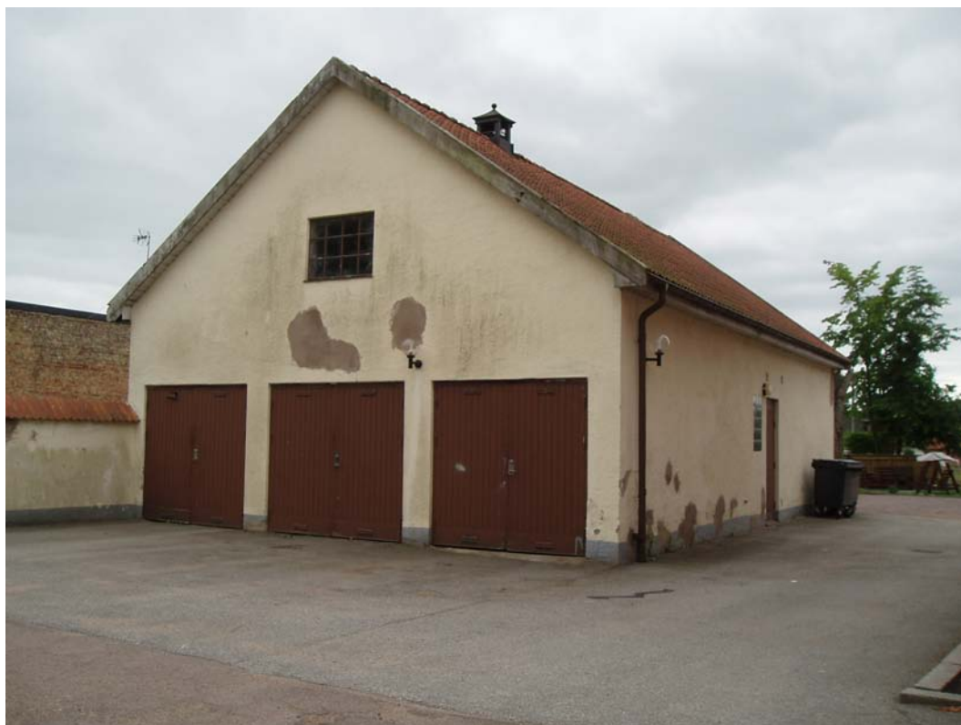
Teckomatorp 8:28. Hotellets stallbyggnad, en av de byggnader vars byggår är osäkert och satts till 1912. Bevarandandel 40 %.
