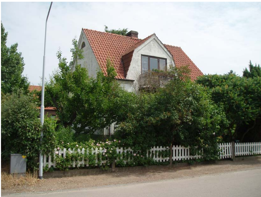
Teckomatorp 17:121. 1930-talsvilla med välbevarade fönster i funkisstil. Bevarandeandel 58 %.
