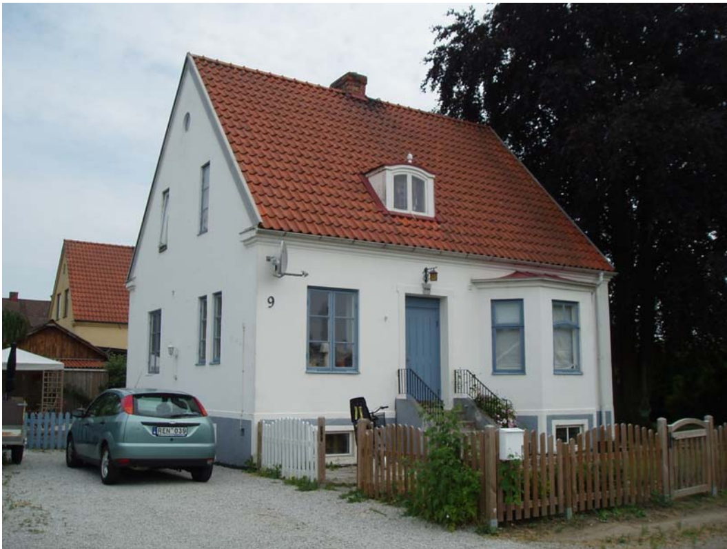
Teckomatorp 17:102. Typisk 1920-talsvilla med välbevarade fasader, tak (av tegel) och fönster, dock med utbytt entrédörr. Bevarandeandel 80 %.
