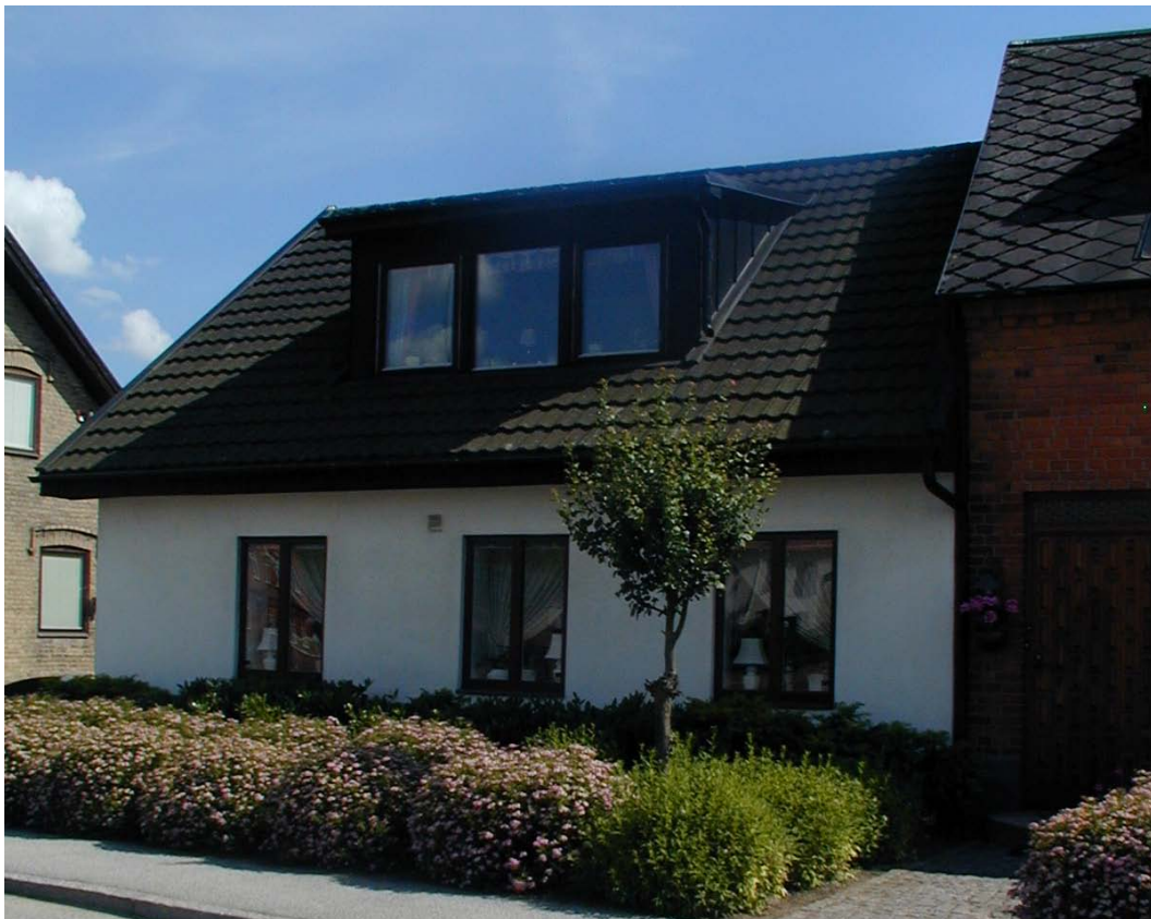
Teckomatorp 15:35. Hus från 1871 med delvis bevarad putsfasad, övriga byggnadsdelar förvanskade. Bevarandeandel 20 %.
