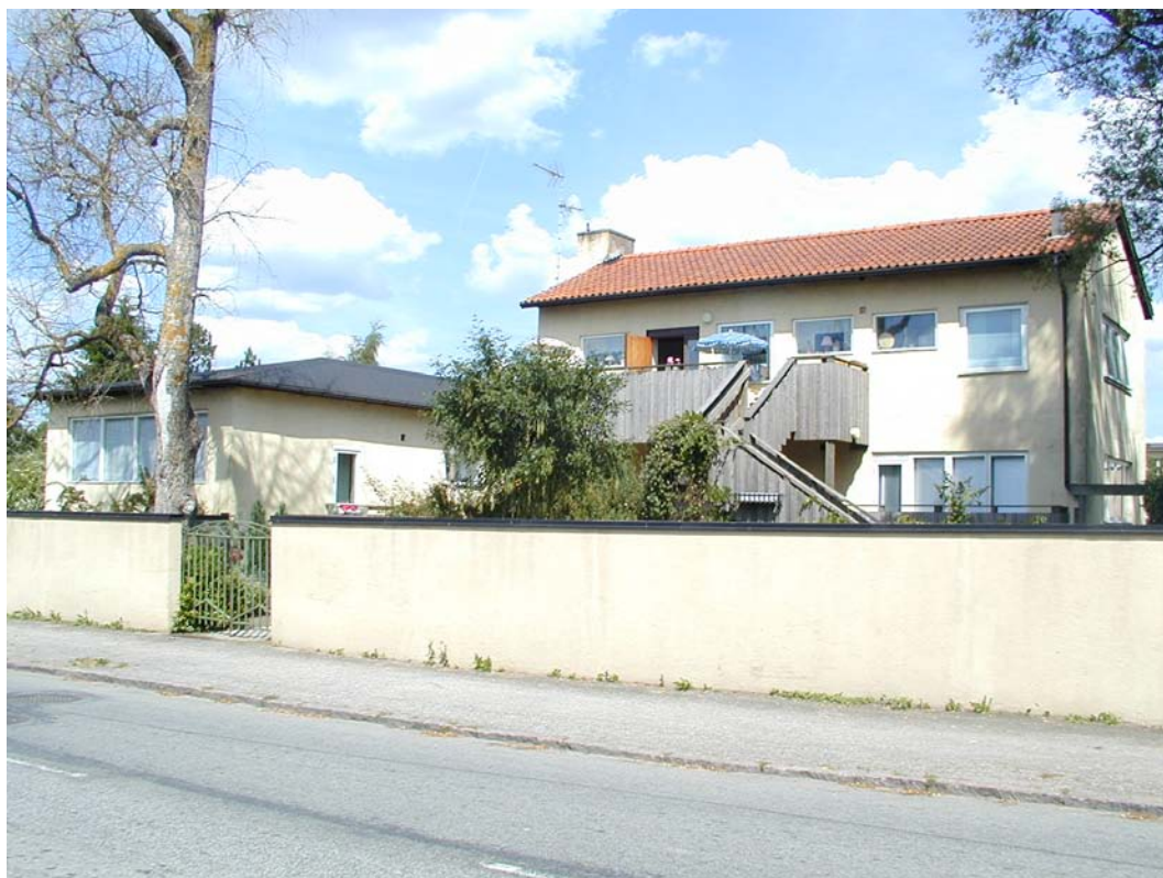
Teckomatorp 17:32. Teckomatorps första funkisbyggnad från 1932 som förvanskats med delvis förändrade fasader, delvis utbytt takmaterial samt utbytta fönster och dörrar. Bevarandeandel 30%.
