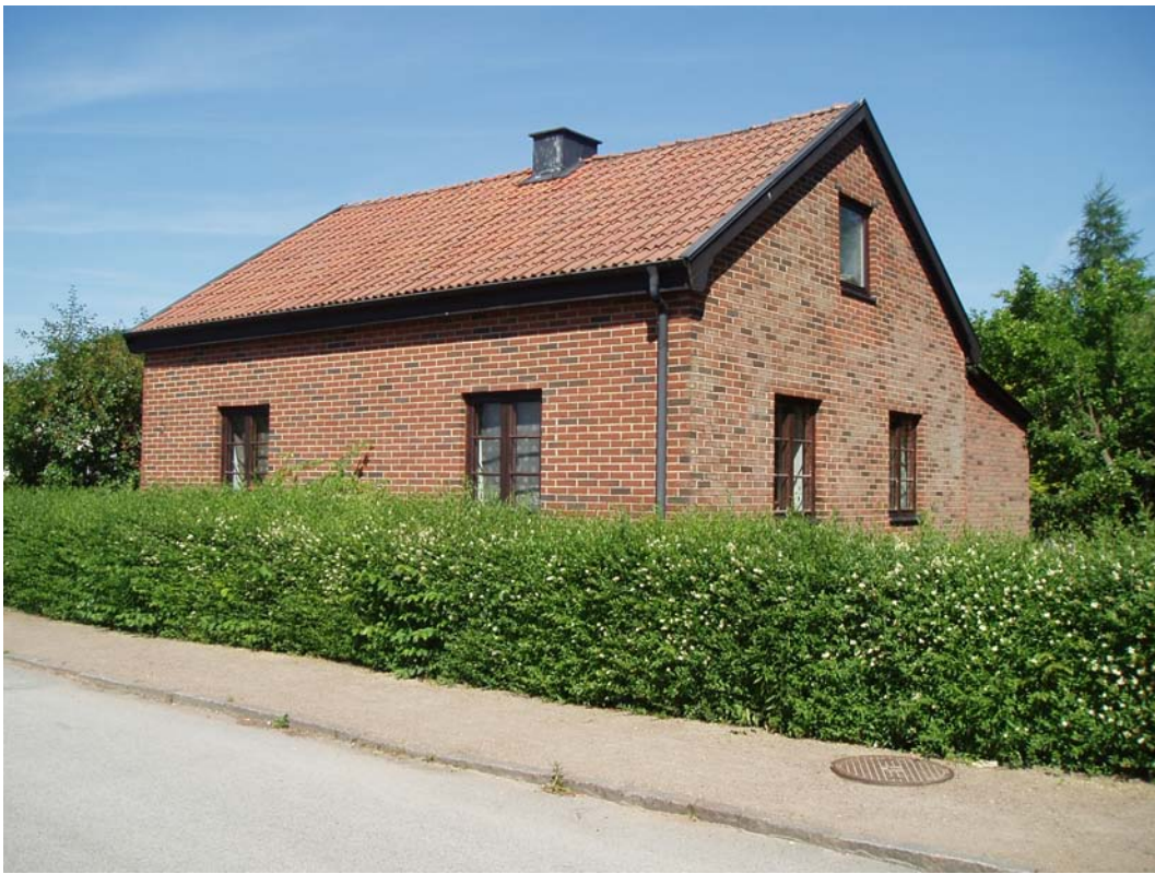
Teckomatorp 17:14. Hus från 1909 där fasaderna, taket och dörren förvanskats. Endast de anpassade fönstren får en poäng. Bevarandegrad 10 %.
