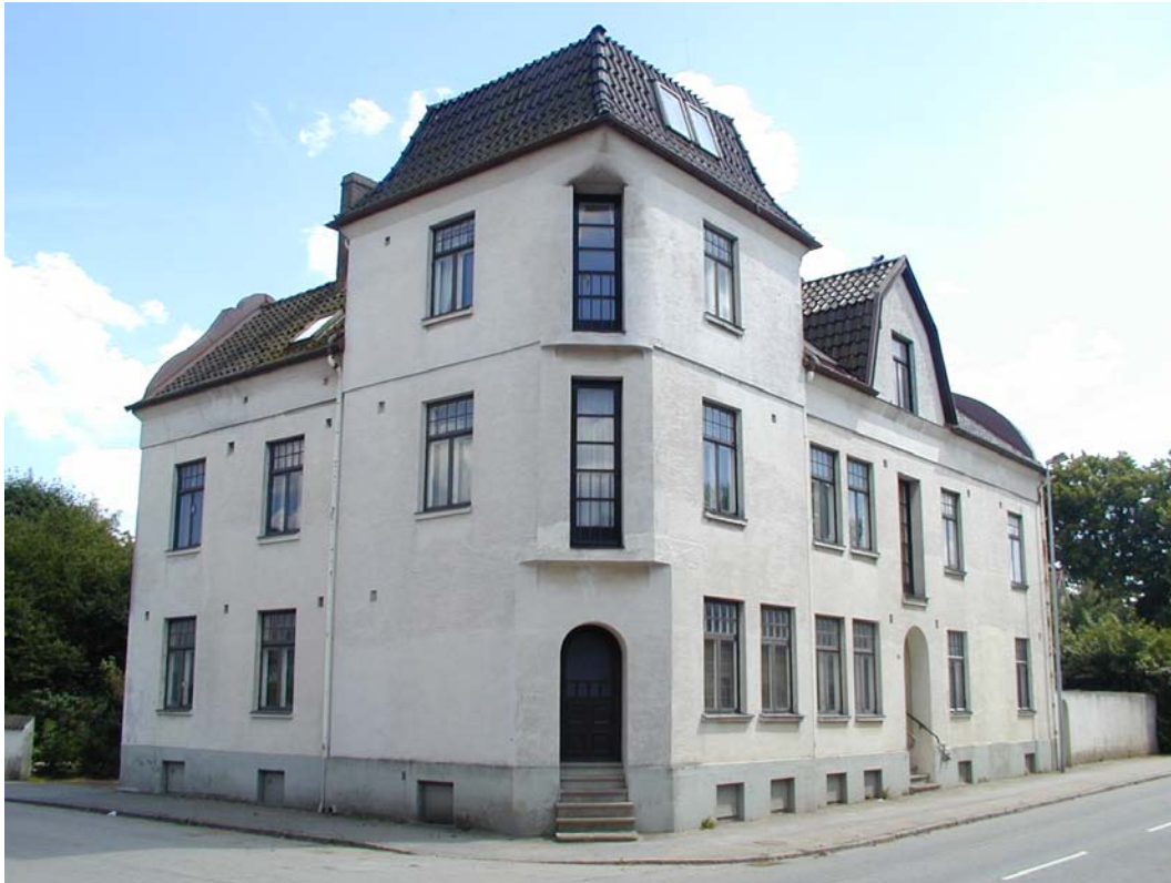
Byggnad med ungefär hälften av de ursprungliga fönstren kvar (Teckomatorp 17:1).
