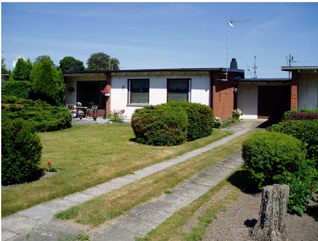
Teckomatorp 16:21. Ett av kedjehusen utmed Portgatan med utbytt tak och delvis utbytta fönster. Bevarandeandel 70 %.
