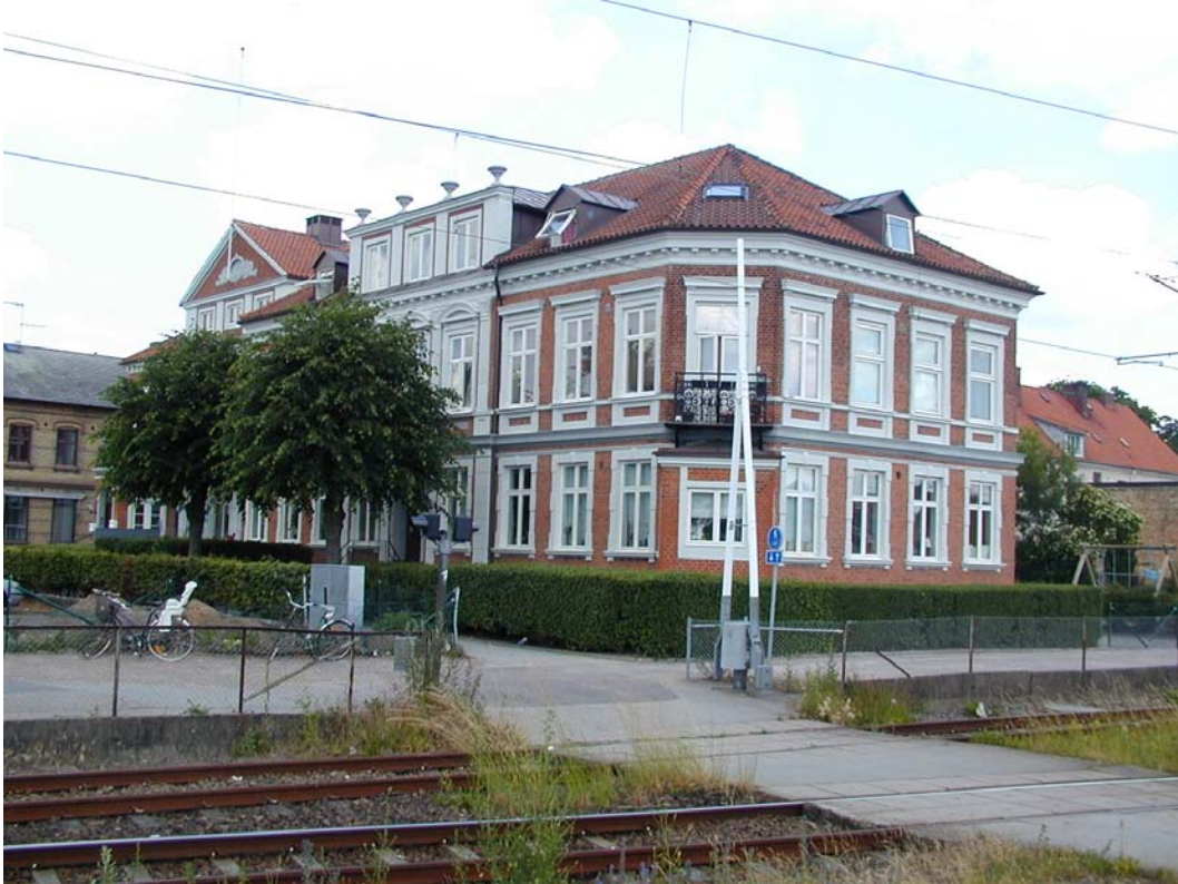
Teckomatorp 8:28. Hotellet från 1886 med ursprungliga fasader, anpassat tak, förvanskade fönster och dörrar samt originalbalkong. Bevarandeandel 58 %.
