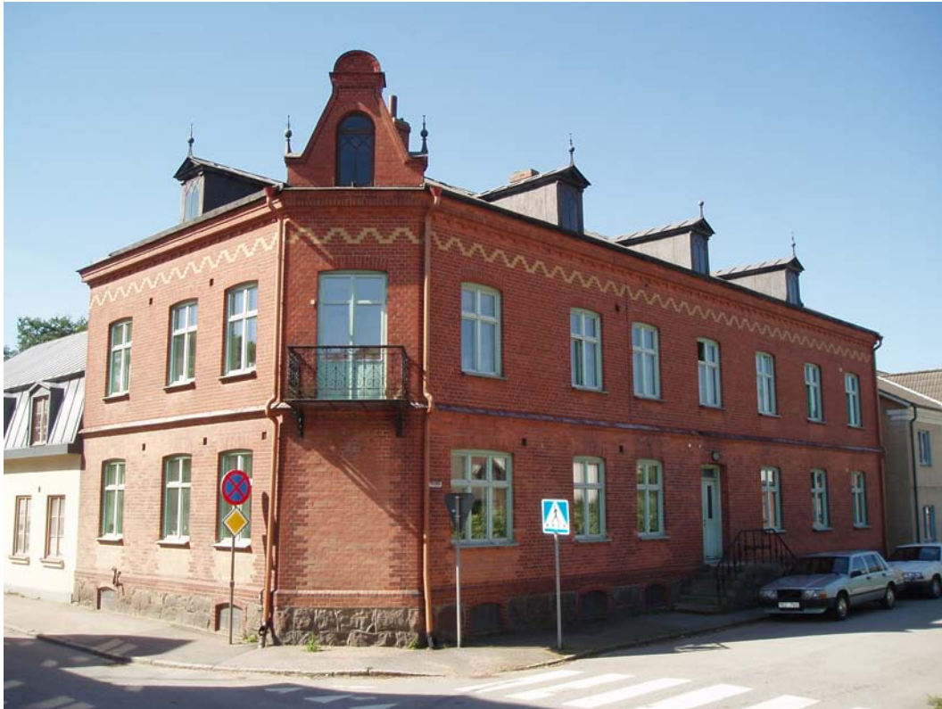
Teckomatorp 15:80. Hus från 1904 med delvis förändrade fasader, originaltak, förvanskade fönster, delvis förändrad entrédörr och ursprunglig balkong med gammalt smidesräcke. Bevarandandel 58 %.
