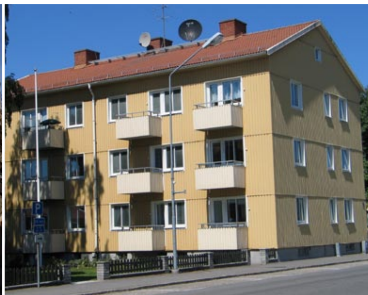
Bild 28. Fasad inklädd med plåt på 1940-talshus - 0 poäng. Foto Lotta Lamke.
