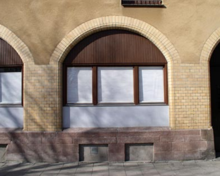
Bild 52. Delvis igensatt skyltfönster- 0 poäng. Foto Paul Hansson.
