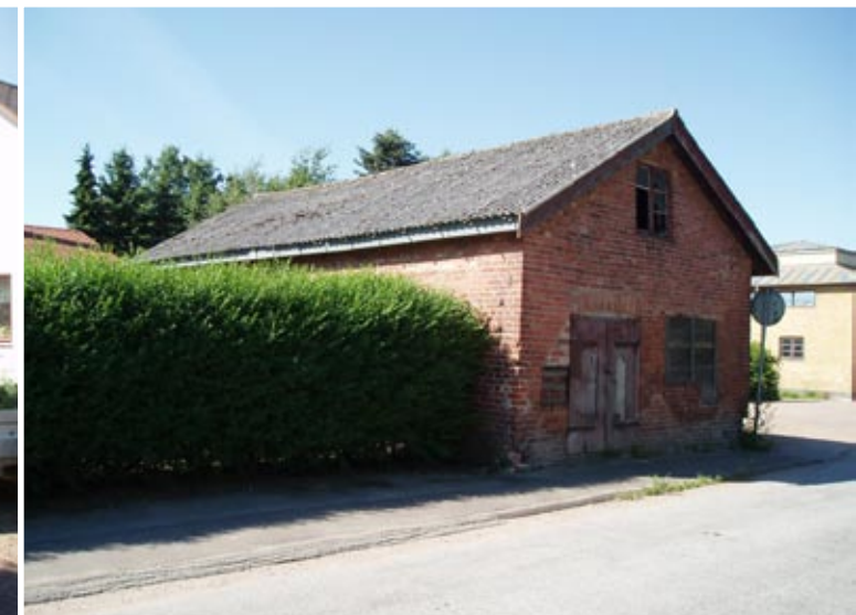
Bild 83. Komplementbyggnad i form av en ekonomibygnad. Poängsätts byggnadsdel för byggnadsdel: Fasad 4 poäng, tak 0 poäng, fönster 2 poäng och dörrar 2 poäng. Sammanlagd poäng 8 av 10 möjliga. Efter omräkning enligt ovan nämnda skala ges byggnaden 2 poäng av 2 möjliga. Foto Adam Katzeff.
