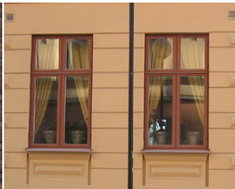
Bild 47. Nya men anpassade fönster; rätt proportioner och material men med planglas och moderna beslag - 1 poäng. Foto Linda Gustafsson.
