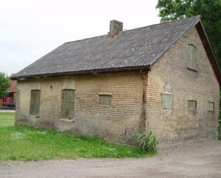
Bild 13. Hus med övertäckta fönster. Foto Adam Katzeff.
