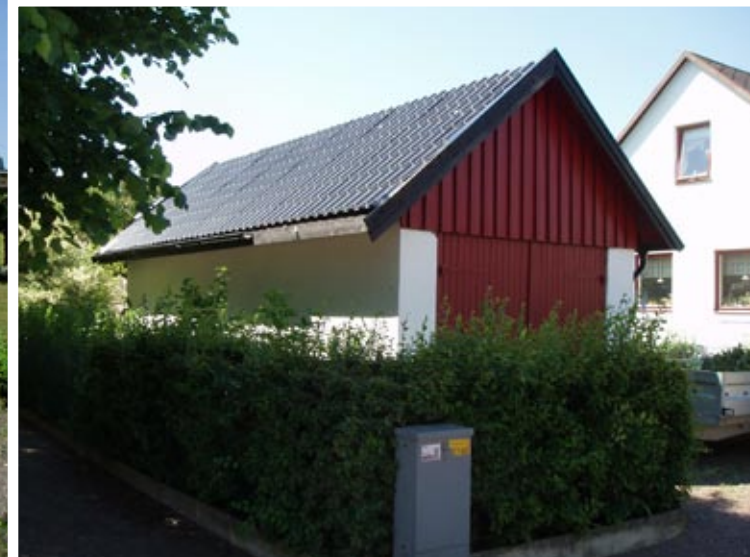
Bild 82. Komplementbyggnad i form av ett garage. Poängsätts byggnadsdel för byggnadsdel: Fasad 2 poäng, tak 0 poäng och dörrar 2 poäng. Sammanlagd poäng 4 av 8 möjliga. Efter omräkning enligt ovan nämnda skala ges byggnaden 1 poäng av 2 möjliga. Foto Adam Katzeff.
