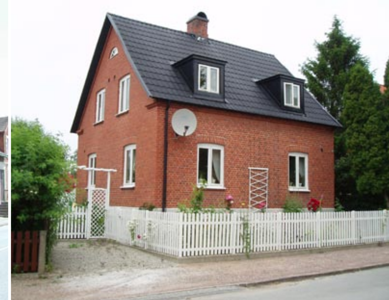
Bild 44. Villa från 1930 där taket försetts med nya kupor och beläggning av plegel - 0 poäng. Foto Adam Katzeff.
