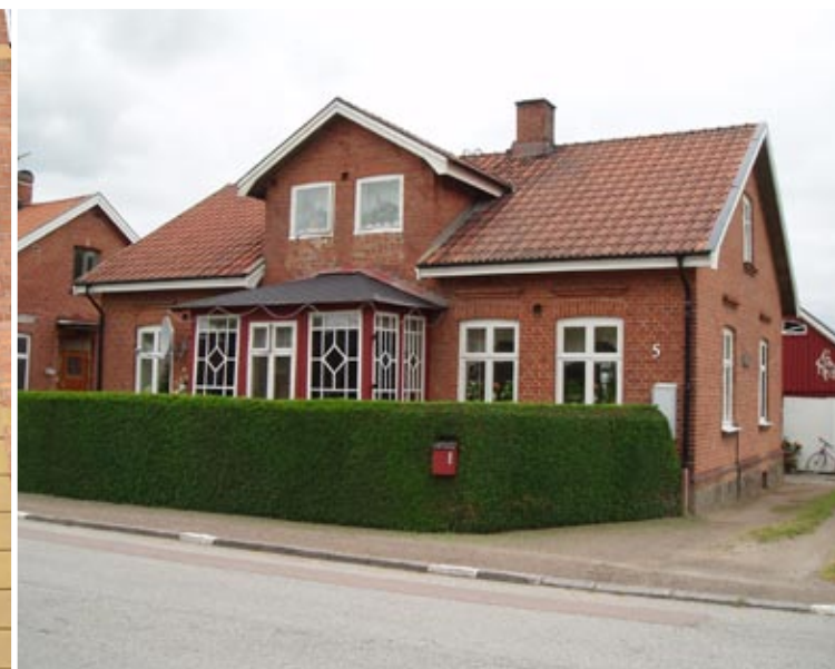
Bild 72. Ursprunglig och välbevarad glasveranda som räknas in under rubriken Balkonger - 2 poäng. Foto Adam Katzeff.
