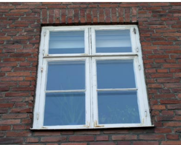
Bild 46. Originalfönster med gamla glas och beslag på 1920-talshus - 2 poäng. Foto Paul Hansson.
