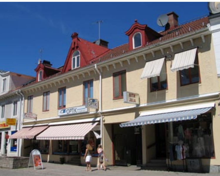
Bild 39. Tak på hus från 1898 där kupor och skorstenar bevarats medan den övriga taktäckningen bytts ut till betongpannor - 1 poäng. Foto Lotta Lamke.
