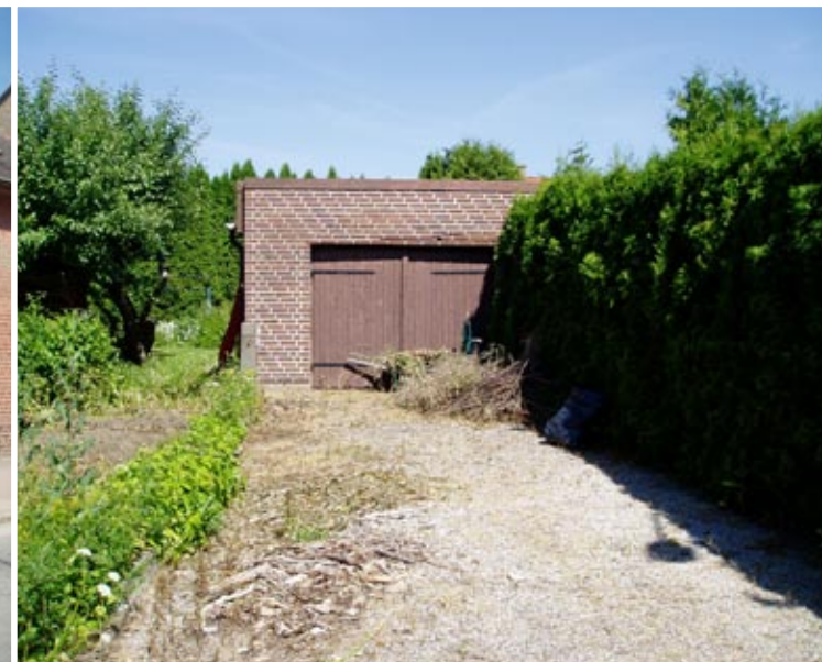
Bild 87. Komplementbyggnad i form av ett garage. Poängsätts byggnadsdel för byggnadsdel: Fasad 4 poäng och dörrar 2 poäng. Observera att taket inte syns och därmed inte skall bedömas. Sammanlagd poäng 6 av 6 möjliga. Efter omräkning enligt ovan nämnda skala ges byggnaden 2 poäng av 2 möjliga. Foto Adam Katzeff.
