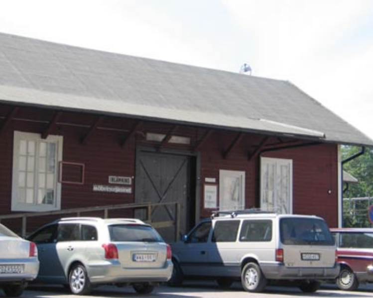
Bild 38. Icke ursprungligt, men anpassat papptak på magasinbyggnad från 1875 - 1 poäng. Foto Lotta Lamke.
