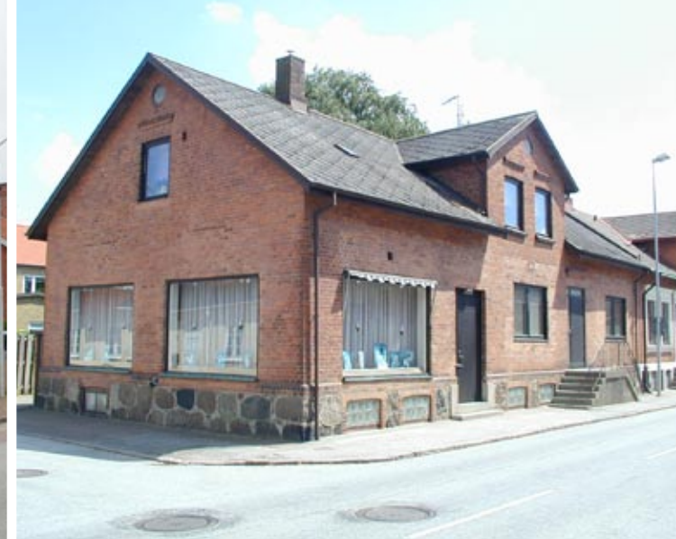
Bild 42. Eternitbelagt tak från tidigt 1900-tal, men icke ursprungligt då huset uppfördes redan 1894. Taket räknas därmed som förvanskning - 0 poäng. Foto Adam Katzeff.
