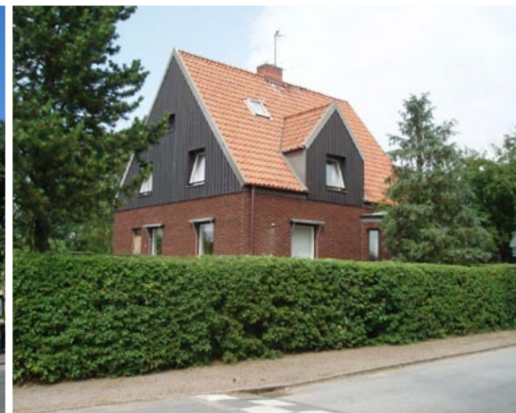
Bild 30. Fasad inklädd med tegel och panel på 1920-talshus - 0 poäng. Foto Adam Katzeff.
