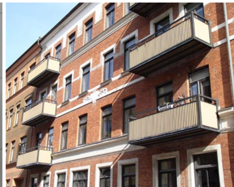
Bild 67. Förvanskade balkonger på hus från 1900-talets början (förstorad bottenplatta och nya fronter) - 0 poäng. Foto Paul Hansson.
