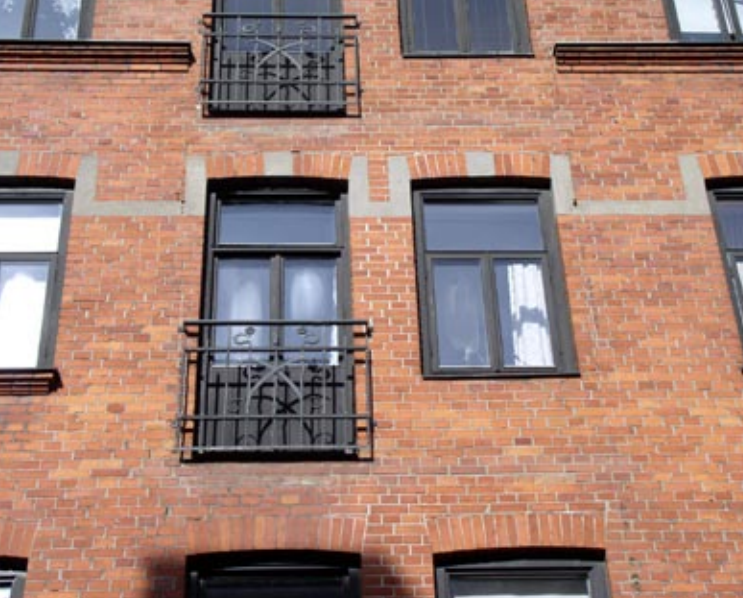
Bild 69. Borttagna balkonger med återanvända franska räcken på hus från ca 1905 - 0 poäng. Foto Paul Hansson.
