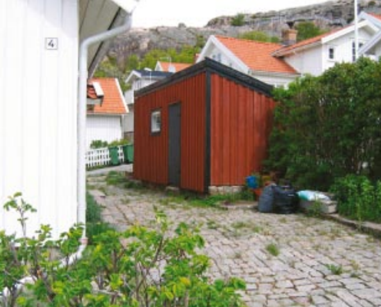
Bild 84. Komplementbyggnad i form av en mindre förvaringsbod. Foto Lars Rydbom.
