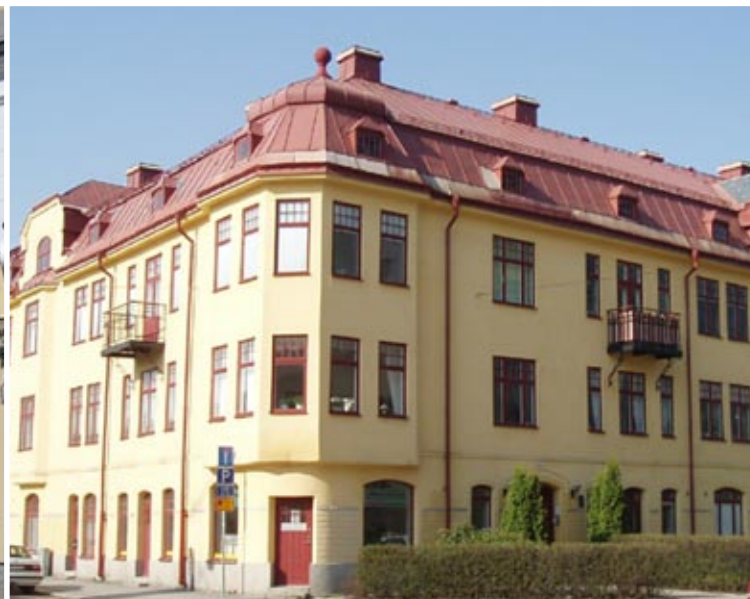
Bild 41. Tak där den ursprungliga skivplåten bytts ut mot bandplåt samt skorstenarna plåtats in, men där kupor och andra detaljer bevarats - 1 poäng. Foto Linda Gustafsson.
