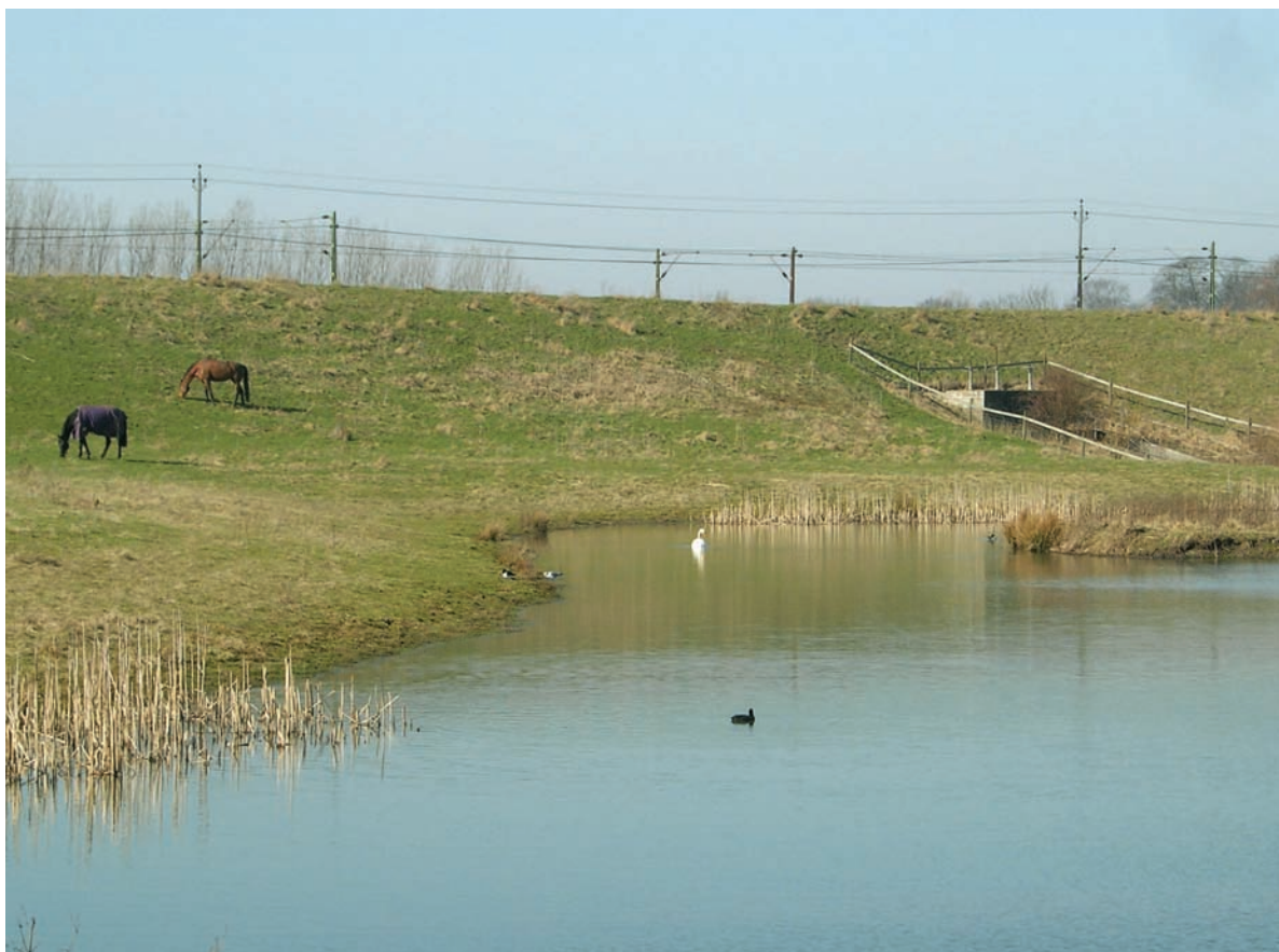
Vid Annetorp i norra Lund anlades 1999 en dagvattendamm. Bräddavloppet (t h) ligger högt över normalvattenytan, vilket ger en kraftigt utjämnande effekt vid störtregn. Samtidigt har dammen en tillräcklig storlek för att locka litet fågel; den ligger som en buffert mellan järnväg (kontaktledningarna anas) och bebyggelse bakom fotografen, och betet bidrar inte minst till att den utgör ett populärt inslag i miljön. Foto: Kristina Nolin 2007.
