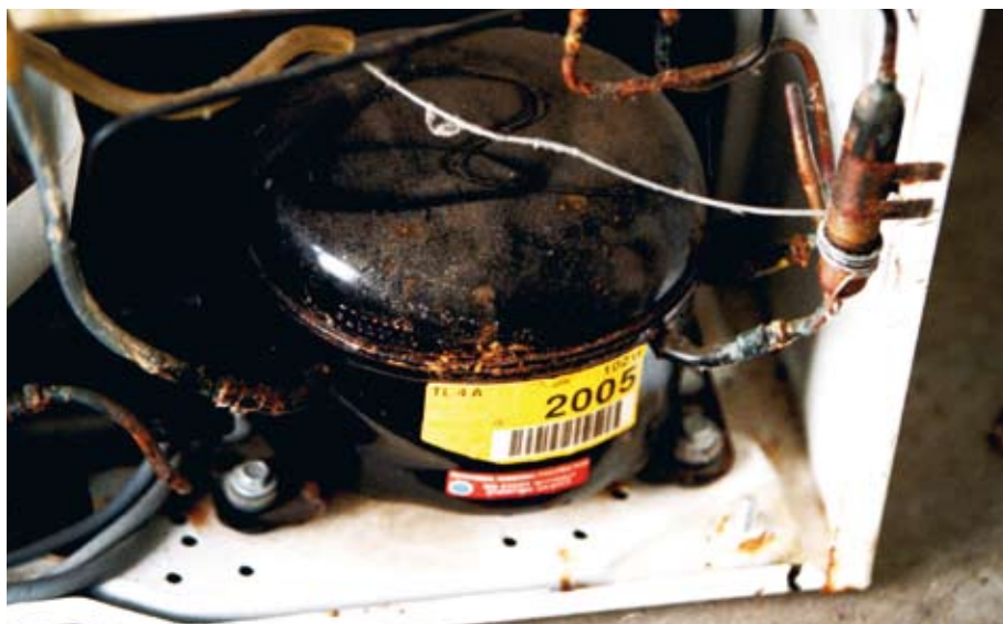
I gamla kylskåp kan det fortfarande vara freon (CFC eller HCFC) som används som köldmedium. Korrekt omhändertagande av uttjänta kylskåp är viktigt för att förhindra att de ozonnedbrytande ämnena släpps ut. Foto: Per Groth/Sydsvenskan Bild
