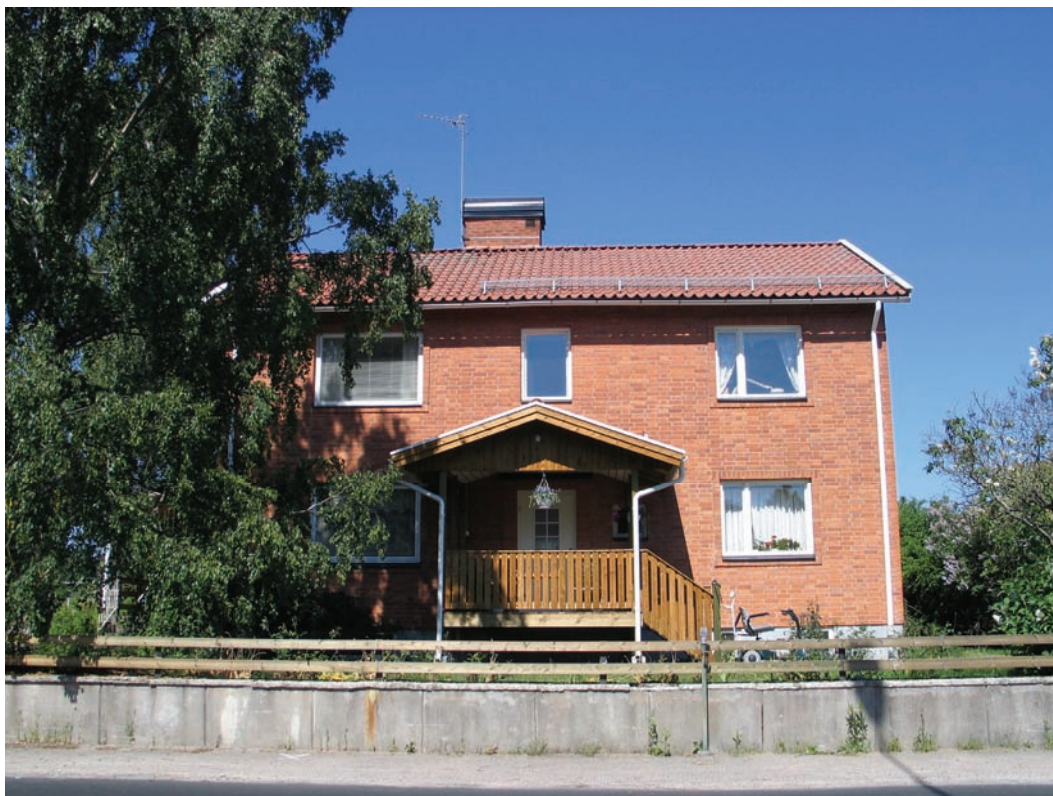
Bild 12. Tillbyggd veranda. Foto Lotta Lamke.
