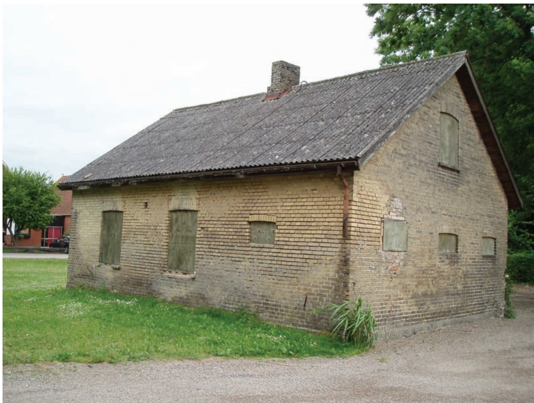
Bild 10. Hus med övertäckta fönster. Foto Adam Katzeff.
