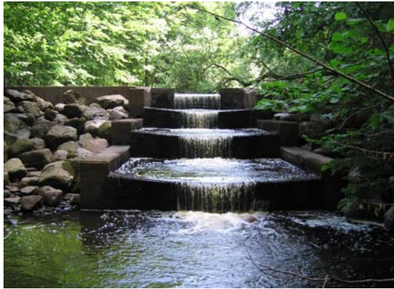
Vandringshinder 2 på A-sträcka 25 (Bilaga 1 och 2). Hindret är bedömt som partiellt, vid fotograferingstillfället var flödet lågt och hindret förmodligen inte passerbart. Foto Vibeke Lirås/Jan Grosen.
