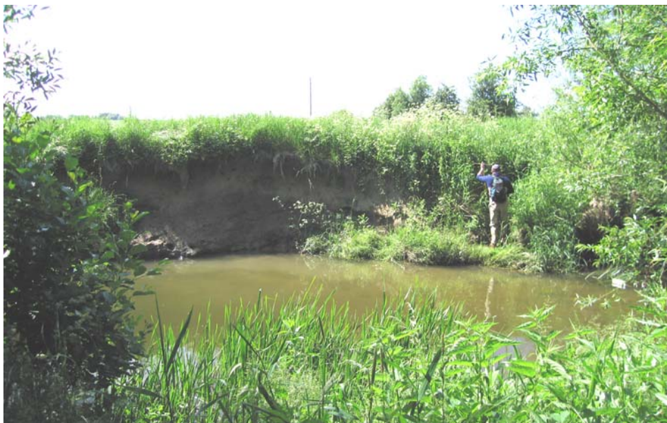
Skredärr med bohål på A-sträcka 46. Vattendraget har eroderat strandkanten och blottat finkornigt material. Foto: Vibeke Lirås
