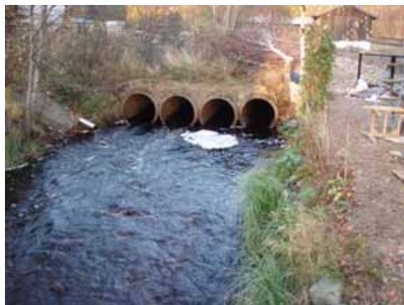
Figur 19. Vandringshinder nr 2. Vattendragssträcka 4 är kulverterad och rinner genom fyra trummor, ca 50 m långa. Foto: Jonas Johansson, Calluna AB.
