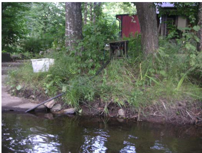
Vattenuttag som enligt markägaren inte används, A-sträcka 5.
