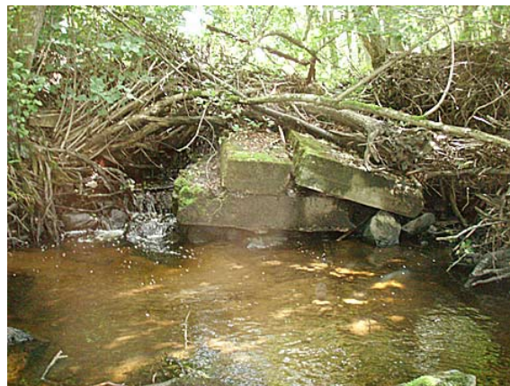
Figur 28. Vandringshinder nr 3 i slutet av vattendragssträcka 70. Foto: Jan Karlsson, Calluna AB.
